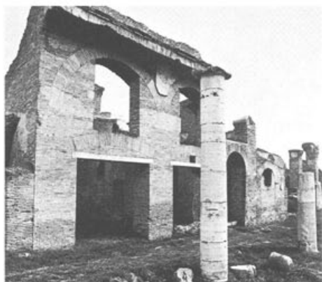
Abb. 13 Insula in Ostia aus der Kaiserzeit. Typisch für diese Bauten ist die Verwendung von Ziegelmauern und Entlastungsbögen. Das Erdgeschoss nahmen meist Läden ein; darüber befanden sich bis zu vier Geschosse mit Wohnungen. Das Baugesetz sah vor, dass die Höhe der Mietskasernen nicht mehr als 16–18 m betragen durfte.
