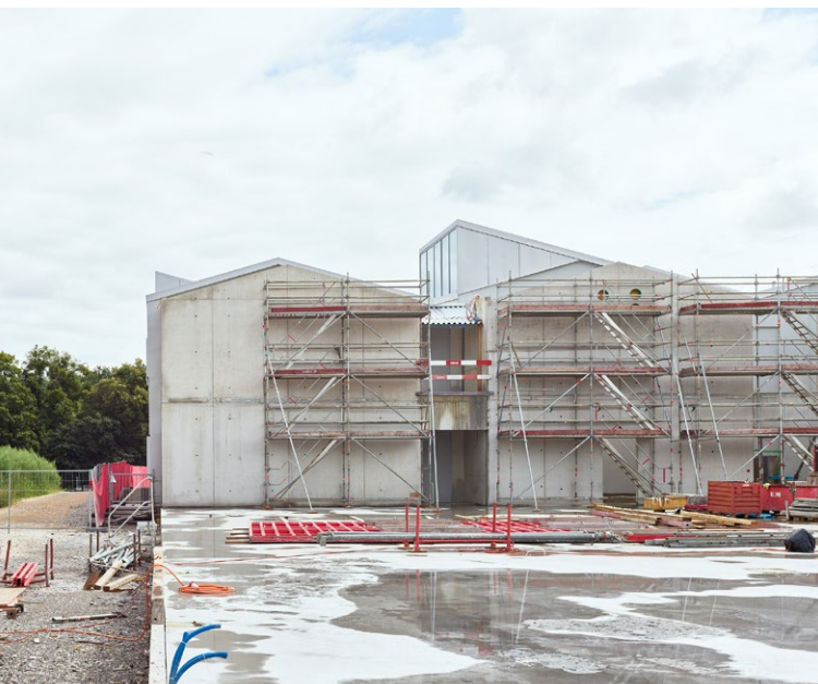
Das Sammlungszentrum wird nach dem Prinzip «Bauen über den Ruinen» erstellt. Möglichst ohne Bodeneingriffe und Grabungen wird direkt über einer Terrainaufschüttung und einer Betonplatte der Stahlbau errichtet. Im Bild die Betonplatte der zweiten Etappe, die zurzeit direkt an das bereits bestehende Gebäude angebaut wird. Foto Roman Weyeneth
