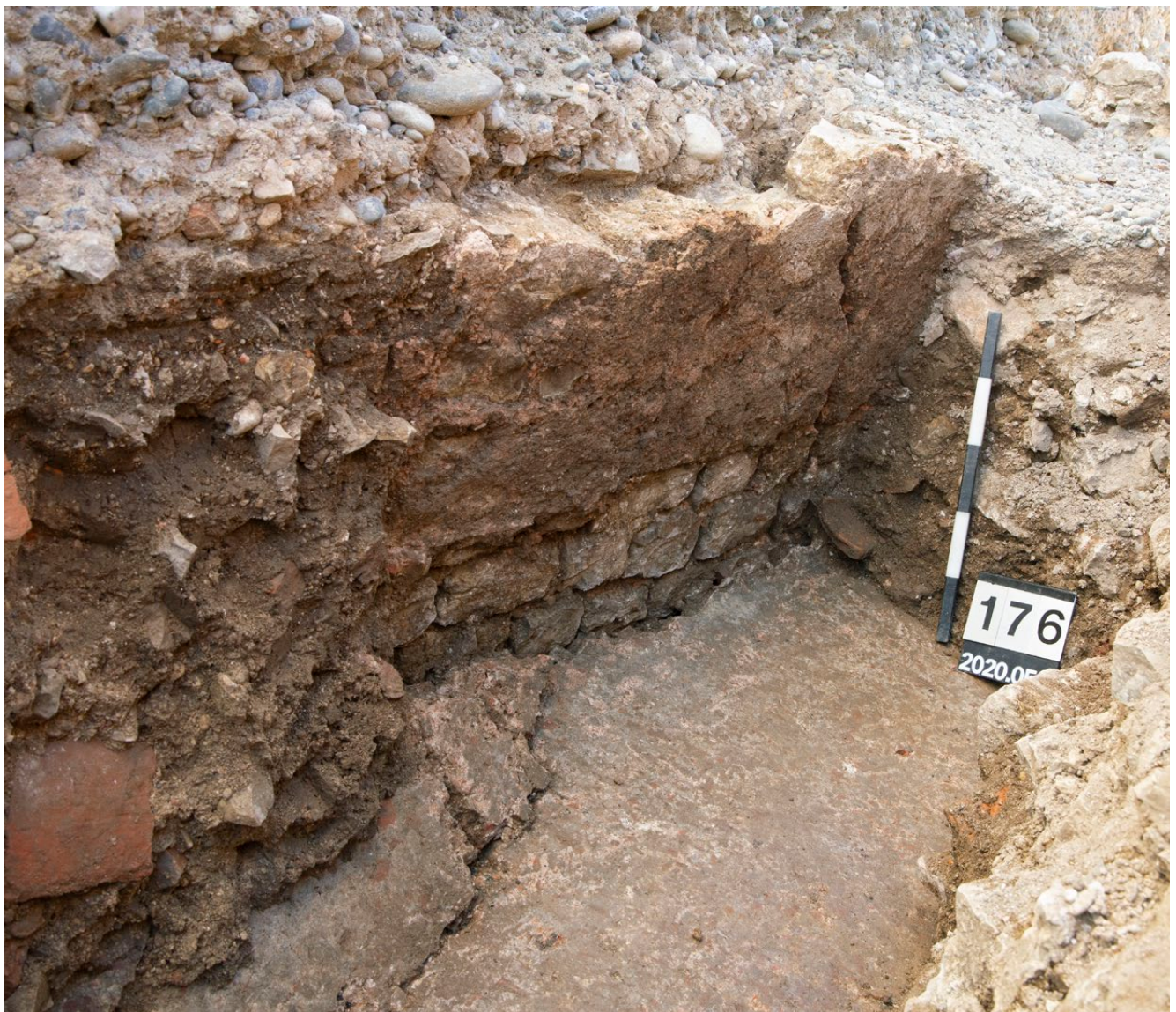
Grabung Giebenacherstrasse (2020.054): Eine Mauer in starker Schiefelage und ein abgesunkener Terrazzoboden zeugen von statischen Problemen in römischer Zeit. Foto Simon Friz
