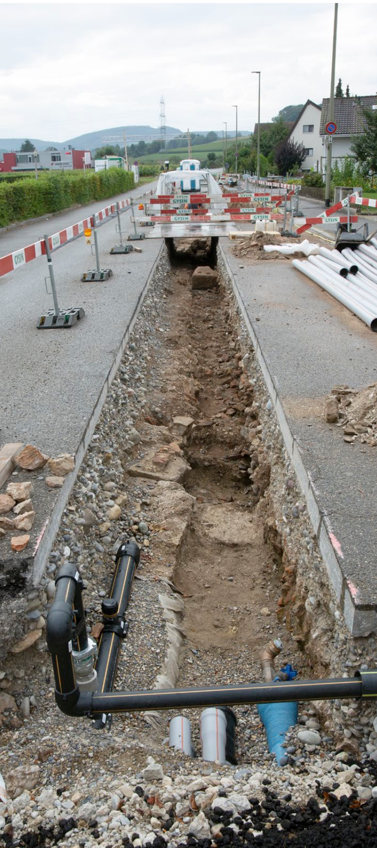
Grabung Giebenacherstrasse (2020.054): Ein Teil des ausgegrabenen Leitungsgrabens für die Gas- (links) und Wasserleitung (rechts) mit den teils abgebauten Mauern und Schuttschichten. Foto Cédric Grezet
