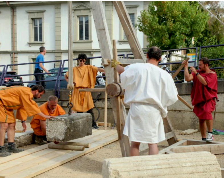
Versetzen des Steinblocks mithilfe einer Hebeklaue (Wolf) aus Eisen: Der Quader wird auf Holzrollen gesetzt, damit er ohne grossen Kraftaufwand zur Seite geschoben werden kann.
