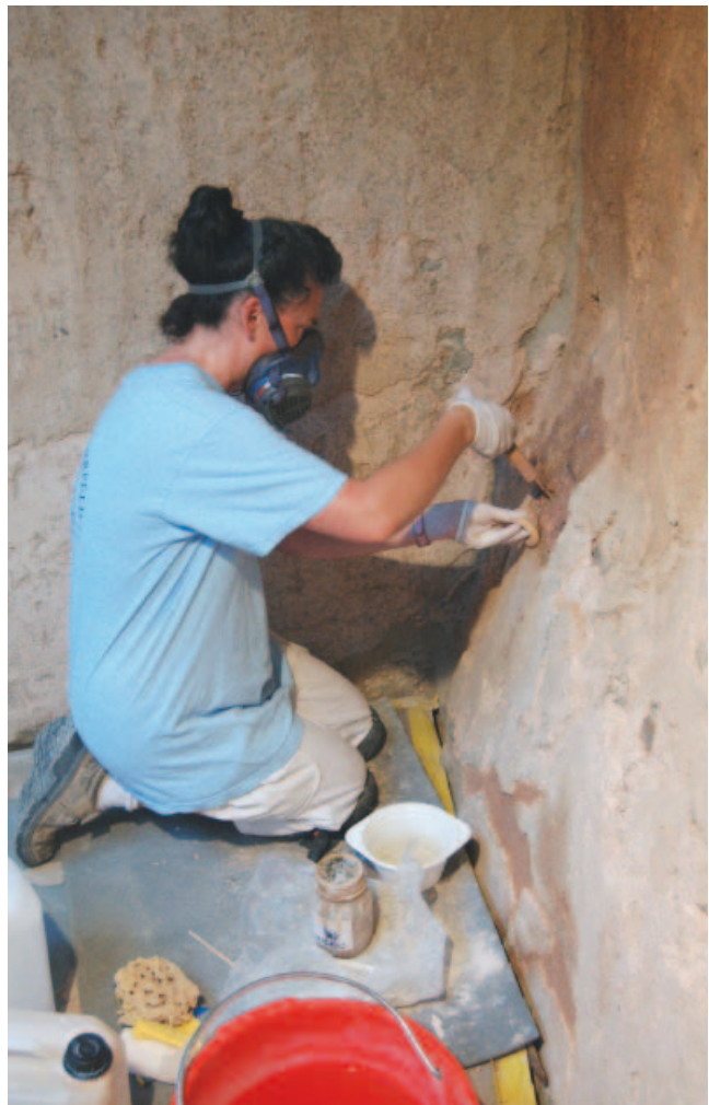
Die Spezialistin für Wandmalerei restaurierungen Susanna Sbaraglia befestigt den fragilen Verputz mit Injektionsmörtel. Foto André Zehrfeld
