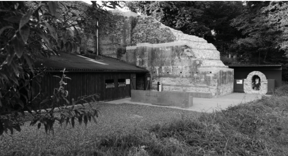
Die Brotbackstube am Fuss der Schönbühlstützmauer nach sanfter Renovation und Umgestaltung (Foto Susanne Schenker)
