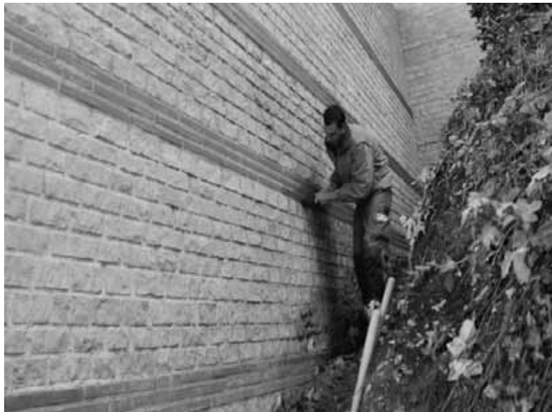
Die hoch aufgemauerte moderne Mauerschale an der Nordseite des Stützpfilers wurde von Dominik Fux (Firma Markus Fux AG) fertiggestellt. (Foto Donald F. Offers)
