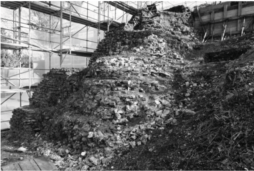
Die losen Kalkbruchsteine des Stützpfie- lers müssen für die Dokumentation des erhaltenen römischen Mauerkerns entfernt werden. (Foto Hanspeter Bauhofer)
