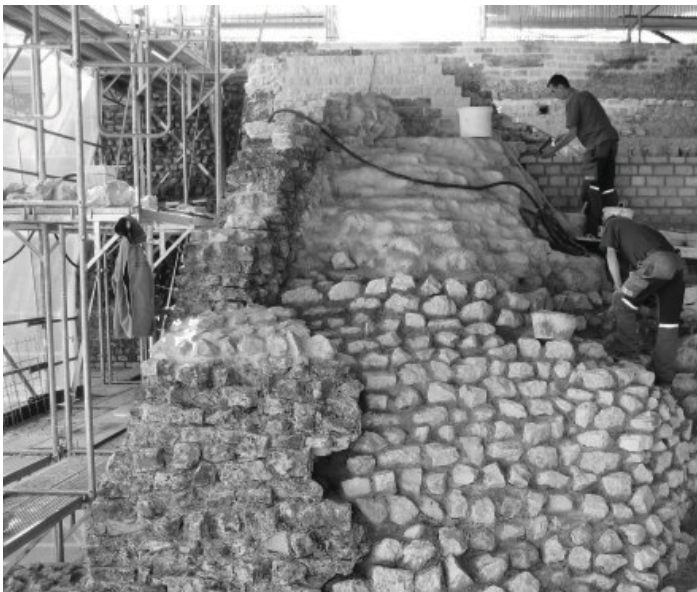
Die Kalkbruchstein-Schroppen wurden als Schutzschicht auf das originale römische Mauerwerk des Stützpfilers aufgemauert. (Foto Donald F. Offers)
