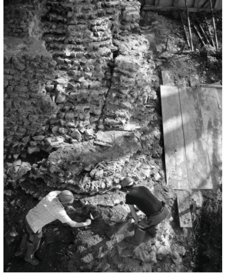
Vor der Restaurierung des Stützpfeilers muss das antike Mauerwerk von Humus und losen Steinen gereinigt werden. Im Bild Dominik Fux und Mladen Puklin beim Entfernen von losen Kalksteinen. (Foto Donald F. Offers)
