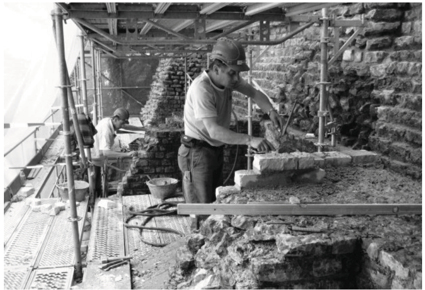
Aufmauerarbeiten an der Stützmauer oberhalb der Brotbackstube. (Foto Donald F. Offers)
