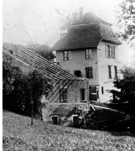
Der um 1669 errichtete, heute in die Villa Clavel integrierte Wachturm. (Foto Privatarchiv Jakob Frey-Clavel)
