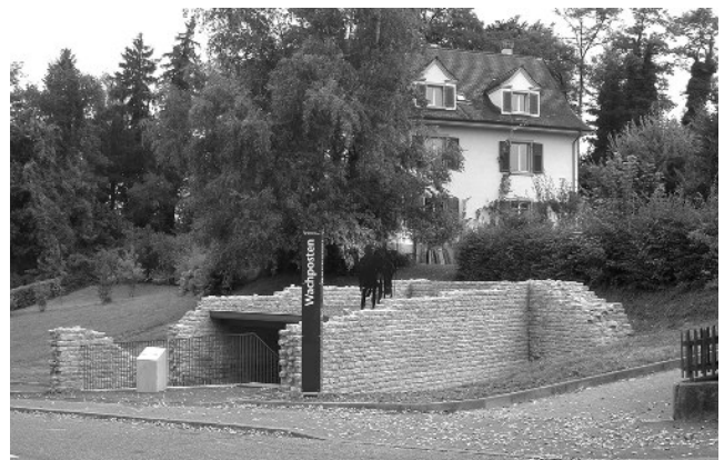
«Bäckerei und Wachposten» nach Abschluss der Sanierungsarbeiten: Neu konserviert, umgestaltet und mit neuem Schutzdach ist die Anlage wieder eine besuchenswerte Attraktion im Freilichtmuseum. (Foto Ursi Schild)
