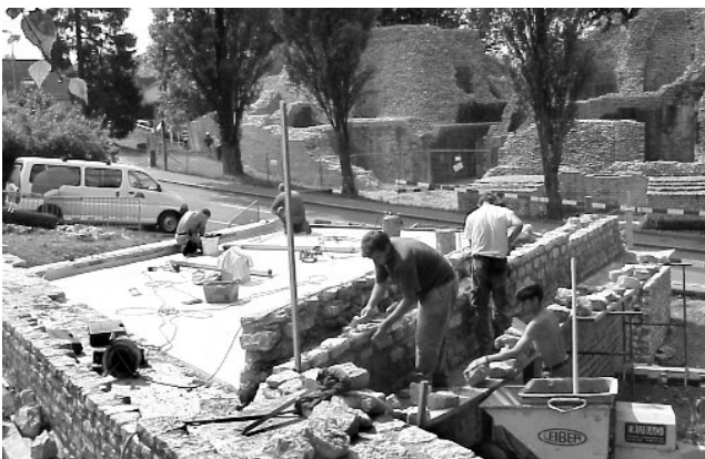
Das Stockwerk über der «Bäckerei»: Auf der Höhe des antiken Stockwerkbodens wurde eine Stahldecke eingezogen und die Maueransätze der oberen Etage modern aufgemauert. (Foto Donald F. Offers)
