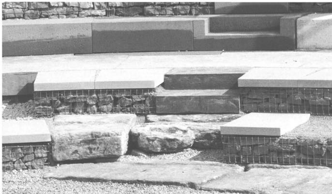
Detail der geplanten Sitzstufenrekonstruktion. Der Drahtgitterkorb weist die Konstruktion klar als moderne Wiederherstellung aus. Die Sandsteinplatten ermöglichen ein einfaches Begehen und verbessern die Nutzung in Zusammenhang mit Schauspiel- und Konzertaufführungen.
