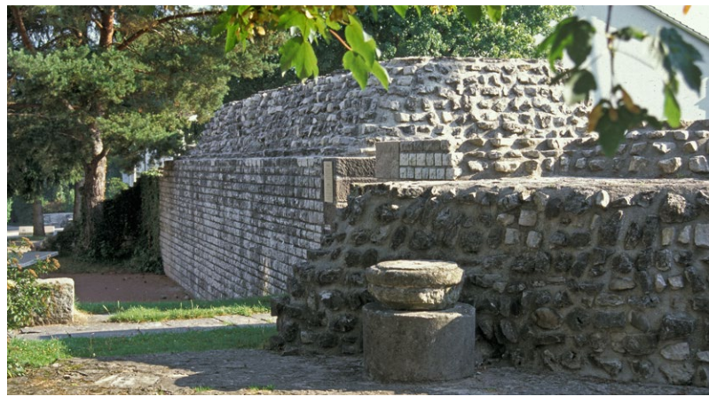
Noch heute stehen imposante Teile der Kaiseraugster Kastellmauer im Gelände.
