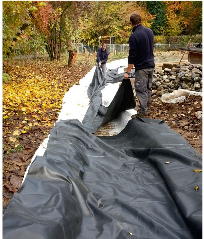
Zum Schutz vor Scherkräften und Wurzeln wurde die Sohle des Bachbetts mit einer Kautschukfolie ausgekleidet. Foto Claudio Gianini
