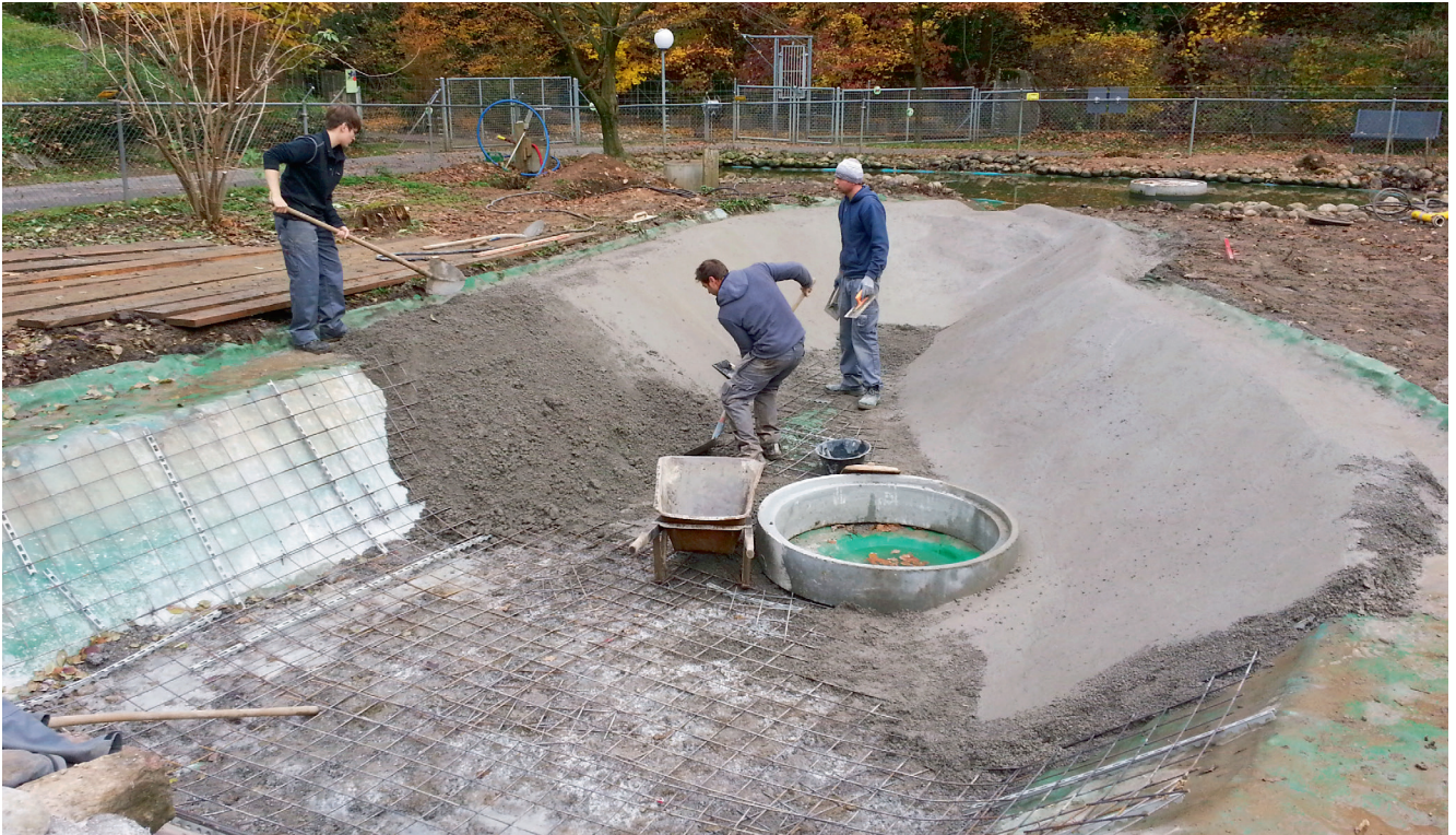
Die Weiher wurden vor dem Betonieren mit Armierungsnetzen ausgekleidet, um dem Beton an den steilen Wänden Halt zu geben und Spannungsrissen vorzubeugen. Foto Claudio Gianini
