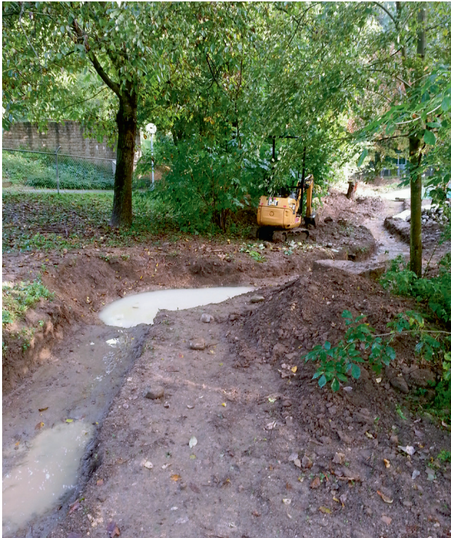
Das Bachbett des späteren Bachs wurde mit einem Kleinbagger ausgehoben. Foto Claudio Gianini
