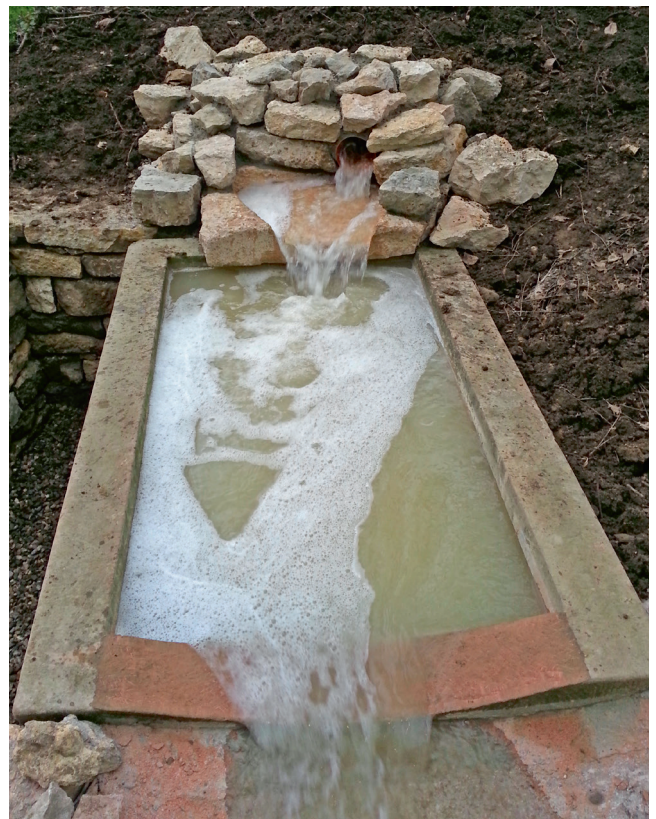
Am oberen Ende der Teichanlage gelangt das Wasser über eine im Boden verlegte Leitung in den aus Kalksteinen und einem Sandsteinbecken gestalteten Quellbereich. Foto Claudio Gianini
