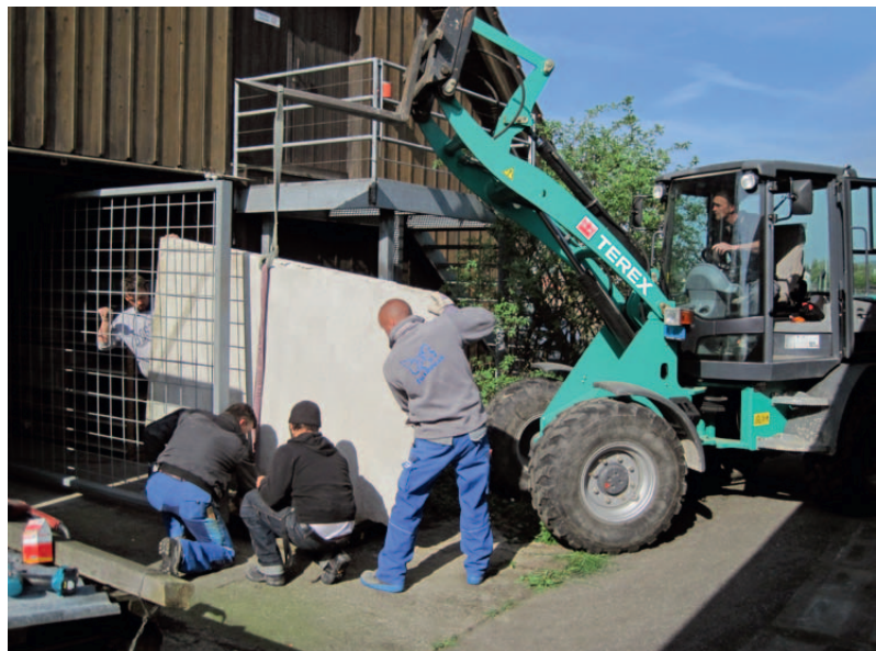
Demontage des Mosaiks beim Forumsschopf 2011: Montage des demontierten Mosaiks an das Lagergestell im Mosaikendepot. Zusammenarbeit mit dem technischen Dienst und der Firma Fux AG, Augst. Foto Donald F. Offers
