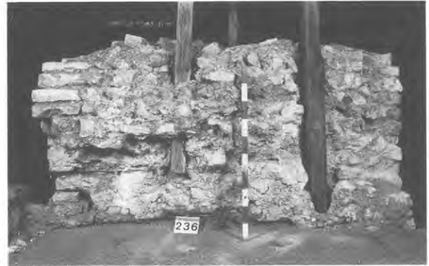
Abb. 148 Augst BL, Theater-NW-Ecke 1986/87. Aufgehender Teil von Strebepfeiler 2: Blick von Ost auf den Mauerkern mit antiker Abbruchkante. Unten die Oberfläche der drittobersten Fundament-Quaderlage, darüber im Mauerkern die Negative zweier eingemauerter, vertikaler Holzbalken (im unteren Bild mit modernen Balken markiert). Links unten ist der Abdruck eines Sandsteinquaders auf der Mörteloberfläche zu erkennen. M. 1:30.
