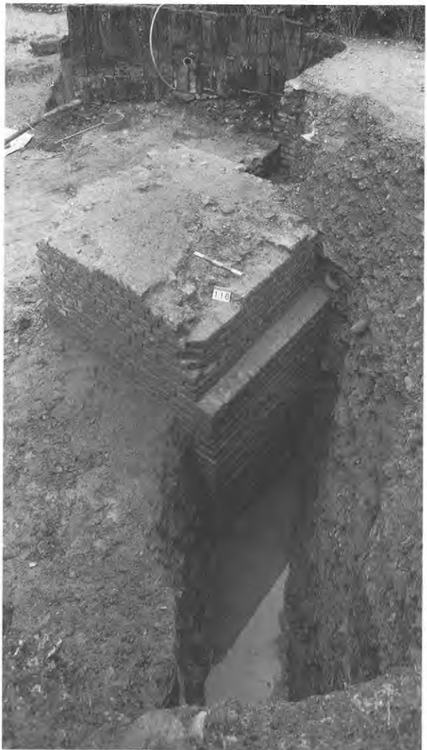
Abb. 146 Augst BL, Theater-NW-Ecke 1986/87. Strebepfeiler 2 in Schnitt 2 während der Freilegung. Die linke, schon zur Hälfte entfernte Sondierschnitt-Wand entspricht dem Profil 6 (Abb. 123). Blick von Nordwest.
