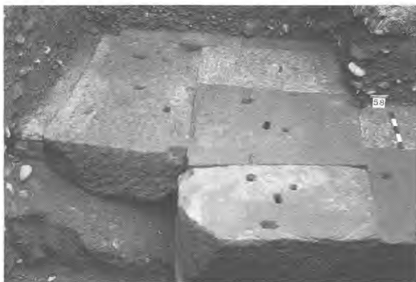
Abb. 137 Augst BL, Theater-NW-Ecke 1986/87. Ausschnitt aus Fundamentzone 5 (Abb. 127, Feld H6), Oberfläche der drittobersten Quader-Lage (die beiden obersten Lagen sind antik geplündert). Beachte links die bogenförmigen Meisselfurchen an der Quader-Stirnseite und links am Bildrand das kleinteilige Handquader-Mauerwerk von Fundamentzone 11. Die Löcher auf den Quader-Oberflächen sind nur zum Teil deutbar (vgl. unten, Abb. 141). Blick von Nord.
