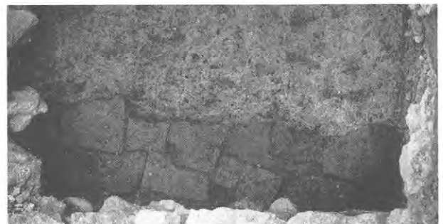
Abb. 10 Ziegelfundamentation für die Lehmstampfwand W21.
