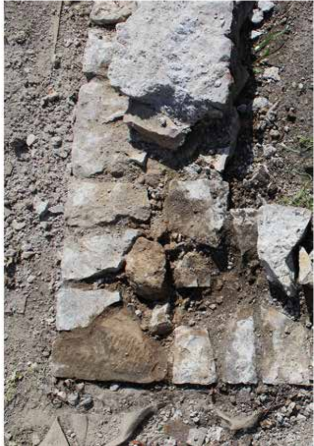
Abb. 34: Augst BL, Vierecktempel Schönbühl II (Intervention 2017.062). Links: abgelöste Mauerstücke der Altrestaurierung; rechts: nach Entfernen der Altrestaurierung, humoses Material auf dem Originalmauerwerk.
