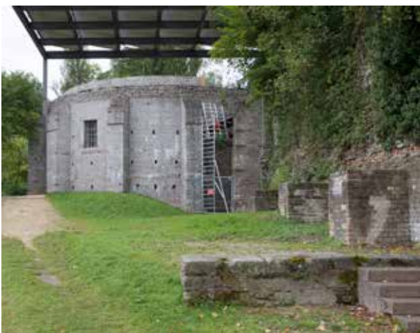
Abb. 60: Augst BL, Curia (Intervention 2017.066). Blick von Nordwesten auf die zu dokumentierende Curia. Hierfür musste auf einem mobilen Gerüst gearbeitet werden.
