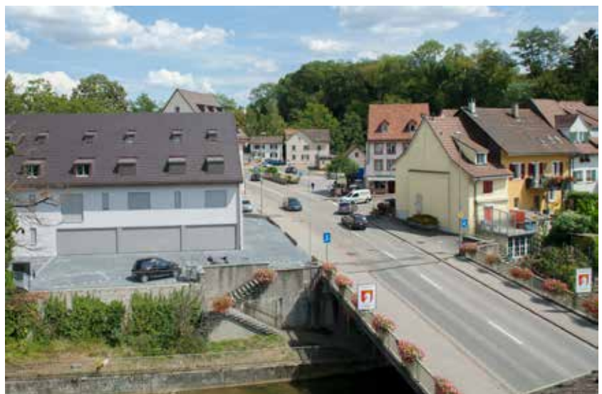
Abb. 27: Augst BL, Hauptstrasse 33 (Baubegleitung 2017.061). Blick nach Osten im Sommer 2017: Der ehemals an der rechten Strassenseite stehende Polizeiposten mit dem Baslerstab an der Fassade und das dahinterliegende Gebäude fielen der neuen Strasse mit Brücke zum Opfer. Links der Neubau Hauptstrasse 33 und dahinter unverändert das Zollhaus.
