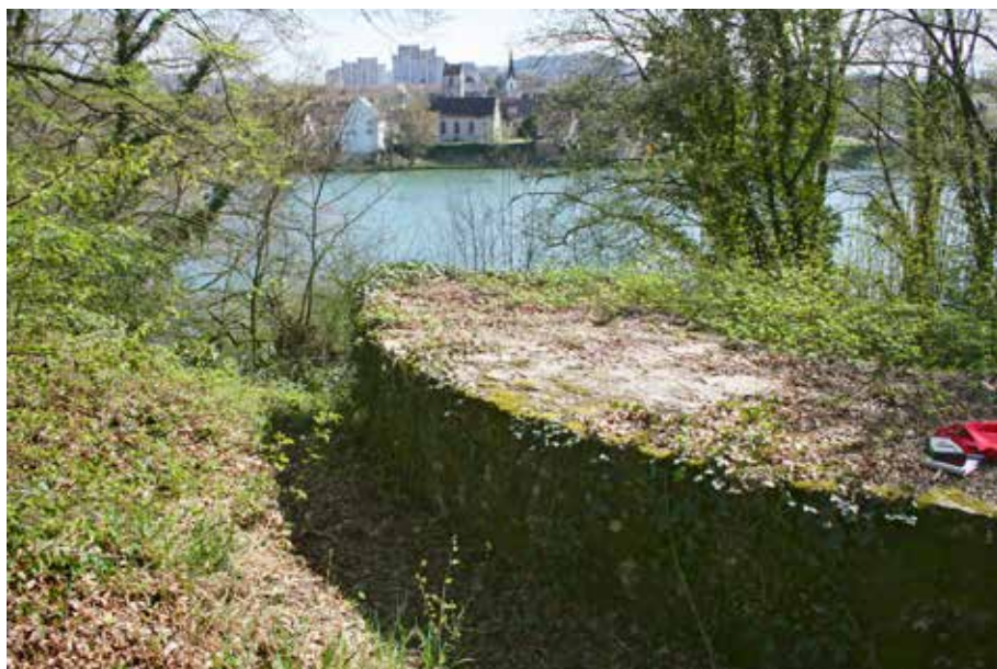
Abb. 17: Wyhlen (D), römischer Brückenkopf (2017.005). Die konservierten Reste des westlichen Turms von Norden. In der Bildmitte ist am anderen Rheinufer die Kirche St. Gallus in Kaiseraugst AG sichtbar.
