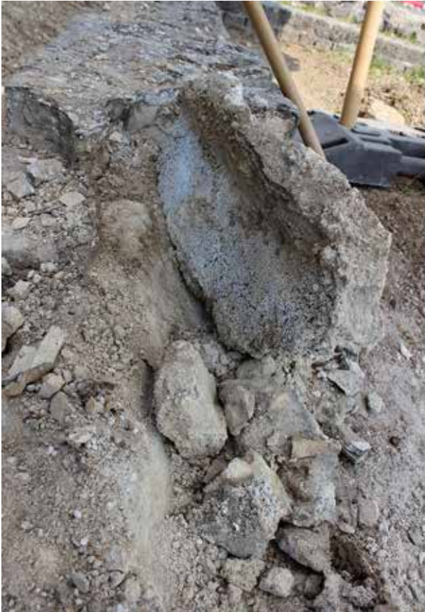
Abb. 34: Augst BL, Vierecktempel Schönbühl II (Intervention 2017.062). Links: abgelöste Mauerstücke der Altrestaurierung; rechts: nach Entfernen der Altrestaurierung, humoses Material auf dem Originalmauerwerk.
