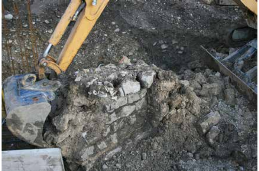
Abb. 83: Augst BL, EFH Sichenstrasse (Grabung 2016.065). Der Eckbereich MR 1/MR 3 wird mit dem Bagger zerstört. Blick von Westen.
