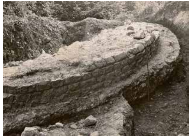
Abb. 6: Wyhlen (D). Brückenkopf. Grabungen R. Laur-Belart/F. Kuhn 1933. Turm III von Osten. Deutlich erkennbar sind das stark vorspringende Fundament und die abgeschrägten Handquader der Fasse.
