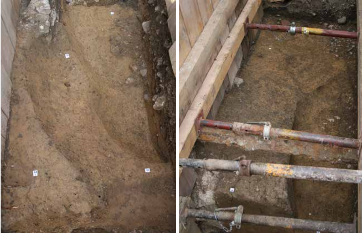
Abb. 41: Augst BL, Rheinstrasse (Grabung 2016.055). Negative der mit Abraum von Gräbern verfüllten Gruben, Mulden und Gräben. Blick von Osten (links) und von Nordosten (rechts).
