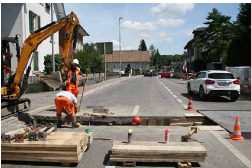
Abb. 8: Augst BL, Rheinstrasse (Grabung 2016.055). Querung der Rheinstrasse für die neue Wasserleitung. Rechts unter der Eisenplatte liegen die Gräber 9–12 und 16. Blick von Westen.
