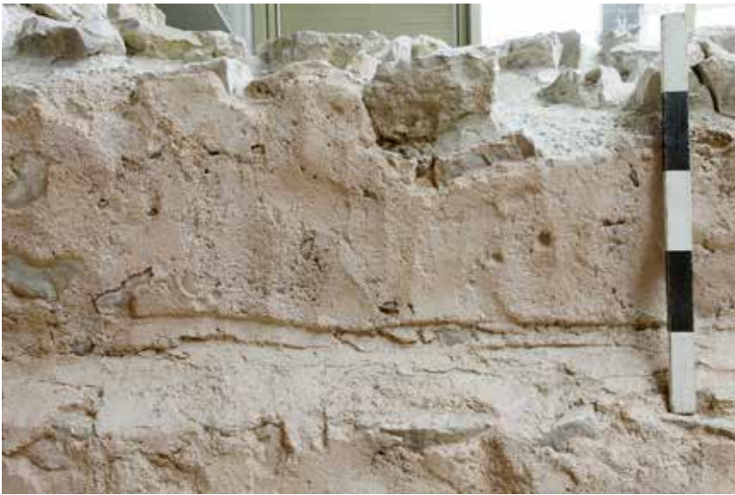
Abb. 39: Kaiseraugst AG, Nachuntersuchungen Schmidmatt (Dokumentation 2016.005). Haus 2, Raum 10: Detail von Mauer MR 28, obere Fase mit Grobverputz und Kellenstrichen. Blick von Westen.
