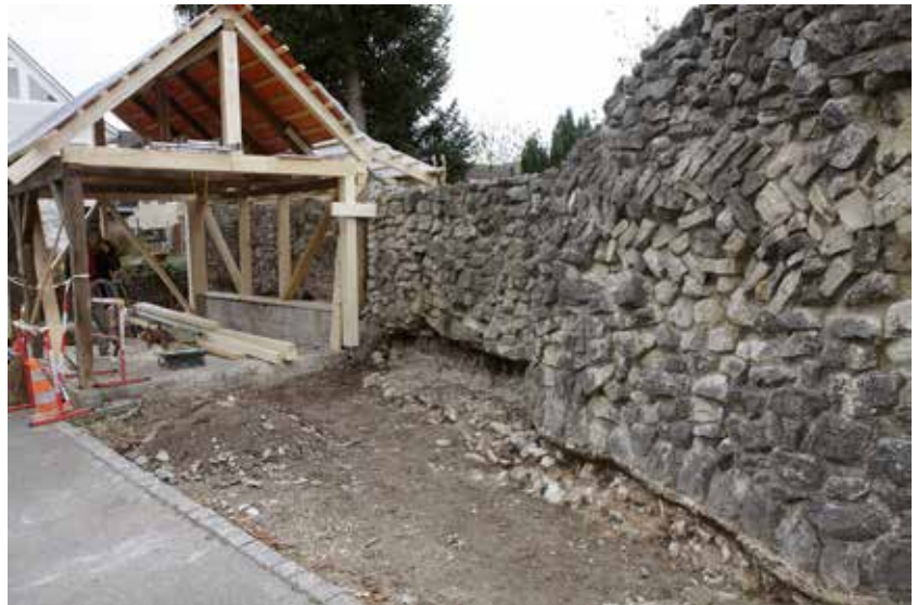
Abb. 59: Kaiseraugst AG, Sanierung Geräteschuppen Heidemurweg (Baubegleitung 2016.008). Situation im Jahr 2016 während des Umbaus. Die Rabatte östlich des Schopfs wurde entfernt. Die moderne Mauerschale überragt den originalen Mauerkern im Fussbereich. Blick von Südosten.
