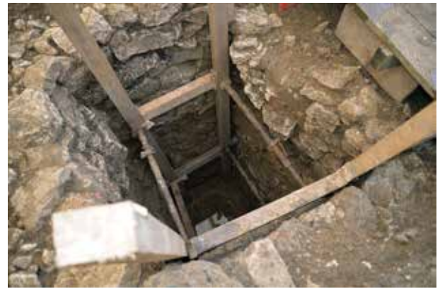
Abb. 11: Frick AG, Günsacker 2013–2014 (Fig. 013.02) – Schacht Pos. 18.19. Blick in den Schacht Pos. 18.19 (Zustand im November 2013).
