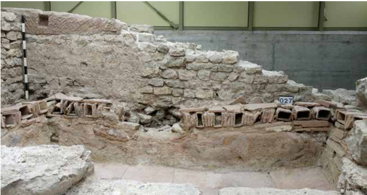
Abb. 47: Kaiseraugst AG, Nachuntersuchungen Schmidmatt (Dokumentation 2016.005). Haus 2, Raum 11: Mauer MR 40 im Hintergrund mit weissem Kalkverputz, der hinter Mauer MR 35 (links) zieht. Das Fundament ist mittig sichtbar hinter den tubuli der Heizanlage. Blick von Norden.
