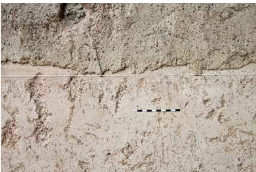
Abb. 37: Kaiseraugst AG, Nachuntersuchungen Schmidmatt (Dokumentation 2016.005). Haus 2, Raum 10: Detail der Feinputzschicht unter dem Grobverputz am nördlichen Ende von Mauer MR 7. Blick von Osten.
