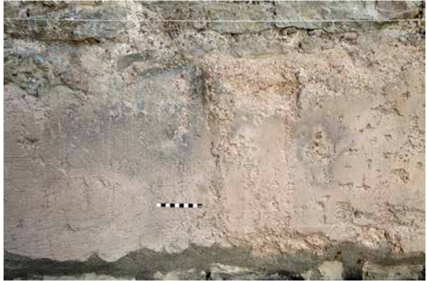
Abb. 42: Kaiseraugst AG, Nachuntersuchungen Schmidmatt (Dokumentation 2016.005). Haus 2, Raum 10: Detail von Mauer MR 7 mit Wechsel im Erscheinungsbild des Verputzes. Blick von Osten.
