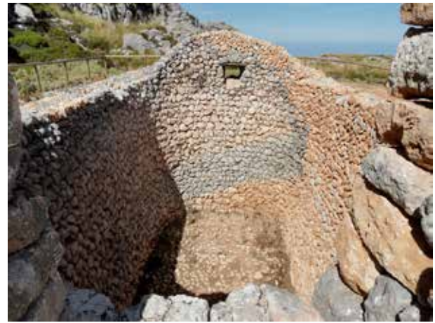
Abb. 15: (Früh-)nezeitliche und moderne Baubefunde, die nachweislich zur Bevorratung von Schnee und Eis dienten. Blick in eine frühnezeitliche casa de neu an der Nordwestflanke der Puig d'En Galileu (Mallorca, E).
