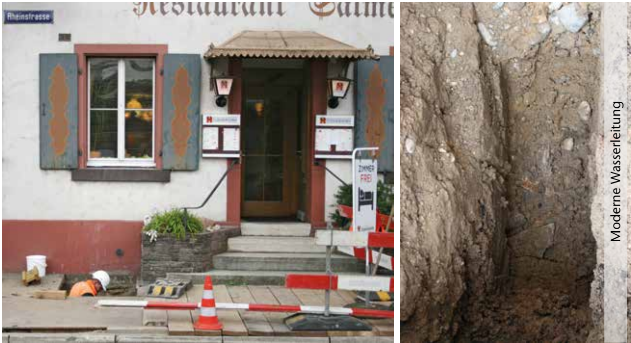
Abb. 17: Augst BL, Rheinstrasse (Grabung 2016.055). Links der Graben für den Hausanschluss vor dem Restaurant Salmeck mit dem Grabungstechniker Fredy von Wyl bei der Arbeit. Rechts Blick in den Graben unmittelbar nach der Auffindung des Bleisargs. Zu erkennen sind Boden und Seitenwand des Sargs und die beiden Oberschenkelknochen der bestatteten Person. Rechts am Bildrand die Wasserleitung, deren geplante Erneuerung zum Auffinden des Bleisargs führte.
