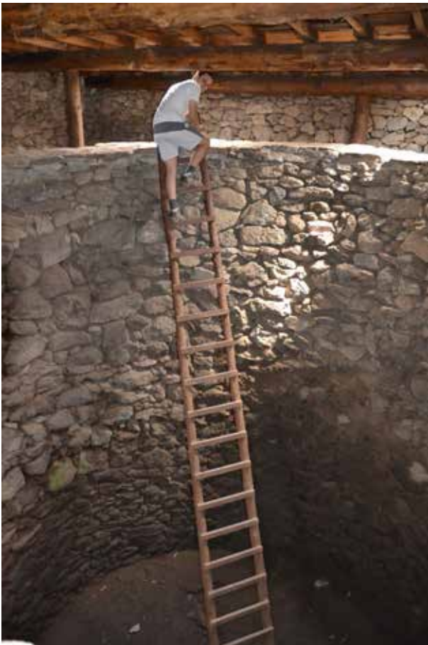
Abb. 16: (Früh-)nezeitliche und moderne Baubefunde, die nachweislich zur Bevorratung von Schnee und Eis dienen. Blick in den frühnezeitlichen pozzo de la nieve von Casillas (E).
