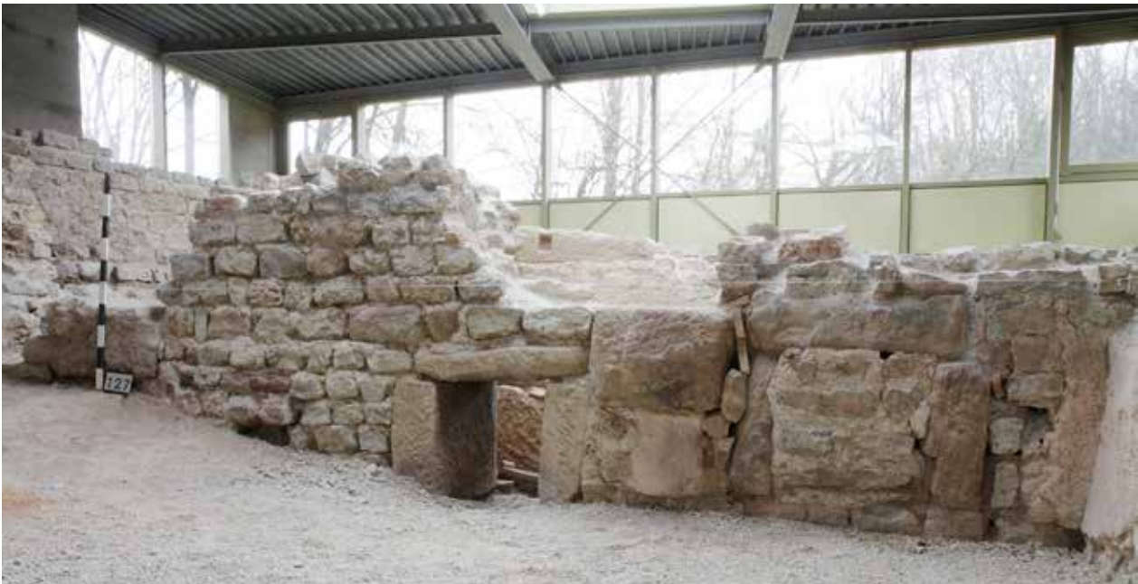
Abb. 44: Kaiseraugst AG, Nachuntersuchungen Schmidmatt (Dokumentation 2016.005). Haus 2, Raum 10: südliche Hallenwand mit den nachträglich eingebauten Präfürmien MR 76 und MR 78. Siehe auch Abb. 45. Blick von Nordwesten.
