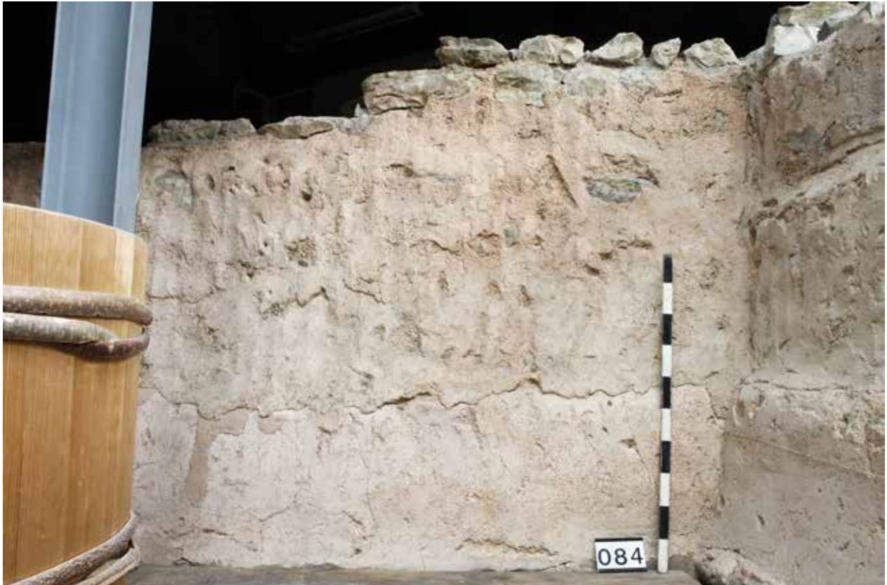
Abb. 38: Kaiseraugst AG, Nachuntersuchungen Schmidmatt (Dokumentation 2016.005). Haus 2, Raum 10: Detail von Mauer MR 27 mit Endverputz (unten), darin Flickstellen (links) und darüberliegender Grobverputz (oben). Blick von Süden.
