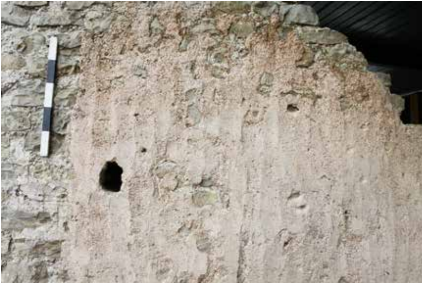
Abb. 36: Kaiseraugst AG, Nachuntersuchungen Schmidmatt (Dokumentation 2016.005). Haus 2, Raum 10: Detail des Grobverputzes am nördlichen Ende von Mauer MR 7. Blick von Osten.
