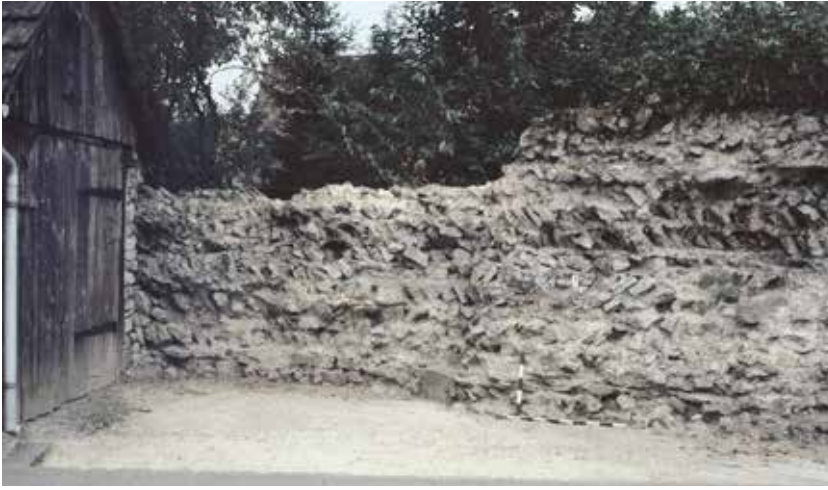
Abb. 56: Kaiseraugst AG, Sanierung Geräteschuppen Heidemurweg (Baubegleitung 2016.008). Situation bei der Freilegung im Jahr 1985. Die Schräglagen im Mauer Kern sind deutlich erkennbar. Blick von Süden.
