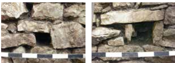
Abb. 7: Kaiseraugst AG, Auf der Wacht (Grabung 2011–2013.001). Schacht MR 6/MR 32 (Zustand im März 2016). Mit modernen Holzbalken markierte Balkennegative in MR 6 und Detailaufnahmen der beiden Balkennegative (vgl. dazu auch Abb. 9).
