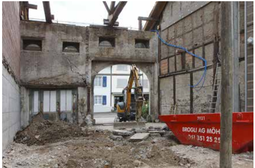
Abb. 24: Kaiseraugst AG, Umbau MFH Dorfstrasse 41/43 (Grabung 2016.003). Blick von Norden in den «ausgehöhlten» Ökonomieteil (Dorfstrasse 43) während des Abspitzens der Bodenplatte. Rechts davon die Fachwerkwand des Wohntrakts (Dorfstrasse 41).
