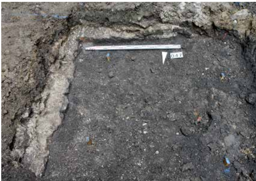
Abb. 27: Kaiseraugst AG, Umbau MFH Dorfstrasse 41/43 (Grabung 2016.003). Baugrube für ein zukünftiges Stützpfilerfundament, in der eine Raumecke mit den Mauern MR 6 (links) und MR 7 (oben) knapp angeschnitten wurde. Blick von Norden.
