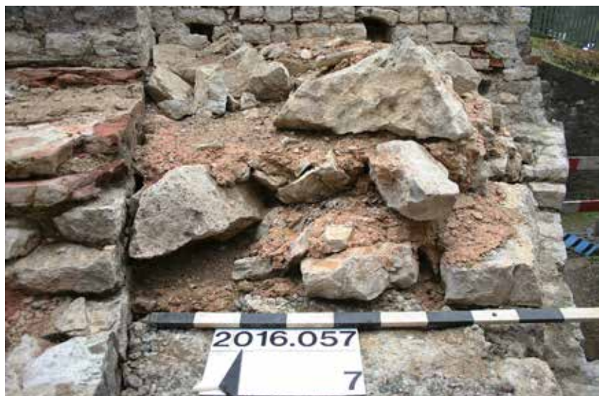
Abb. 56: Augst BL, Stützmauern Basilica (Intervention 2016.057). Nordwestliche Kanalwange MR 28 der Kloake. Auf der Kämpferlinie (rechts im Bild) liegen einige leicht abgeschrägte Kalksteine des Widerlagers zum Bogen. Darüber finden sich grössere, stärker abgeschrägte Kalksteine, die als Widerlager für einen zweiten Bogen dienen. Blick von Süden.
