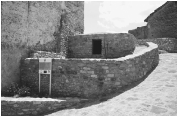
Abb. 14: (Früh-)nezeitliche und moderne Baubefunde, die nachweislich zur Bevorratung von Schnee und Eis dienten. Die frühnezeitliche nevera in Forcall (E) (Zustand nach der Restaurierung im Jahr 1997).
