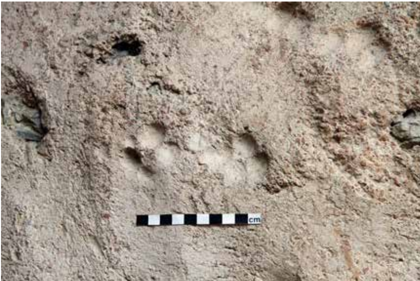
Abb. 40: Kaiseraugst AG, Nachuntersuchungen Schmidmatt (Dokumentation 2016.005). Haus 2, Raum 10: Detail von Mauer MR 27 mit Fingerabdrücken im Grobverputz. Blick von Süden.
