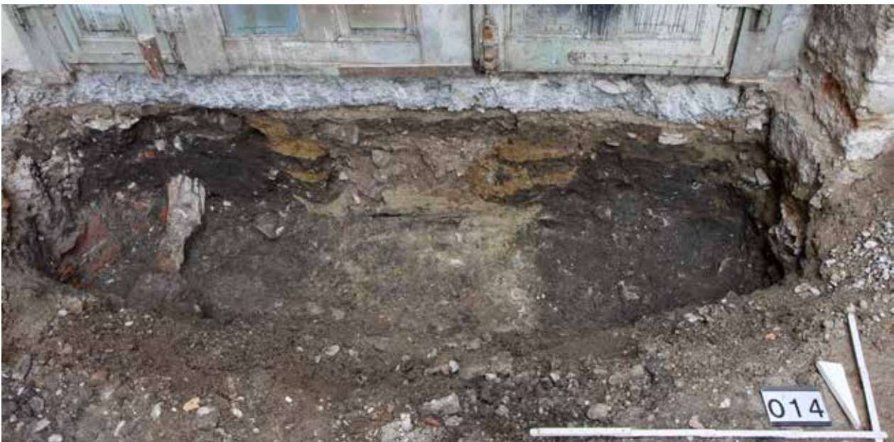
Abb. 32: Kaiseraugst AG, Umbau MFH Dorfstrasse 41/43 (Grabung 2016.003). Blick von Norden auf den hochkant stehenden roten Sandstein eines möglichen Kanals MR 1 (links im Bild) und auf die nicht wasserführende kanalähnliche Struktur (Bildmitte).
