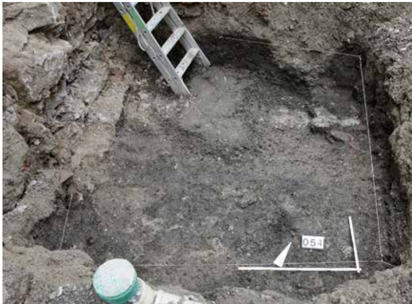
Abb. 28: Kaiseraugst AG, Umbau MFH Dorfstrasse 41/43 (Grabung 2016.003): Baugrube für den zukünftigen Liftschacht. Oben rechts die spärlichen Reste von Mauer MR 8. Blick von Südosten.
