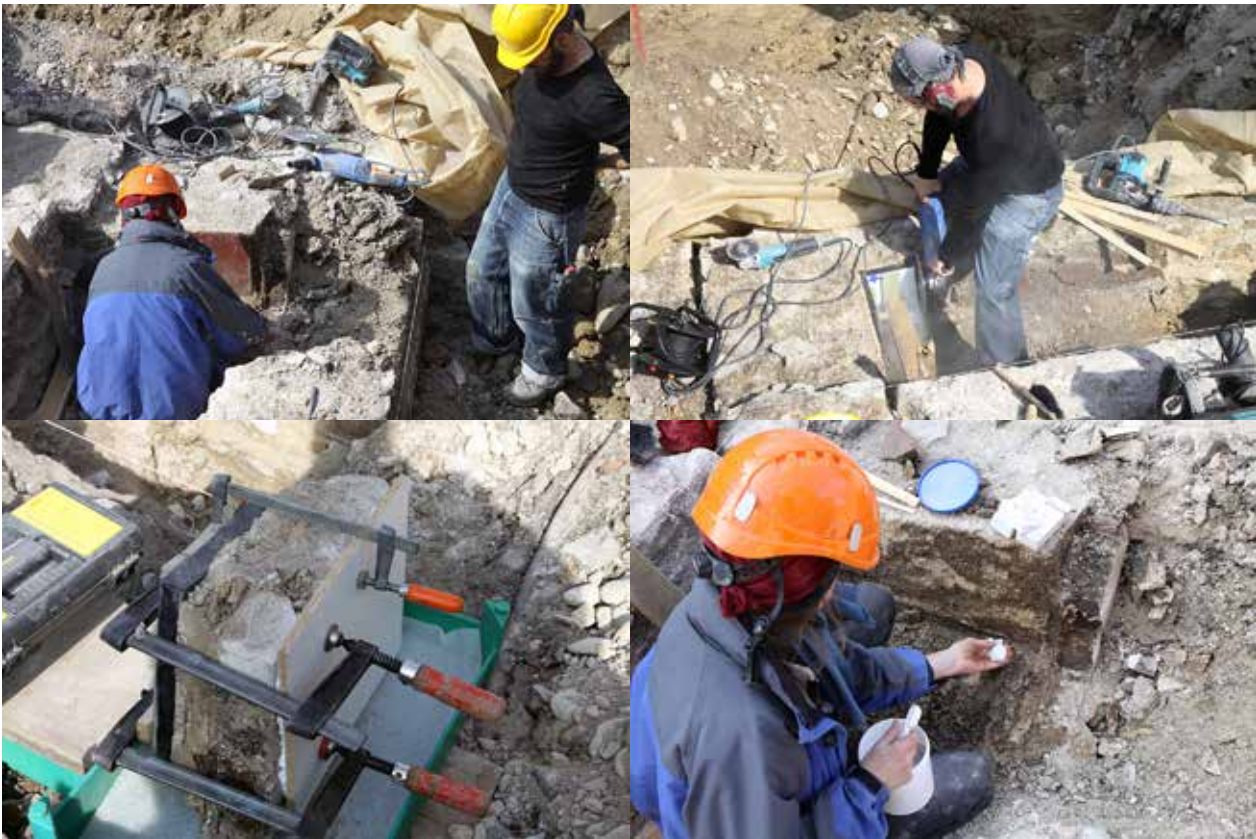
Abb. 22: Kaiseraugst AG, Baugrube Dorfstrasse 29 (Baubegleitung 2015.002). Christine Pugin und Gian-Titus Heinzelmann bei den Bergungsarbeiten an der Ecke MR 72/MR 73 mit Wandmalerei und Mosaik.
