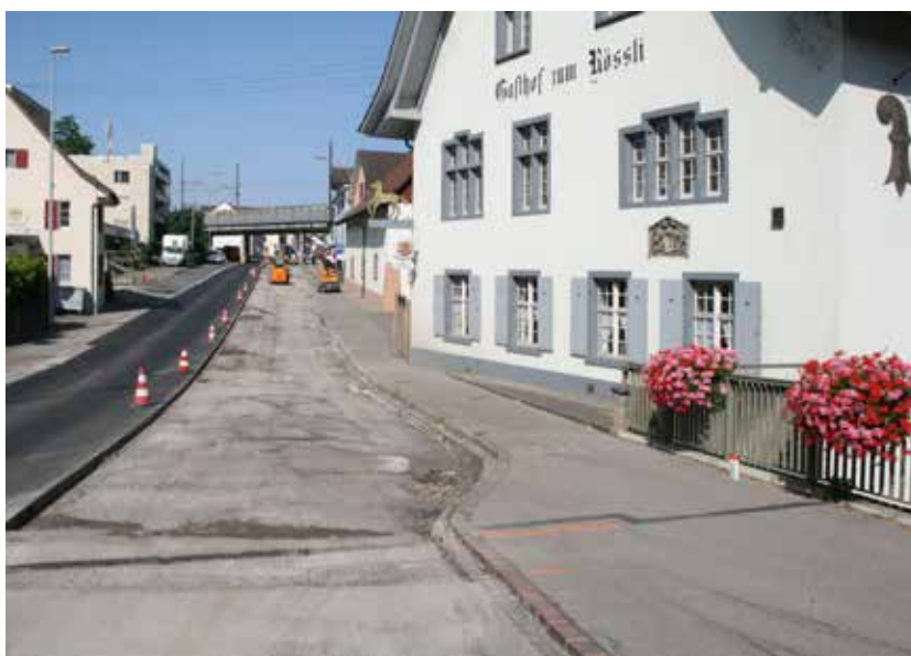
Abb. 83: Augst BL, Hauptstrasse Belagserneuerung (Grabung 2015.061). Der Belag auf der nördlichen Fahrbahn ist abgefräst (rechts), die südliche Fahrbahn weist bereits den neuen Belag auf (links). Von Osten.
