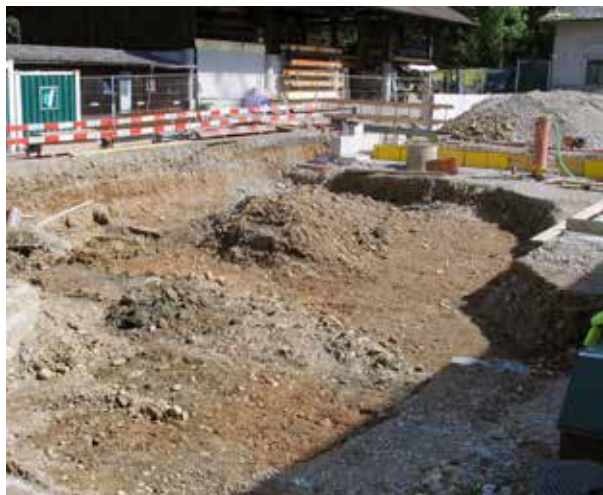
Abb. 36: Augst BL, Werkhof E. Frey AG (Grabung 2015.054). Das Gelände nach den grossräumigen Aushubarbeiten (siehe Abb. 35). Von Süden.
