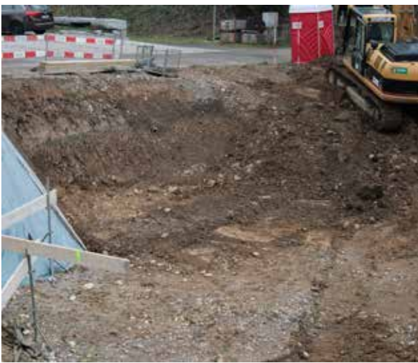
Abb. 23: Augst BL, Hausmatt (Grabung 2015.053). Aushubarbeiten am nördlichen Rand der Baugrube. Oben von links nach rechts laufend der Hausmattweg. Von Westen.
