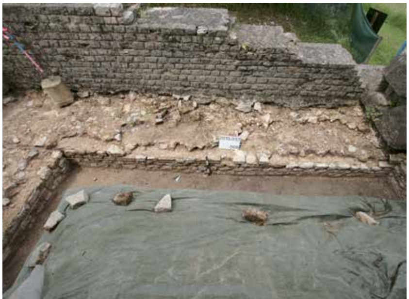
Abb. 52: Augst BL, Basilica-Stützmauern (Grabung 2015.057). MR 8 in Feld 12 nach dem Abbau der 1941 aufgesetzten Mauerkronen (vgl. Abb. 51). Links angeschnitten MR 13. Von Südosten.
