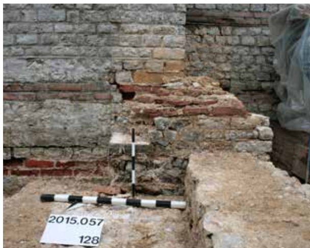
Abb. 56: Augst BL, Basilica-Stützmauern (Grabung 2015.057). Bemerkenswert sind die gute Erhaltung der originalen Mauersubstanz von MR 16 (vgl. Abb. 54 und 55), die antiken Fugenstriche im Mörtel sowie die Ausgestaltung des Ziegeldurchschusses. Von Nordwesten.
