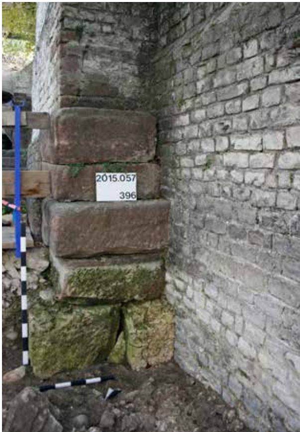
Abb. 66: Augst BL, Basilica-Stützmauern (Grabung 2015.057). Die Nordecke der Basilica-Stützmauer ist baulich sehr exponiert, muss sie doch grosse Lasten (Erd- und Gebäudedruck) abfangen. Dementsprechend ist die Ecke mit MR 20 sehr massiv ausgeführt. Entsprechend wurde das Fundament ausgelegt, von dem durch die Ausgrabungsarbeiten in Feld 8 weitere Steinlagen freigelegt werden konnten. Die verbauten Buntsandstein- und Kalksteinblöcke sind unterschiedlich gross, und es gibt Spuren, die auf eine Zweitverwendung an dieser Stelle hindeuten. Von Nordwesten.
