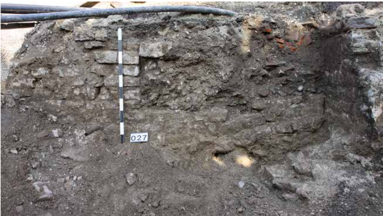
Abb. 6: Kaiseraugst AG, Baugrube Dorfstrasse 29 (Baubegleitung 2015.002). Rechts im Bild MR 10 mit dem stark hervorragenden Fundament. MR 68 zieht über dieses und stösst gegen MR 10. In einer späteren Phase wurde MR 68 teilweise abgebrochen: Beim Massstab ist die Ecksituation zusammen mit MR 69 (hier nicht sichtbar) neu errichtet worden. Rechts davon ist MR 68 bis auf drei Lagen abgebaut worden, um einen Durchgang für eine Gasse zu schaffen, deren Kiesbelag rechts im Bild gegen MR 10 noch intakt ist. Ein Riss und eine Senkung von ca. 0,10 m sind weitere Beweise für die statischen Probleme hier in der Region. Blick von Westen.
