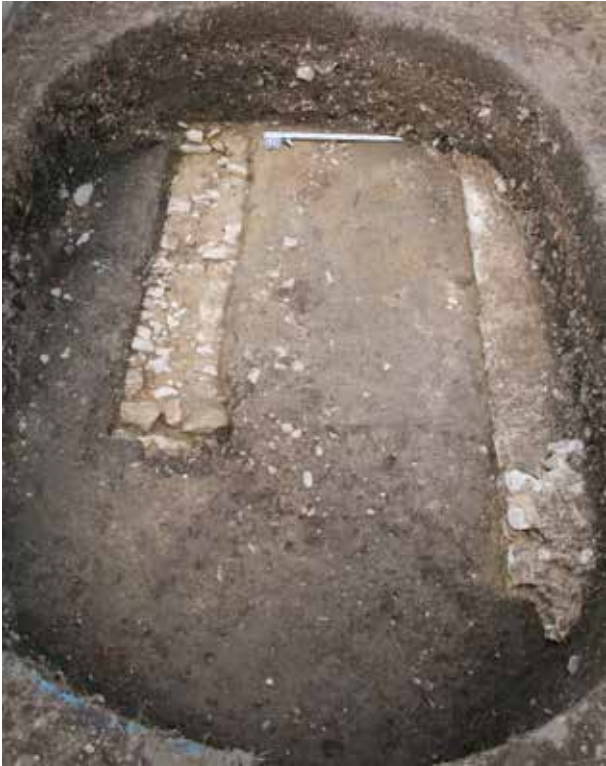
Abb. 46: Augst BL, Thermenstrasse 7 (Grabung 2015.056). Links im Bild die Portikusmauer (MR 2), rechts die Aussenfront von Insula 16 (MR 1), vorne rechts der Ansatz einer Innenwand (MR 3). Von Nordosten.
