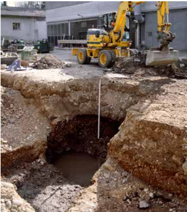
Abb. 34: Augst BL, Werkhof E. Frey AG (Grabung 2015.054). Tief geführter Aushub zur Abklärung der Terrainverhältnisse im westlichen Teil der geplanten Werkhalle. Von Westen.
