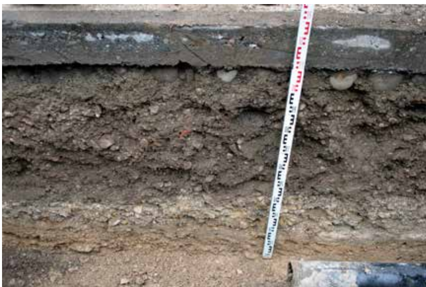
Abb. 15: Augst BL, Wasserleitung Hauptstrasse (Grabung 2015.052). Südprofil P 63 mit dem deutlich sich abzeichnenden Kiesbelag der Basiliastrasse (weisses, schwach rosa gefärbtes kiesiges Band, siehe Abb. 11,1). Von Norden.
