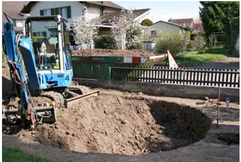
Abb. 43: Augst BL, Thermenstrasse 7 (Grabung 2015.056). Die Aushubarbeiten waren bereits im Gange, als das Grabungsteam über das Vorhaben informiert wurde. Von Nordwesten.
