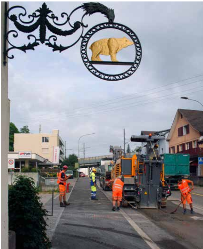
Abb. 82: Augst BL, Hauptstrasse Belagserneuerung (Grabung 2015.061). Abfräsen des alten Belags auf der südlichen Fahrbahn. Von Osten.
