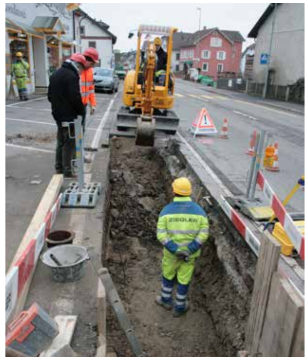
Abb. 13: Augst BL, Wasserleitung Hauptstrasse (Grabung 2015.052). Aushubüberwachung zwischen bereits gespriessten Stellen (vorne) und dem arbeitenden Bagger (hinten). Wie hier brach an vielen Stellen das seitliche Erdreich oft ein, sodass die von der Baufirma vorgenommene rasche Spriessung der Grabenwände verständlich ist. Von Osten.
