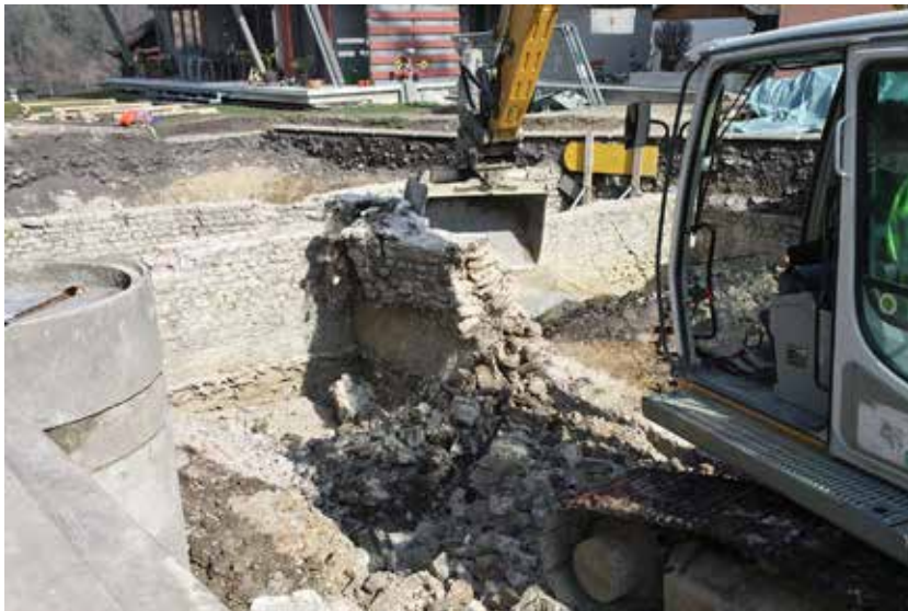
Abb. 3: Kaiseraugst AG, Baugrube Dorfstrasse 29 (Baubegleitung 2015.002). Maschineller Abbruch der römischen Mauern. Blick von Südwesten.
