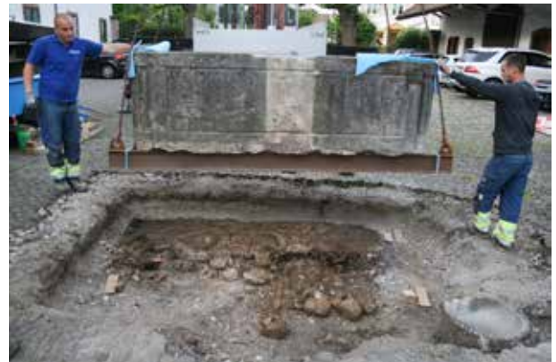
Abb. 71: Augst BL, Ehingerhof (Grabung 2015.059). Das aus Beton gegossene Brunnenbecken wird weggehoben, damit die Fundamentierung erneuert werden kann. Das bestehende Fundament erwies sich eher als Gebastel, wie das Bild zeigt. Es war mit der Möglichkeit gerechnet worden, dass dafür allenfalls Spolien aus römischer Zeit verwendet worden seien, weshalb die Arbeiten begleitet wurden. Von Süden.
