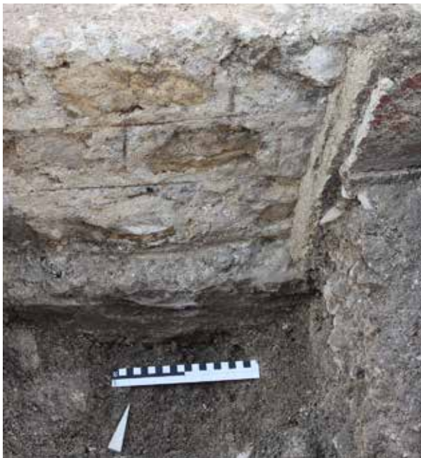
Abb. 21: Kaiseraugst AG, Baugrube Dorfstrasse 29 (Baubegleitung 2015.002). Kleine Sondierung an MR 72, die den Absatz und das sorgfältig mit Fugenstrich versehene Aufgehende zeigt. Die drei Verputzschichten sind hier schön zu sehen. Blick von Süden.
