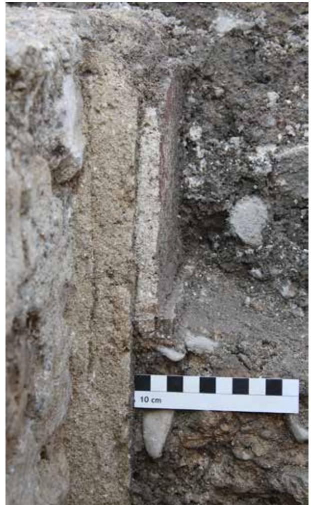
Abb. 20: Kaiseraugst AG, Baugrube Dorfstrasse 29 (Baubegleitung 2015.002). Schnitt und Detail durch die verschiedenen Verputzschichten an MR 72 und durch das Mosaik mit Teilen des Unterbaus. Blick von Westen.
