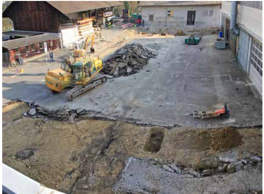
Abb. 33: Augst BL, Werkhof E. Frey AG (Grabung 2015.054). Der vorhandene Belag wird auf der ganzen Fläche der geplanten Werkhalle entfernt. Von Südwesten.
