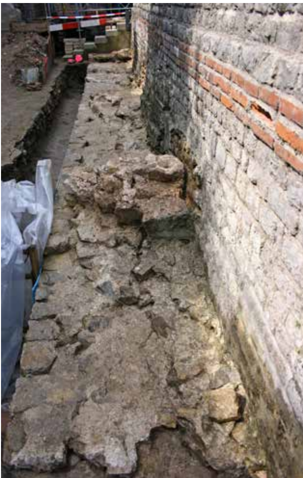
Abb. 54: Augst BL, Stützmauern Basilica (Grabung 2014.057). Freilegung der Originalsubstanz von MR 8 mit den aufgesetzten Stützpfйлern (Arbeitsaufnahme). Von Norden.
