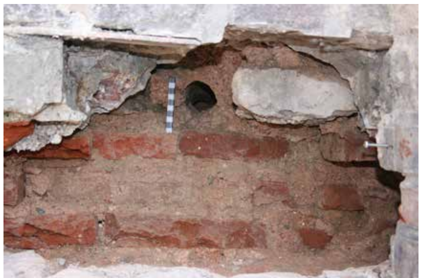
Abb. 58: Augst BL, Stützmauern Basilica (Grabung 2014.057). Nach dem Rückbau der konservierenden Mauerschale von 1941 sichtbar gewordenen originales Gerüstloch in MR 31 (Nordseite). Von Nordwesten.
