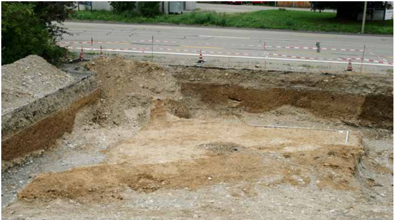
Abb. 48: Pratteln BL, Rheinstrasse (Grabung 2013.064). Übersicht über die Situation des Grabens in der Nordwestecke des Baugrundstücks. Links das Westprofil P 1 (Abb. 43) von Feld 4, in der Mitte die flächig untersuchte Partie des Grabens (Feld 6), hinten das Nordprofil P 3 (Abb. 47) von Feld 2. Von Südsüdosten.
