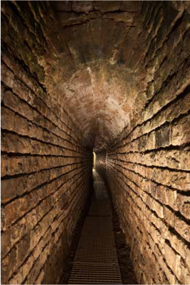
Abb. 28: Augst BL, Vermessung Keller und Kloake (Grabung 2013.061). Blick in die Kloake Richtung Osten. Deutlich ist der leicht gekrümmte Verlauf des Abwasserkanals zu sehen. Am oberen Bildrand ist die gemauerte Partie eines Einstiegschachts für Unterhaltsarbeiten zu erkennen.
