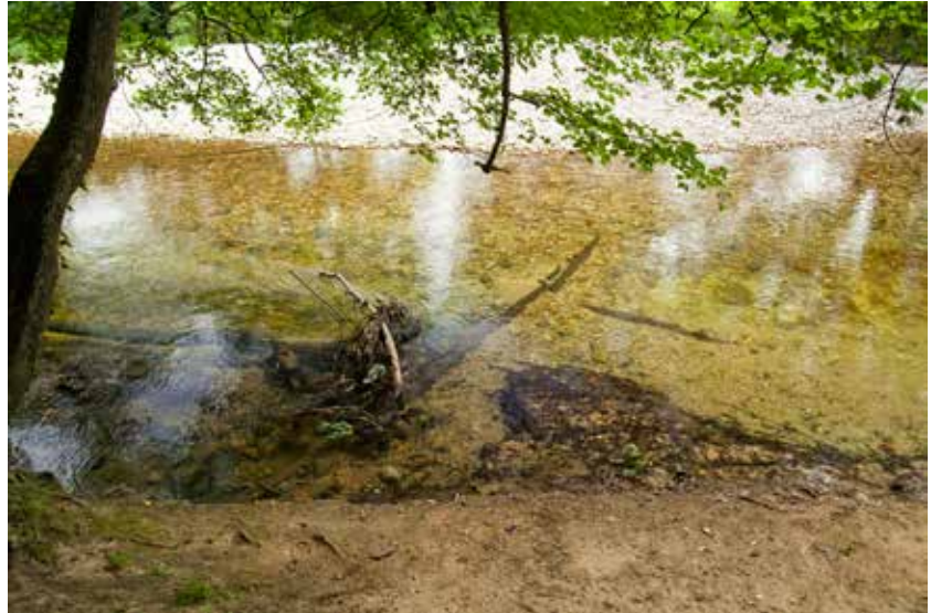
Abb. 39: Augst BL, Ergolz Flussfunde (Aktennummer 2013.063). Die zu einem grossen Teil zerstörte Flussverbauung. Der gut erhaltene Teil liegt am linken Ufer der Ergolz, im Bereich der Flur Hausmatt. Von Westen.
