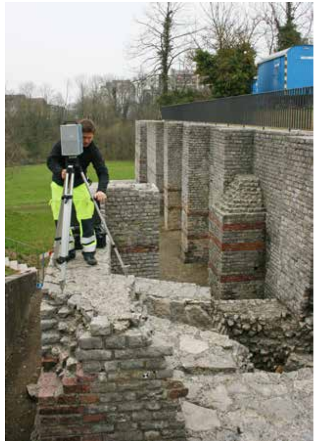
Abb. 13: Augst BL, Laserscan Basilicamauer (Aktennummer 2013.055). Installation des Laserscangeräts auf einer der Mauern des Monuments. Von Süden.
