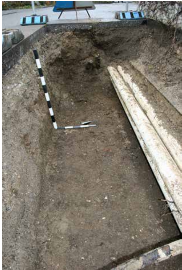
Abb. 57: Augst BL, Kabelgraben Bahnweg–Hauptstrasse (Grabung 2013.069). Die erhaltene Oberfläche der römischen Kultur- oder Brandschicht in Feld 3. Rechts das Rohrbündel der Elektroleitungen. Das Feld liegt an der Ostkante des Hausmattwegs. Von Südosten.
