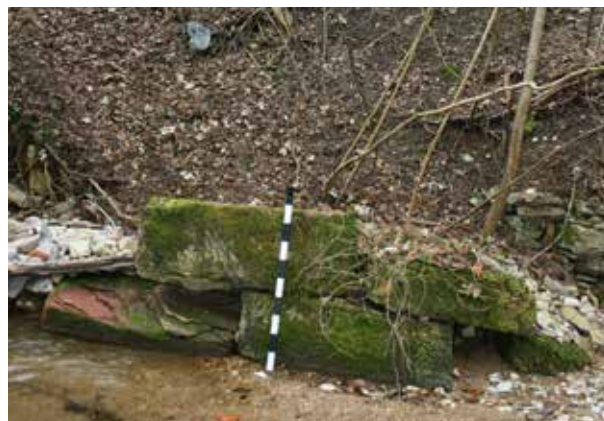
Abb. 6: Augst BL, Violenbach Architekturfragmente (Aktennummer 2013.052). Am Rand des Bachbetts aufgeschichtete Buntsandsteinblöcke als Uferverbauung. Von Nordosten.
