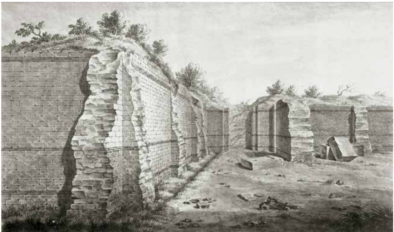
Abb. 20: Augst BL, Stützmauern Basilica (Grabung 2013.057). Ansicht der Situation im Jahre 1845, nach der Grabung von Johann Jakob Schmid im Jahre 1843. Der Durchgang in der Bildmitte wurde als Stadttor interpretiert. Die Ziegeldurchschussbänder in den Mauern sind sorgfältig wiedergegeben. Das Terrain lag zum Zeitpunkt der zeichnerischen Aufnahme rund zwei Meter höher als heute. Von Nordosten.
