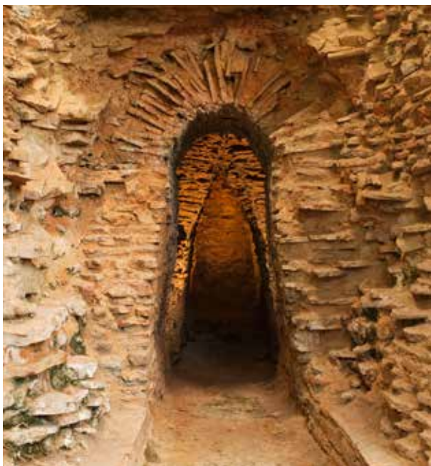
Abb. 12: Kaiseraugst AG, Liebrüti. Blick nach Norden durch den Schürkanal von Ofen ZK 50 in dessen Heizkammer. Während der Schürkanal mit einem Rundgewölbe überdeckt ist, sind dahinter in der Heizkammer Kragbogen zu erkennen.
