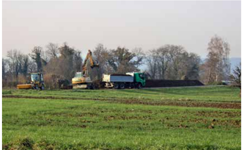
Abb. 25: Augst BL, Massnahmen Landwirtschaft (Aktennummer 2013.059). Aufschütten des Humus zu einer Deponie entlang der Ostseite der modernen Westtorstrasse. Die Baumreihe im Hintergrund gehört zum Wäldchen rund um das Amphitheater. Von Südosten.
