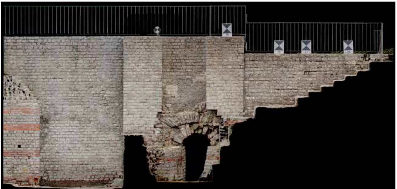
Abb. 14: Augst BL, Laserscan Basilicamauer (Aktennummer 2013.055). Ansicht des Südteils der Basilicastützmauer mit der Treppe rechts und dem Austritt der Kloake im Mittelteil. Von Nordnordwesten.
