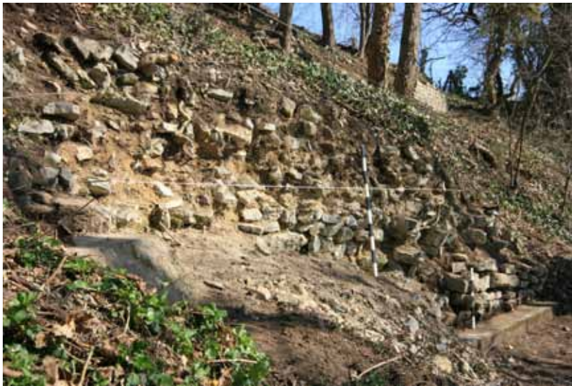
Abb. 18: Augst BL, Schönbühl Umfassungsmauern (Vorgang 2012.054). Mauer MR 2, die äussere Umfassungsmauer des klassischen Tempelbezirks. Links und rechts aussen sind die Betonunterfangungen aus dem Jahre 1941 zu erkennen. Die ursprünglich einmal viel besser erhaltene Mauer wurde damals Teil des Befestigungssystems an der Westseite des Augster Oberstadtplaueaus. Erkennbar ist die beträchtliche Dicke der Mauer. Von Nordwesten.
