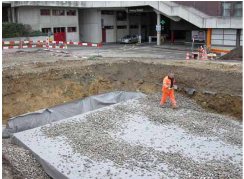
Abb. 68: Kaiseraugst AG, Liebrüti Vorplatz (Baubegleitung 2012.004). Am südlichen Ende der Baustelle wurde ein etwa 7 m × 7 m grosser Schacht ausgehoben. Die Baugrubenböschungen zeigten sterilen, ockerfarbenen Lehm. Blick von Nordosten.
