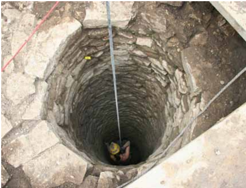
Abb. 40: Kaiseraugst AG, Auf der Wacht (Grabung 2012.001). Der obere Teil von Sodbrunnen MR 12 ist regelmässig rund und trocken gemauert. Blick von Osten.
