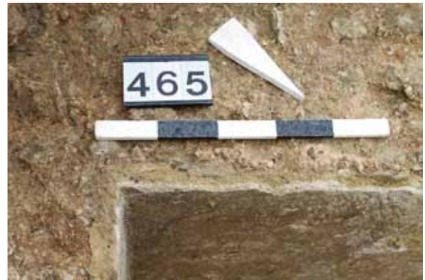
Abb. 16: Kaiseraugst AG, Auf der Wacht (Grabung 2011.001). Detailaufnahme der südlichen Ecke (MR 30/MR 34) des unterirdischen Raums, Blick von Nordosten. Der Verputz besteht aus zwei verschiedenen Schichten: ein erster grob aufgetragener Putz aus mit Kalk angereichertem Löss und ein Endverputz aus Kalk.
