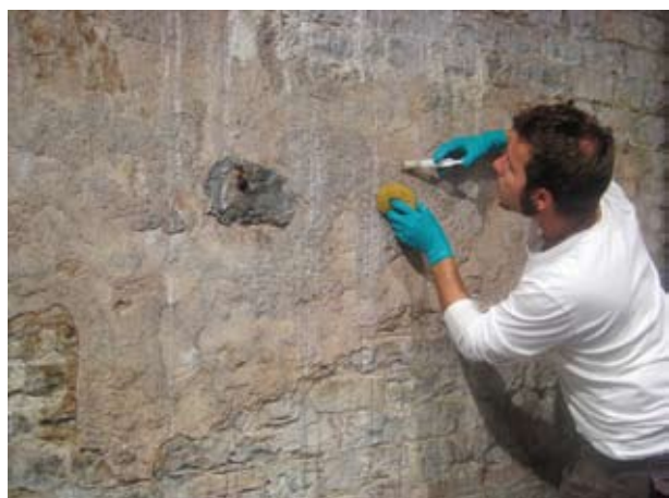
Abb. 70: Augst BL, Curia/Mosaikenausstellung. Hinter beiden Exponaten (Abb. 61–69) hat sich der Originalverputz an der Curia-Kellerwand wegen der Feuchtigkeit teilweise gelöst und musste von Monumentenrestaurator Titus Heinzelmann befestigt werden.
