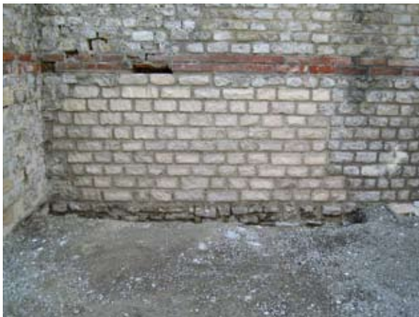
Abb. 60: Augst BL, Curia/Basilica-Stützmauer. Oben: Der originale Mörtel ist stark ausgewaschen und bis in grosse Tiefen völlig abgesandet. – Mitte: Die defekte Mauerpartie wurde entfernt und durch Mladen Puklin mit frostfesten Steinen und Kalkmörtel ergänzt. – Unten: der fertig restaurierte Mauerabschnitt.
