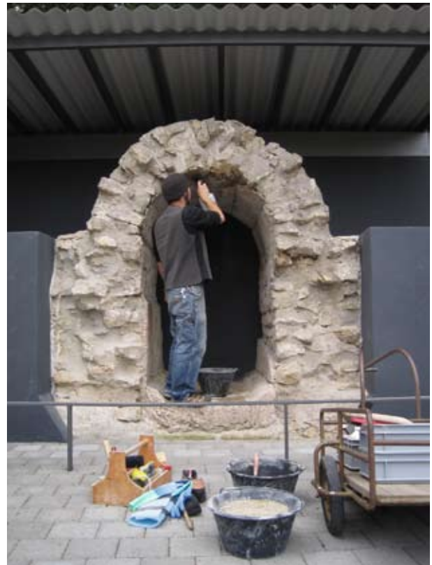
Abb. 71: Augst BL, Wasserleitungs-Exponat am Nordhang des Schönbühls. Im März 2010 wurde der lose römische Verputz in der Wasserleitung von Titus Heinzelmann neu befestigt und das Exponat gründlich gereinigt (Bild). Das alte hölzerne Schutzdach war zuvor durch eines aus Metall ersetzt worden. Damit das Wasserleitungsstück, das ja nicht hier gefunden worden ist, sich vom Monumenten-Ensemble beim Schönbühl abhebt, wurde die Dachkonstruktion dunkelgrau gestaltet und im Innern der Wasserleitung eine Fotografie angebracht, welche die Fortsetzung des Tunnels suggeriert (siehe Abb. 34).
