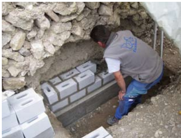
Abb. 74: Kaiseraugst AG, südliche Kastellmauer. Zwei instabile Stellen wurden, zur Sicherheit gegen weiteren Zerfall und Einsturz, mit einem in Beton gegossenen Streifenfundament und Zementbacksteinen unterfangen.
