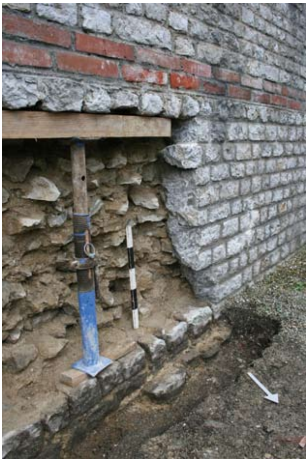
Abb. 40: Augst BL, Basilica (Grabung 2010.055). Ansicht an die Basilica-Stützmauer, nachdem die Mauerschale entfernt worden ist. Rechts ist nur noch eine dem antiken Mauerkern vorgeblendete frühere Restaurierung erhalten. Im Graben am Fusse der Mauer ist das vorkragende Mauerstück zu erkennen.
