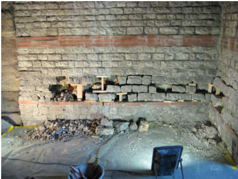
◀ Abb. 59: Augst BL, Nordhang Schönbühl. An verschiedenen Stellen in der Brotbackstube am Fuss der hohen Tempelstützmauer waren Mauersteine lose und Fugen angerissen. Sie wurden durch frostfeste Steine ersetzt und die Fehlstellen mit Mörtel ergänzt.
