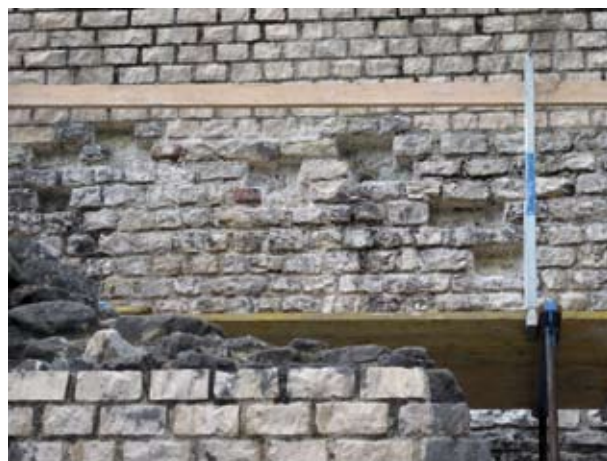
Abb. 78: Augst BL, Theater. Oben: Die hohe südliche Stützmauer von Keil 4 wurde sorgfältig überprüft. – Unten: Auch hier wurden viele Bruchsteine mit massiven Frostschäden festgestellt; die zersplitterten Steine mussten mit frostfesten Steinen und Kalkmörtel ersetzt werden. Selbstverständlich werden solche kleinen Restaurierungsmassnahmen sorgfältig lokalisiert und dokumentiert.
