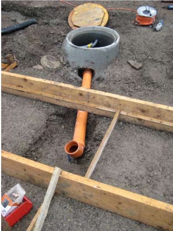
Abb. 81: Augst BL, Nordfuss des Schönbühls. Im Zuge der Sanierung der Brotbackstube liess der Technische Dienst den alten Sickerschacht in einen Pumpensumpf (Bild) umbauen, damit künftig das Brauchwasser der didaktischen Workshops via neue Abwasserleitung (Abb. 82) in die öffentliche Kanalisation geleitet werden kann.
