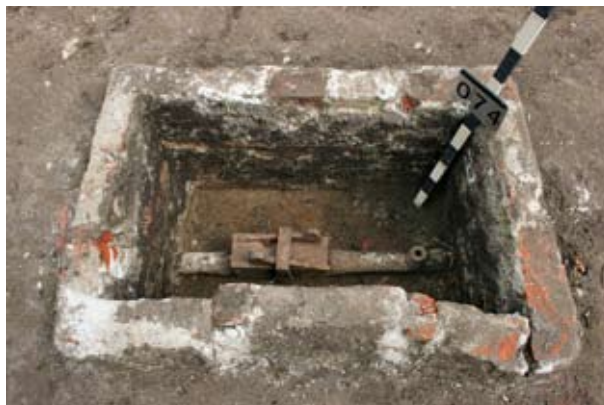
Abb. 12: Augst BL, Hausmatt (Grabung 2010.053). Wartungsschacht der gusseisernen Wasserleitung mit abhebbaarem, verkeiltem Deckel (links) und Schieber (rechts) in Feld 6. Von Nordwesten.
