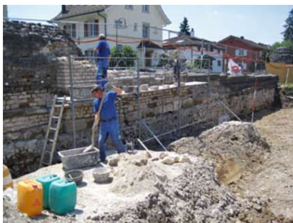
Abb. 74: Kaiseraugst AG, südliche Kastellmauer. Zwei instabile Stellen wurden, zur Sicherheit gegen weiteren Zerfall und Einsturz, mit einem in Beton gegossenen Streifenfundament und Zementbacksteinen unterfangen.
