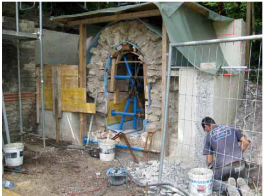
► Abb. 101: Augst, Augusta Raurica, Wasserleitungs-Exponat am Nordabhang des Schönbühls. Während der Restaurierungsarbeiten wurde das empfindliche Exponat sorgfältig eingepackt und mit Spriessen gestützt.
