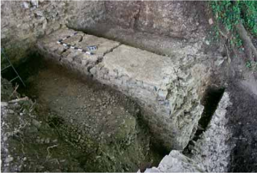
◀ Abb. 16: Augst BL, Stützpfiler Schönbühl (Grabung 2009.052). Blick auf die Abbruchkrone von Mauer 4 von Nordosten mit den beiden Querrissen. Rechts am Bildrand verläuft die Stützmauer MR 5, die nach Norden verkippt ist und sich von Mauer 4 gelöst hat.
