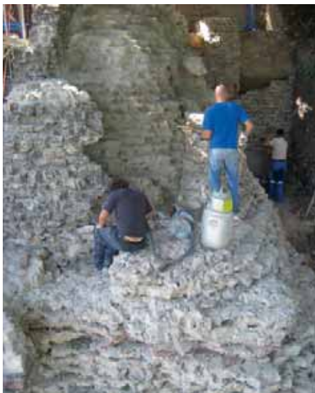
Abb. 9: Augst, Augusta Raurica, Nordhang Schönbühl. Nach der archäologischen Dokumentation werden die originalen Mauerflächen von Michael Grätz und Bashkim Huseyni durch einen Anwurf aus Kalkmörtel isoliert.
