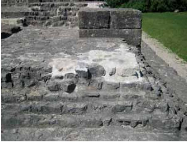
Abb. 95: Augst, Augusta Raurica, Schönbühl. An diversen Stellen des Tempelpodiums haben sich Steine gelöst. Diese wurden routinemässig durch neue Quader ersetzt.
