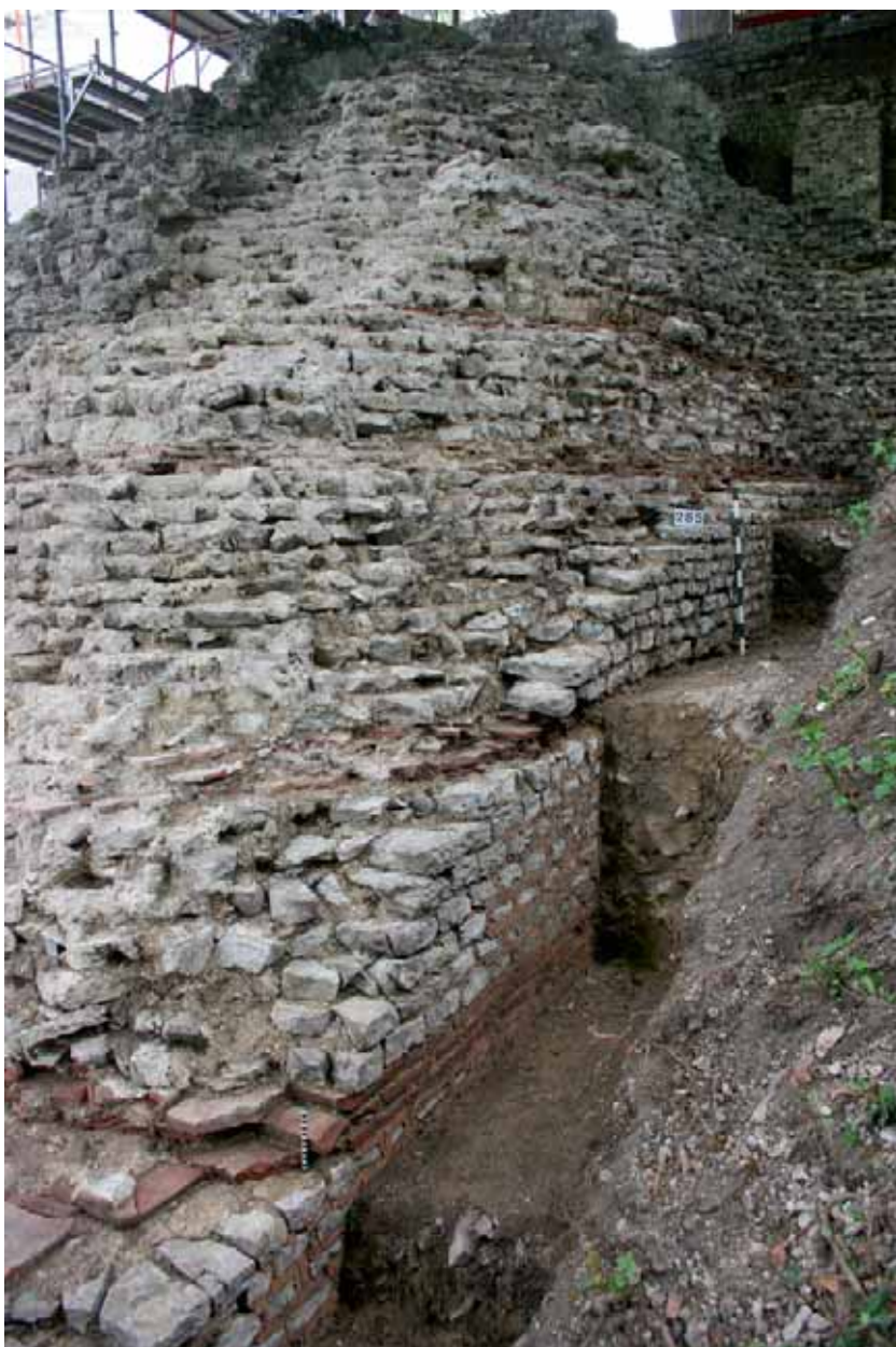
◀ Abb. 19: Augst BL, Stützfeiler Schönbühl (Grabung 2009.052). Ansicht der westlichen Mauerschale mit den Ziegeldurchschüssen und dem Kernmauerwerk. Von Nordwesten.
