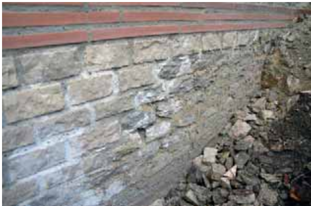
Abb. 89: Augst, Augusta Raurica, Nordhang Schönbühl, westliche Mauerschale. In allen Bereichen, wo neu aufgemauert wurde, trennen in die Mörtelfugen integrierte kleine Keramikplättchen den antiken Originalbestand von den modernen Ergänzungen.
