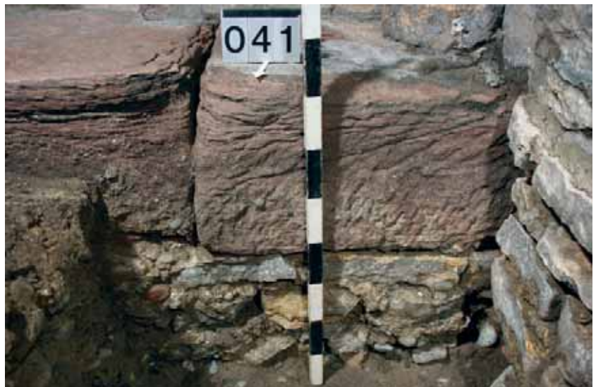
► Abb. 70: Augst BL, Brotbackstube (Grabung 2009.064). Ansicht an das aus mindestens drei Lagen bestehende Fundament aus Kalksteinen unter der Schwelle (MR 3) der westlichsten Kammer (taberna). Am rechten Bildrand ist das anstossende Mauerwerk des jüngeren Stützpfilers zu erkennen.
