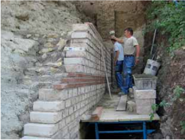
Abb. 93: Augst, Augusta Raurica, Nordhang Schönbühl. Aus statischen Gründen musste die rückwärtige Seite des Stützpfilers (westliche Mauerhaupt) von Dominik Fux und Mladen Puklin hoch aufgemauert werden.
