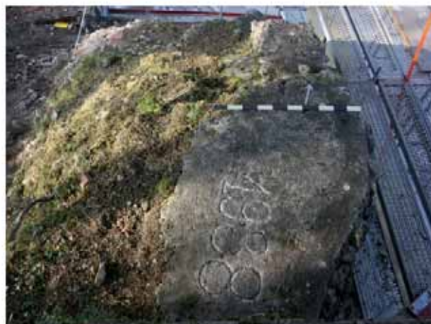
Abb. 87: Augst, Augusta Raurica, Nordhang Schönbühl. Der starke Baum- und Pflanzenbewuchs auf der Mauerkrone verursacht erhebliche Schäden. Diese dicken Baumwurzeln werden durch Mladen Puklin radikal entfernt.
