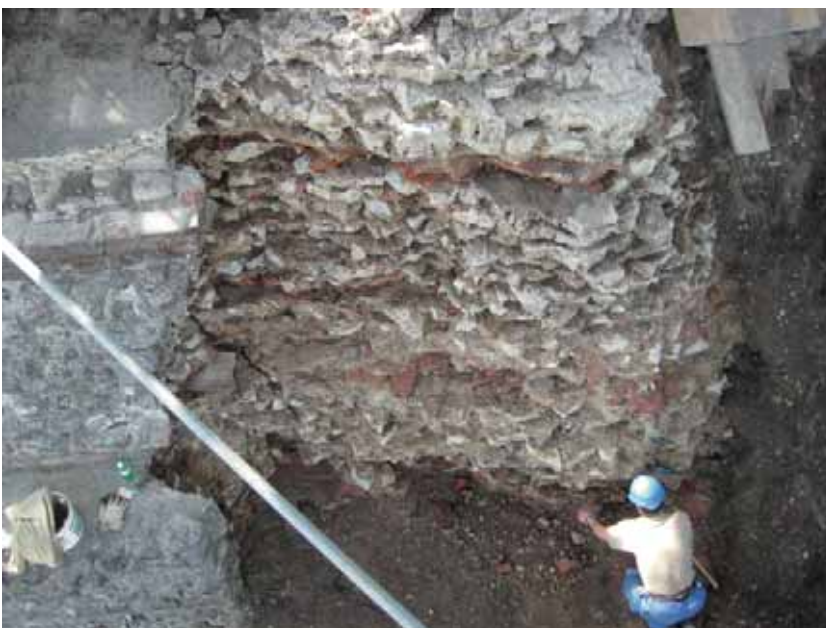
◀ Abb. 94: Augst, Augusta Raurica. Bei der Reinigung des Stützpfilers, hier durch Mladen Puklin, wurde der originale Ziegeldurchschuss deutlich sichtbar (zwei horizontale rote Bänder über resp. unter der Bildmitte). Diese Ziegelbänder gehören zum jüngeren, angebauten Teil des Stützpfilers und wurden bei den Restaurierungsarbeiten sichtbar belassen.
