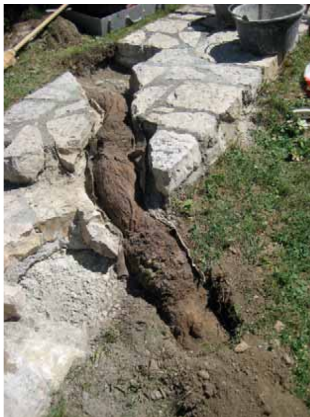
Abb. 104: Augst, Augusta Raurica, Theater. In der Bodenmarkierung des ersten Theatergrundrisses an der Giebenacherstrasse haben sich einige Steine durch den Druck der darunter liegenden Baumwurzeln gelöst.
