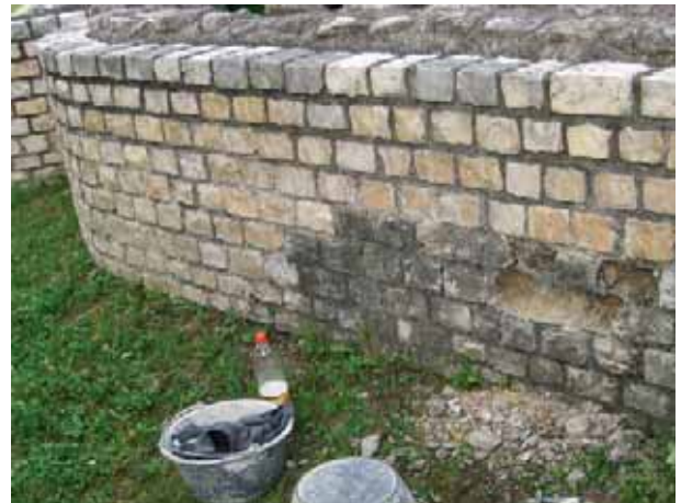
Abb. 106: Augst, Augusta Raurica, Theater. An diversen Stellen im Bereich der Umfassungsmauer von Keil 2 mussten die von Frost zerstörten Steine entfernt und durch frostfeste Steine und Mörtel ersetzt werden. Dieses Beispiel zeigt deutlich, wie auch nach der grossen Theatersanierung immer wieder Schäden auftreten können; das Monument erfordert permanente Beobachtung und laufendes restauratorisches Eingreifen.
