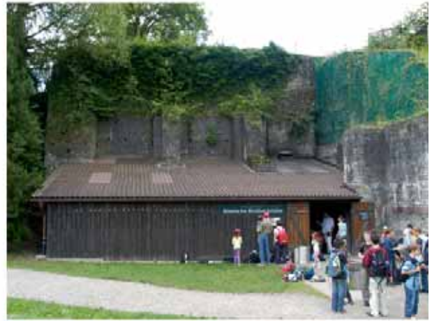
Abb. 83: Augst, Augusta Raurica, Nordhang Schönbühl. Aufbau des Gerüsts durch die Firma Roth AG. Um den offen liegenden antiken Mauerkern während der Arbeiten gegen Feuchtigkeit zu schützen, war eine vollständige Überdachung notwendig.
