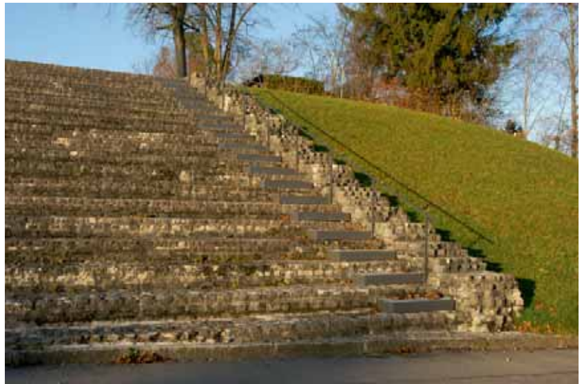
Abb. 96: Eine denkmalpflegerische Konzession an die Sicherheit der älteren Besucherinnen und Besucher am Aufstieg zum Augster Schönbühltempel: Die modernen Trittstufen und ein Handlauf werden von der Firma Furrer aus Lausen seitlich der römischen Monumentaltreppe zum Tempel montiert.
