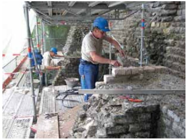
Abb. 91: Augst, Augusta Raurica, Nordhang Schönbühl. Die Stützmauer mit ihren Entlastungspfeilern oberhalb der Brotbackstube wird von Dominik Fux und Mladen Puklin dort, wo nötig, etwas aufgemauert.
