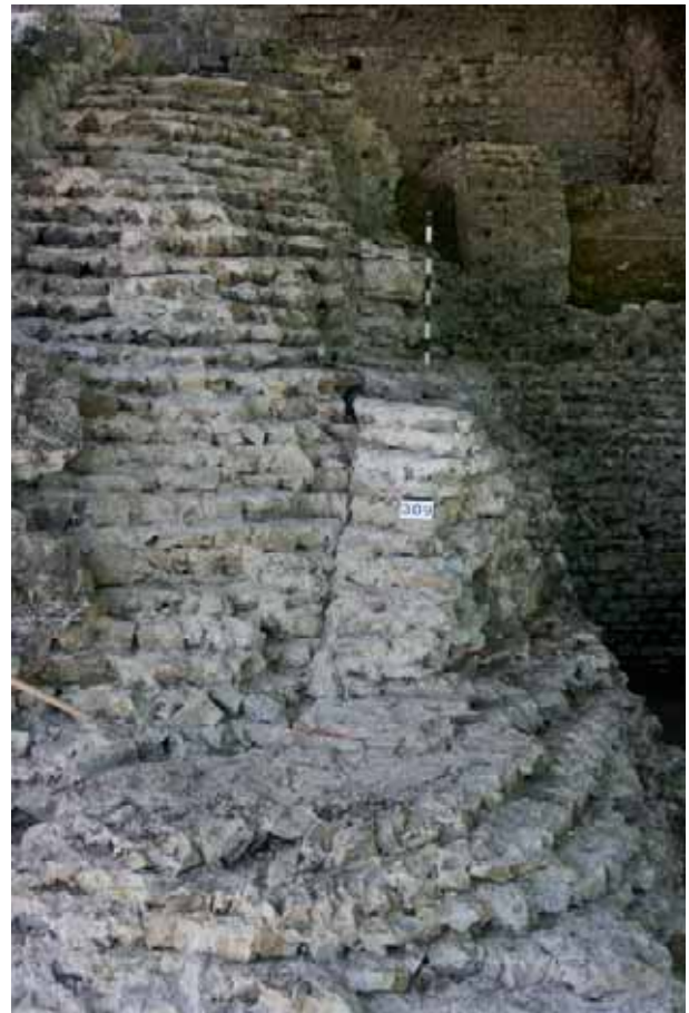
Abb. 20: Augst BL, Stützpfiler Schönbühl (Grabung 2009.052). Blick an das Kernmauerwerk des älteren Stützpfilers MR 6 (links) und des jüngeren Stützpfilers MR 1 mit den Ziegeldurchschüssen (rechts). Gut zu erkennen ist die vertikal verlaufende Mauerfuge. Von Norden.
