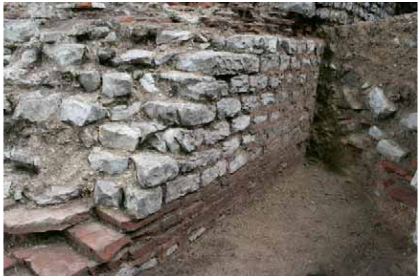
► Abb. 23: Augst BL, Stützpfeiler Schönbühl (Grabung 2009.052). Ansicht der westlichen Mauerschale des jüngeren Stützpfeilers mit den Ausfugungen mit rötlichem Ziegelmehlmörtel. Von Westen.
