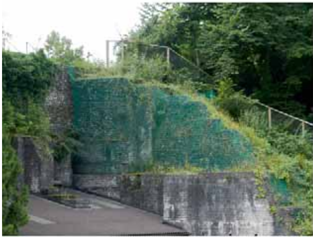
Abb. 81: Augst, Augusta Raurica, Nordhang Schönbühl. Der Stützpfiler wird nur teilweise, d. h. vor allem die Mauerschaltung an der Ostseite, restauriert (links im Bild). Der ausgegrabene, aber nicht restaurierte Mauerkern und die Mauerschaltung am Nordhang wurden über Jahrzehnte ihrem Schicksal überlassen und waren einem rapiden Zerfall ausgesetzt.
