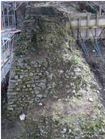
Abb. 68: Augst, Augusta Raurica, Nordhang Schönbühl (Grabung 2009.052). Die erste Grobreinigung am originalen antiken Mauerkern des Stützpfeilers durch das Restaurierungsteam. Steine und Mörtel an der während Jahrzehnten der Witterung ausgesetzten Oberfläche des Mauerkerns sind so instabil geworden, dass sie von Hand entfernt werden können. Die losen, nicht sicher antiken Kalksteine müssen zur Vorbereitung der Reinigung und Dokumentation (Abb. 69) noch entfernt werden.
