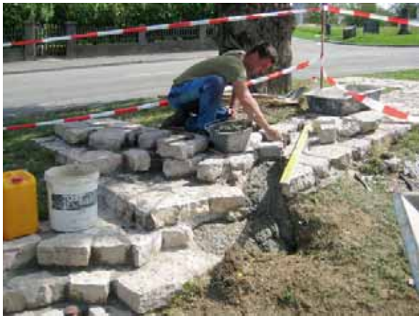
Abb. 105: Augst, Augusta Raurica, Theater. Die bei der Gesamtanierung des Theaters vor einigen Jahren noch verschonten Wurzeln mussten nun doch entfernt und die Fehlstellen der Bodenmarkierung mit Steinen und Mörtel ergänzt werden (im Bild: Remo Plattner, Firma Markus Fux AG).
