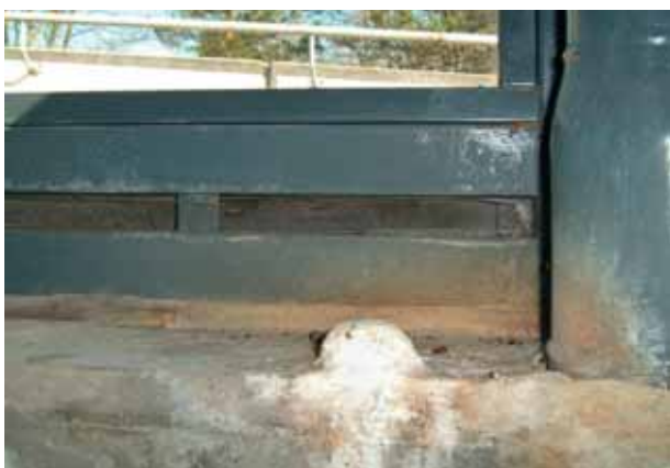
Abb. 94: Kaiseraugst-Liebrüti. Im «modernen» Schutzhause über den beiden römischen Ziegelbrennöfen haben sich infolge eines immer wieder undicht gewordenen Beton-Flachdachs richtige Stalagmiten gebildet (vorne in der Mitte). Auch die metallenen Fensterrahmen sind durch Rostbildung stark in Mitleidenschaft gezogen worden. Das Aargauer Hochbauamt hat 2008 alle Schäden behoben (Abb. 95).
