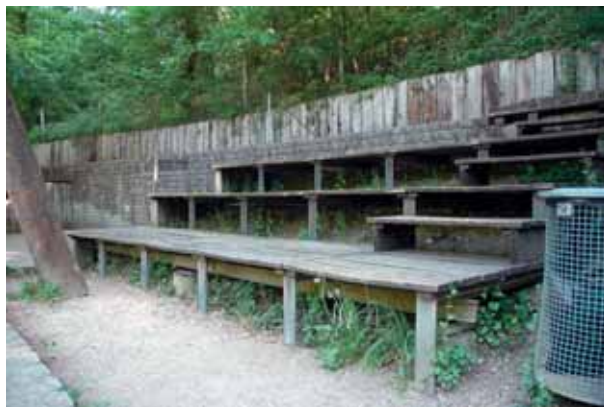
Abb. 90: Augst, Augusta Raurica. Amphitheater. Diese 1988 installierten Sitzstufen sollten trotz moderner Materialien (Metall und Eichenholz) die untersten Sitzstufen im Bereich des Podiums über dem nördlichen Carcer andeuten. Gleichzeitig dienten sie jahrelang als Picknickplatz und «Freilicht-Klassenzimmer». Nach 20 Jahren mussten die Holzabdeckungen ersetzt werden (Abb. 91).
