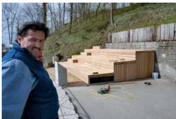
Abb. 91: Augst, Augusta Raurica. Amphitheater. Schreiner Thomas Bitterli aus Lausen/BL (links) erneuerte die maroden, 20 Jahre alten Sitzstufen-«Rekonstruktionen» aus Eichenholz über dem Carcer (vgl. Abb. 90). Der weitaus grösste Teil der ehemaligen – im Oval angeordneten – Sitzstufen des Amphitheaters von Augusta Raurica präsentiert sich heute als bewaldeter Hang (im Bildhintergrund) rings um die Arena.
