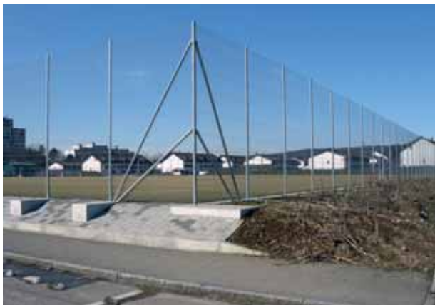
Abb. 26: Kaiseraugst AG, Sportanlagen Im Liner (Grabung 2008.005). «Bauen über den Ruinen». Das Fußballfeld liegt auf einer Aufschüttung über dem geschützten Gräberfeld «Im Sager». Blick von Osten auf die Spezialfundation der Einzäunung.
