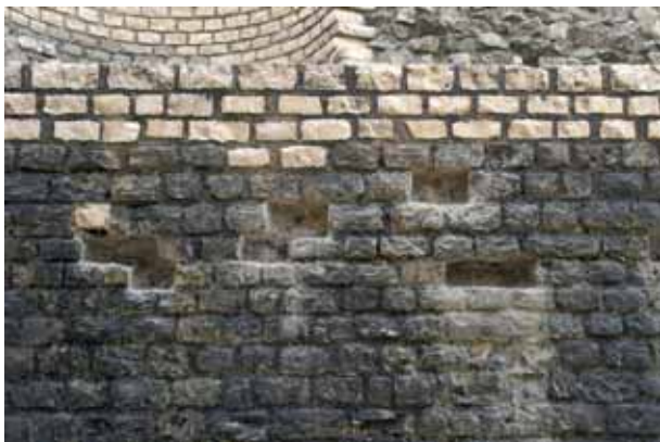
Abb. 82: Augst, Augusta Raurica. Theater. Nur ein Jahr nach Ende der 16 Jahre dauernden Gesamtanierung mussten von Frost versplitterte Steine einer damals nicht sanierten Mauerpartie bereits entfernt und mit neuen Quadern ersetzt werden. – Dieses Beispiel zeigt: Archäologische Denkmalpflege ist eine Daueraufgabe!
