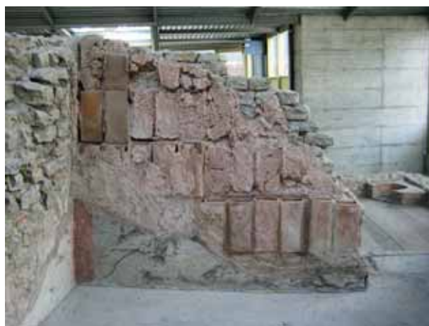
Abb. 81: Kaiseraugst-Schmidmatt. Die mutwillig herausgebrochenen Tubuli (Abb. 80) mussten an originaler Position wieder eingepasst werden.
