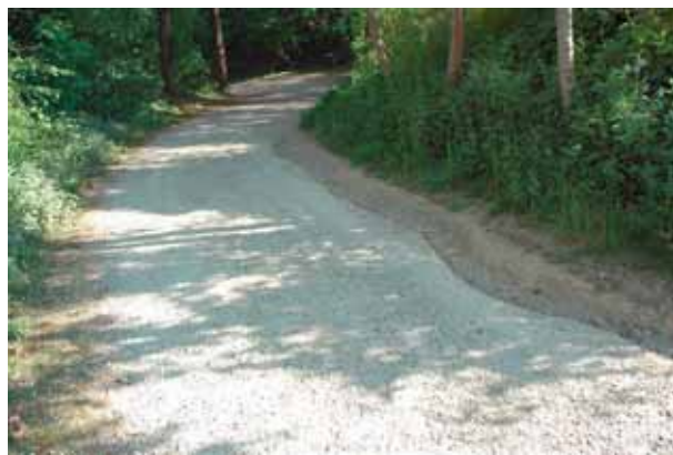
Abb. 88: Augst, Augusta Raurica. Amphitheater. Hier auf der steilen östlichen Zugangsrampe zur Arena bildeten sich bei starken Regenfällen regelmässig Sturzbäche, die viel Belagsmaterial und Humus nach unten schwemmten. Eingebaute Wasserrinnen, Drainagen in der Arena (Abb. 86) und ein neuer Belag (Bild) haben die Situation spürbar entschärft.
