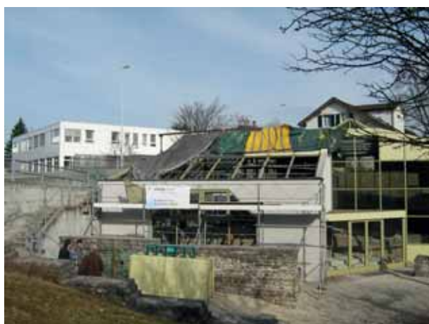
Abb. 96: Kaiseraugst-Schmidmatt. Das viel besuchte «römische Handels- und Gewerbehaus» unter diesem modernen Schutzbau war gefährdet, nachdem sich versteckte Korrosionsschäden an der Dachkonstruktion bemerkbar gemacht haben. Das Hochbauamt des Kantons Aargau liess die schadhafte Stellen freilegen und sanieren. Die damit beauftragte Firma nahm sich monatelang Zeit dafür, während der die stellenweise mit Plastikplanen abgedeckte archäologische Stätte nicht gerade einladend aussah.
