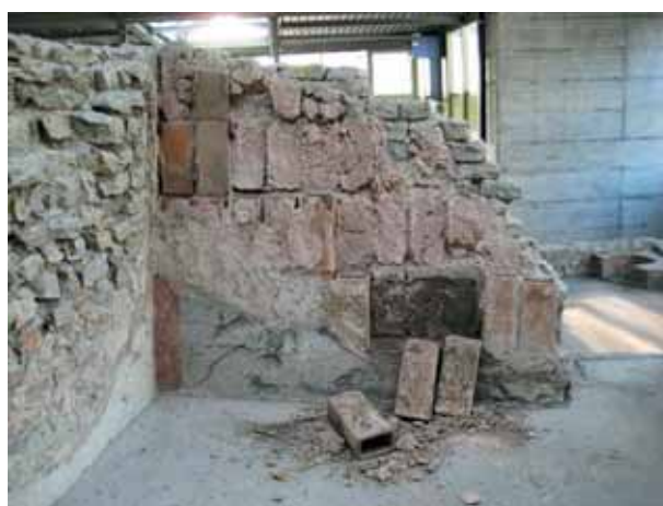
Abb. 80: Kaiseraugst-Schmidmatt. Drei Tubuli im am besten erhaltenen Hypokaust-Raum von Augusta Raurica wurden von Vandalen aus dem originalen Wandverband gerissen.
