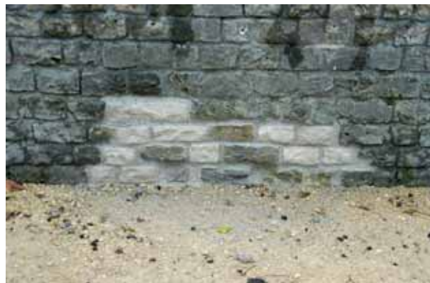
Abb. 73: Augst, Augusta Raurica. Amphitheater. An diversen Stellen muss – 21 Jahre nach der ersten umfassenden Restaurierung – die Arenamauer teilweise neu ausgefugt werden.
