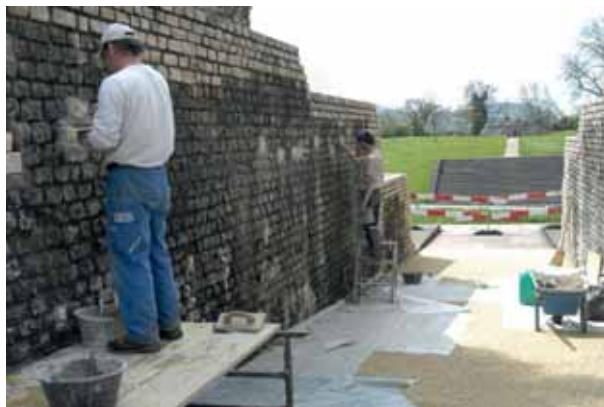
Abb. 83: Augst, Augusta Raurica. Theater. Auch hier im Mittelvomitorium waren bereits wieder punktuelle Ausbesserungen am alt restaurierten Mauerwerk nötig (analog Abb. 82; Mladen Puklin und Remo Plattner, Markus Fux AG).
