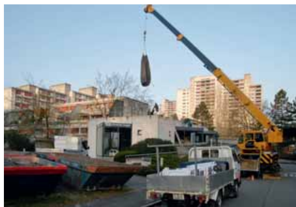
Abb. 95: Kaiseraugst-Liebrüti. Zur Sanierung des undichten Betondachs über den antiken Ziegelbrennöfen wird eine auf Mass vorfabrizierte Abdichtfolie «am Stück» auf das vorbereitete Dach gebracht.
