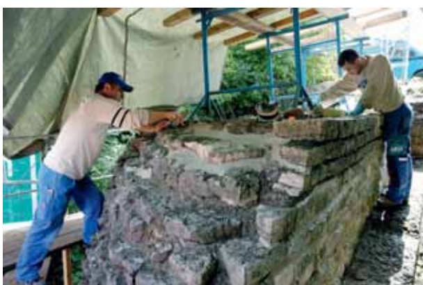
Abb. 76: Augst, Augusta Raurica. Westliche Stadtmauer. Die Fehlstellen wurden mit neuen Quadern ergänzt und der vielerorts herausgefallene Fugenmörtel neu mit einer Kalkmörtelmischung ausgefügt (Mladen Puklin und Remo Plattner, Markus Fux AG).
