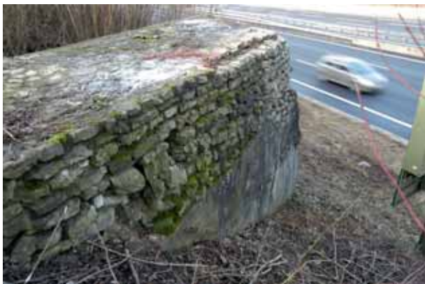
Abb. 74: Augst, Augusta Raurica. Westliche Stadtmauer. Direkt an der Autobahn gelegen und von Gestrüpp überwuchert, war nach 40 Jahren eine Total-sanierung fällig. Im Bild sind Büsche, Efeu usw. bereits entfernt.
