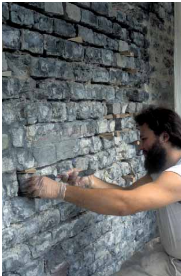
Abb. 48: Augst, Theatersanierung (Grabung 1992–2007.055). Mauerschale von Mauer MR 44/200, Arbeitsfoto während der Sanierung der vom Kern losgelösten Mauerschale.
