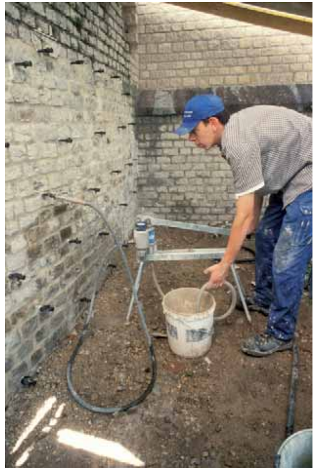
Abb. 61: Augst, Theatersanierung (Grabung 1992–2007.055). Peripherie von Keil 4, Verfüllung der Kluft in Mauer MR 57. Der auf der Basis von natürlichem hydraulischem Kalk entwickelte Vergussmörtel NHL V-g01 wird mit einer Handkolbenpumpe ins Mauerwerk injiziert. Deutlich sichtbar in der Mauerschale die für die Aufnahme des Injektionsmörtels in die Fugen eingebohrten «Packer».
