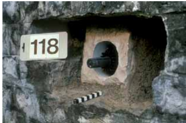
Abb. 55: Augst, Theatersanierung (Grabung 1992–2007.055). Sicherung einer Schalenplatte an Mauer MR 1 mithilfe von Glasfaserankern. Durch die «Muffe» aus Kalkstein mit konischer Aussenform werden zusammen mit dem verschraubten Ankerkopf gleichzeitig weitere umliegende Quader der Mauerschale mitverankert. Aus optischen Gründen wie auch als Schutz vor einer für die Kunststoffmuttern möglicherweise schädlichen UV-Bestrahlung werden alle Ankerköpfe anschliessend übermauert.
