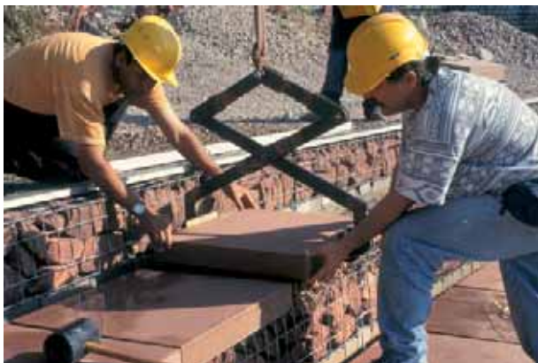
Abb. 73: Augst, Theatersanierung (Grabung 1992–2007.055). Teilrekonstruktion der Sitzstufenränge, Arbeitsfoto. Die Sitzplatten aus feinkörnigem Buntsandstein werden mit einer Greifzange an ihren Platz gebracht und millimetergenau versetzt.
