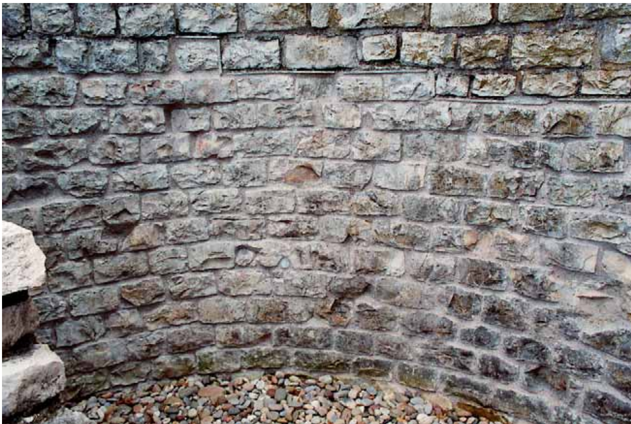
Abb. 60: Augst, Theatersanierung (Grabung 1992–2007.055). Peripherie Keil 2, Entlastungsbogen MR 125. Die geklebten Handquader wurden mit einem speziell entwickelten, weichen Restauriermörtel gefügt, die Mauerschale erscheint geschlossen und bietet Wasser und Vegetation wenig Angriffsfläche.
