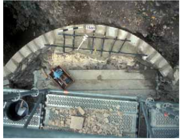
Abb. 57: Augst, Theatersanierung (Grabung 1992–2007.055). Peripherie Keil 4, Entlastungsbogen MR 139, Aufsicht von Süden. Ein Netz von eingelagerten Glasfaserstäben verbessert die Druckverteilung der modernen Aufmauerung auf die bestehende Mauerschale.
