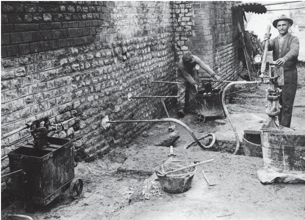
Abb. 62: Augst, Theater. Injektionsarbeiten von 1934 im Südaditus.
