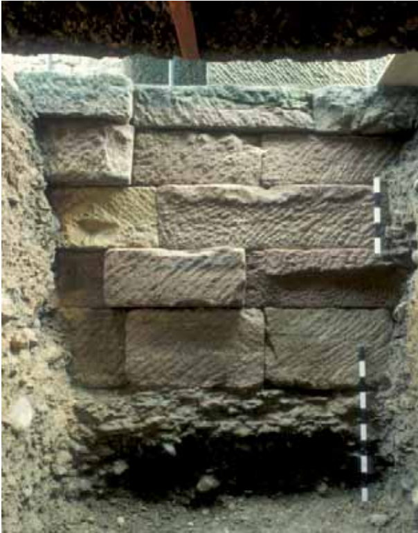
Abb. 34: Augst, Theatersanierung (Grabung 1992–2007.055). Nördliche Eingangshalle des jüngeren szenischen Theaters; Quaderfundament aus fünf Sandsteinlagen, das als Auflager für einen Gurtpfeiler der Hallenkonstruktion dient. In seiner Anlage geht das Fundament bereits auf die älteren Theaterbauten zurück.
