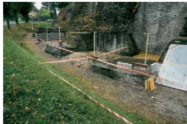
Abb. 63: Augst, Theatersanierung (Grabung 1992–2007.055). Die Visualisierung der geplanten Erdanschüttung an Peripherie Keil 1 dient als Hilfe zur Entscheidungsfindung während einer Sitzung der Eidgenössischen Kommission für Denkmalpflege. Durch die Erdanschüttung werden antike Mauerpartien optimal geschützt, der Erddruck hilft zudem bei der Stabilisierung der Peripheriemauern.
