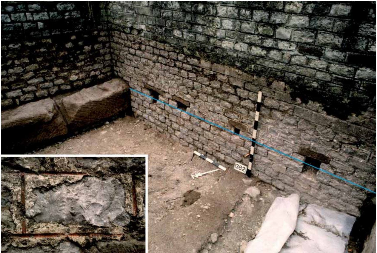
Abb. 40: Augst, Theatersanierung (Grabung 1992–2007.055). Abschnitt der Peripheriemauer des jüngeren szenischen Theaters in Keil 1; deutlich erkennbar ist der die Steinhäupter sichtbar belassende pietra-rasa-Verputz mit den eingedrückten, dunkelrot ausgemalten Fugen. Die Unterkante der Fugenbehandlung markiert die ungefähre Lage des Gelniveaus (blaue Linie). Wie die Balkenlöcher im Mauerwerk zeigen, muss das Bodenniveau zur Zeit der Benutzung des Theaters geringfügig höher gelegen haben; die Unterkante des Fugenstrichs markiert vermutlich das letzte Gelniveau zur Bauzeit, bevor der das Theater umgebende Bodenbelag aus Sandsteinquadern versetzt wurde. Das Endniveau dürfte um ca. 30 cm höher gelegen haben als die Unterkante des Fugenverputzes. Links im Bild die Fundamentzone eines der Stützpfiler an der Peripherie von Keil 1.
