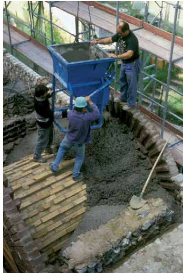
Abb. 66: Augst, Theatersanierung (Grabung 1992–2007.055). Fenstergewölbe in der äusseren Aditusmauer MR 1, Arbeitsfoto. Nach dem Einpassen des durch keilförmige Muschelkalkquäderchen gefertigten unteren Teils der Gewölbeschale wird der darüberliegende Gewölbebereich ausbetoniert.
