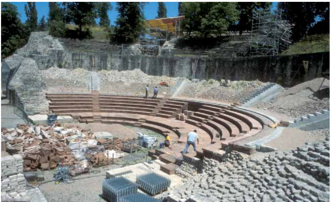
Abb. 72: Augst, Theatersanierung (Grabung 1992–2007.055). Teilrekonstruktion der Sitzstufenränge, Arbeitsfoto. Die Drahtschotterkörbe für die Sitzstufengestaltung liegen auf einer Auffüllung aus Granitschotter. Die Ausführung der radial verlaufenden Sitzreihen erforderte höchste Genauigkeit. Blick von Süden.
