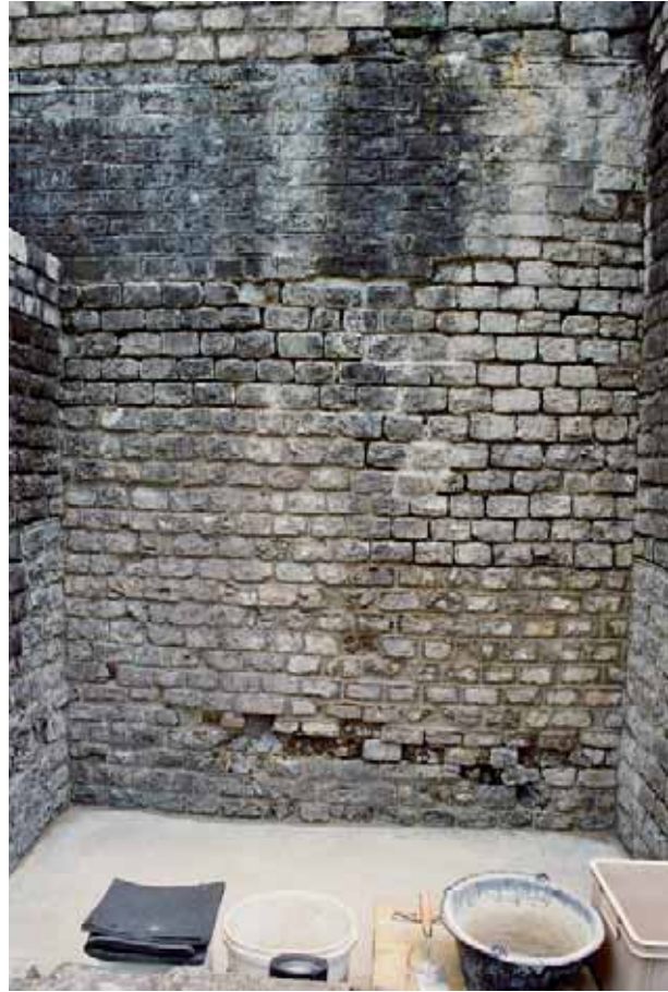
Abb. 28: Augst, Theatersanierung (Grabung 2007.055). Feinsanierung der Mauerschale von MR 55 mit stark durchfeuchtetem Mauerfuss im Bereich zwischen MR 155 und MR 156. Aufnahme nach Abschluss der Mauersanierung, vor dem Einbringen der schützenden Kiesanfüllung. Blick von Norden.
