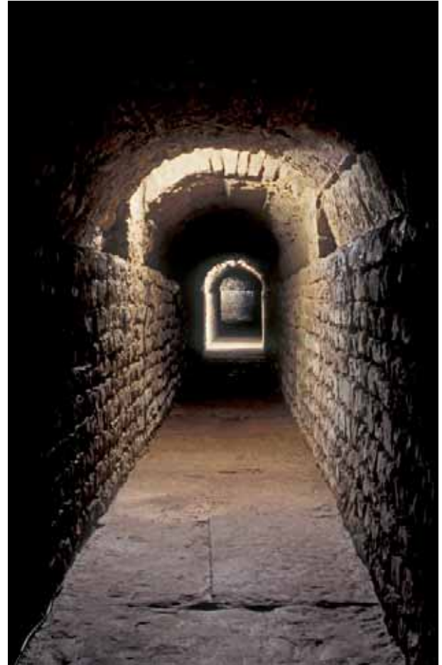
Abb. 43: Augst, Theatersanierung (Grabung 1992–2007.055). Abwasserkanal, nördlichster Abschnitt; Zone mit Gewölbe aus Kalkguss und Abdrücken der Schalungsbretter. Das Gewölbe wurde zur Zeit des jüngeren szenischen Theaters auf die bereits bestehenden, während dem Bau des Amphitheaters errichteten Wangenmauern aufgesetzt. Im Zentrum ist der Ansatz eines Einstiegschachtes zu erkennen, der als Zugang für die Wartung des Kanalsystems diente.
