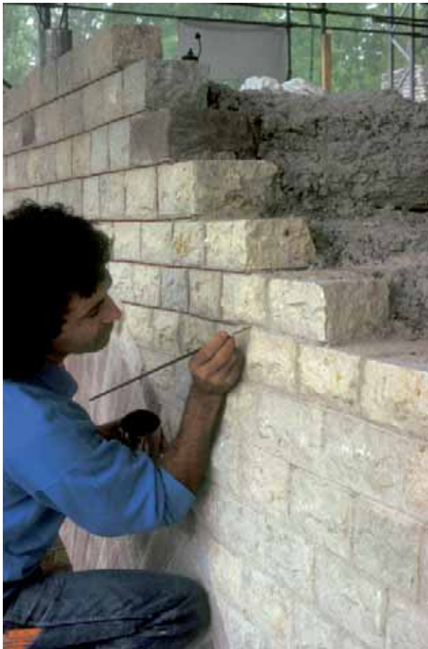
Abb. 78: Augst, Theatersanierung (Grabung 1992–2007.055). Fenster in der äusseren Aeditusmauer MR 1, Bemalen der Mörtelfugen zwischen den einzelnen Handquadranten des opus-vittatum-Mauerwerks entsprechend den antiken Vorgaben.
