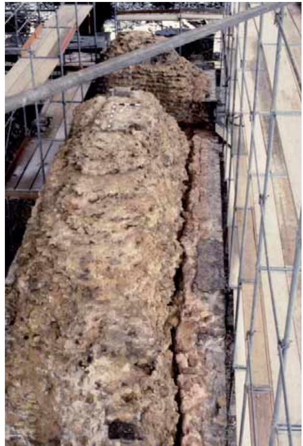
Abb. 50: Augst, Theatersanierung (Grabung 1992–2007.055). Die römische Reparatur der Mauerschale von Mauer MR 44/200 im südlichen Hauptzug (aditus maximus) zeichnet sich durch die Ziegelstaubbeimischung im Mörtel deutlich ab; sie ist durch eine erneute Kluft vom ursprünglichen Mauerkern getrennt. Blick von Norden.
