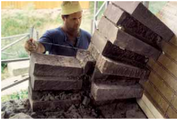
Abb. 65: Augst, Theatersanierung (Grabung 1992–2007.055). Fenstergewölbe in der äusseren Aditusmauer MR 1, Arbeitsfoto. Aufmauern der Doppelbögen mit Keilsteinen aus feinkörnigem Buntsandstein über der Gewölbeschalung.
