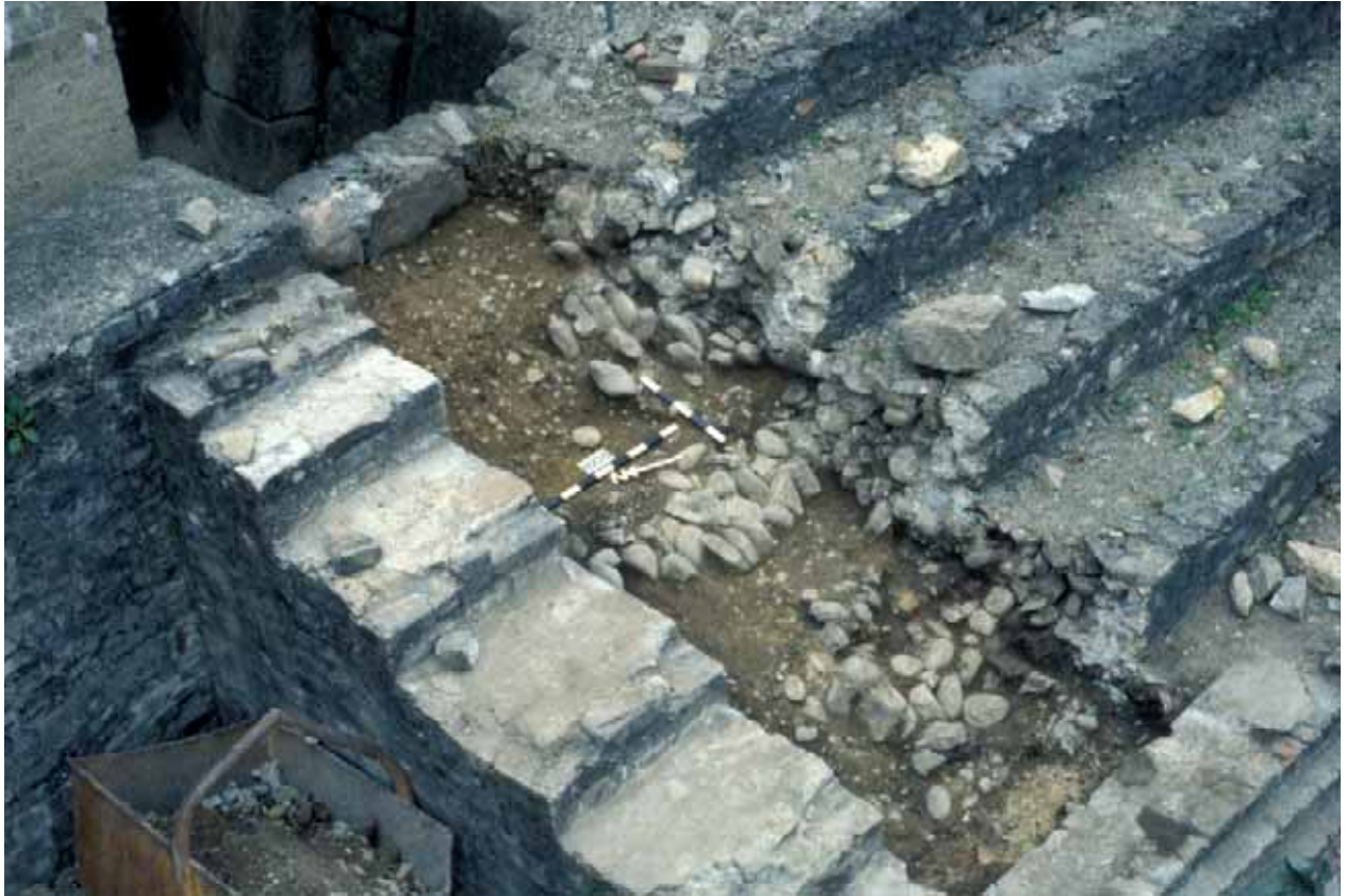
Abb. 23: Augst, Theatersanierung (Grabung 1992–2007.055). Aufsicht auf die originalen, zum Teil stark erodierten Sitzstufenunterlagen der jüngeren Bauphase des Amphitheaters (Phase 3b); auf den Kalkstein- und Wackensteinfundamenten befanden sich nachweislich Sitzstufen aus Buntsandstein. Rechts vom Sondierschnitt sind die 1946 von Rudolf Laur-Belart rekonstruierten Sitzstufen zu erkennen.
