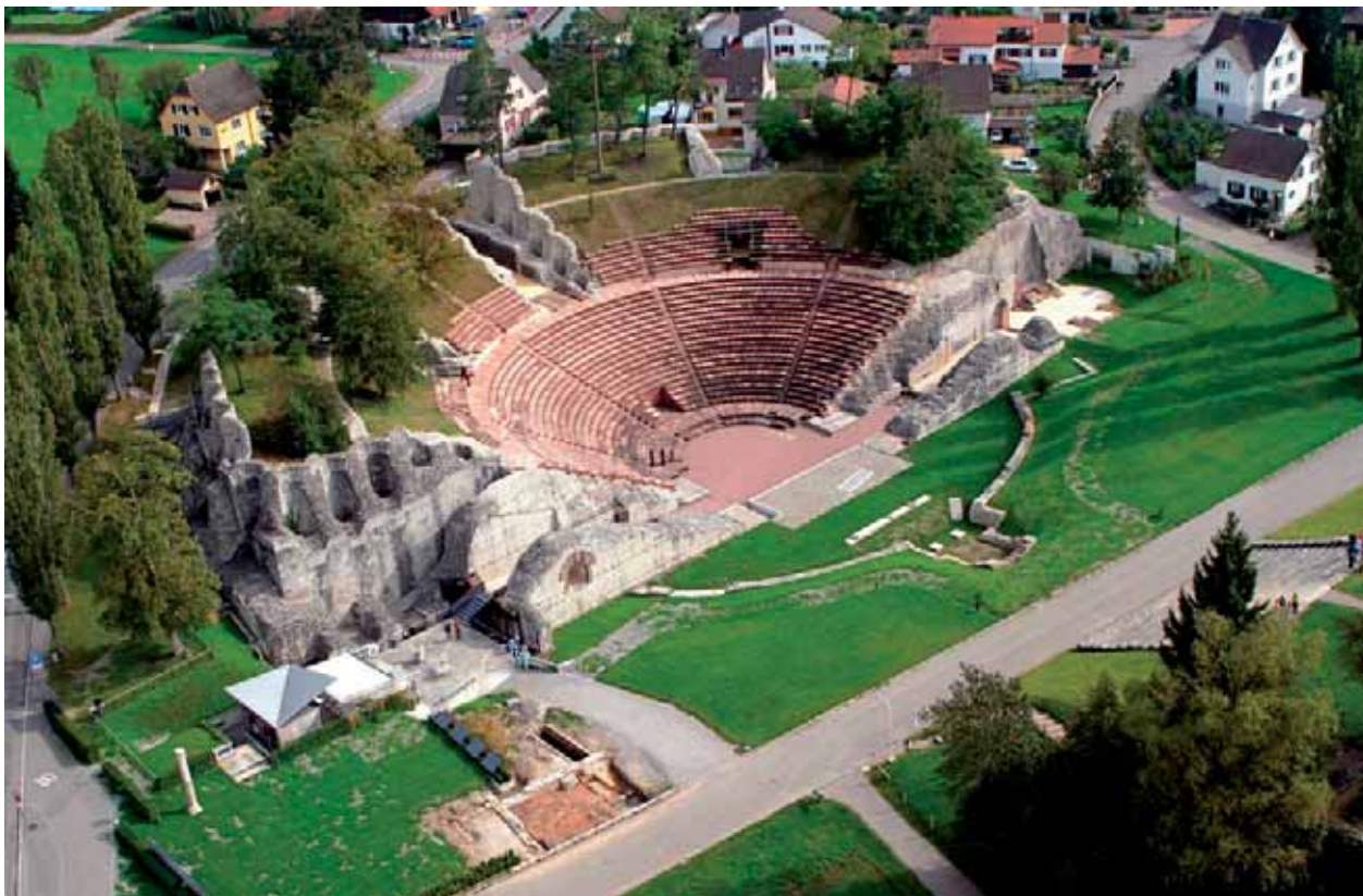
Abb. 1: Augst, Theatersanierung (Grabung 2007.055). Das Augster Theater nach Beendigung der jüngsten Restaurierungskampagne mit rekonstruierten Sitzstufen im ersten und zweiten Rang. Übersicht von Nordwesten.
