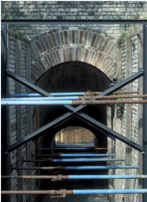
Abb. 51: Augst, Theatersanierung (Grabung 1992–2007.055). Die Auflast durch die Aufhöhung der Mauerzüge des sogenannten Südost-Vomitoriums im Jahre 1941 führte zu grossen statischen Problemen. Die seitlichen Mauerzüge mussten abgespriesst und der Zugang aus Sicherheitsgründen geschlossen werden (links). Bereits vor Beginn des Sanierungsprojekts wurde 1988 der Zugang zum Mittelvomitorium gesperrt, um das Publikum nicht zu gefährden (rechts).
