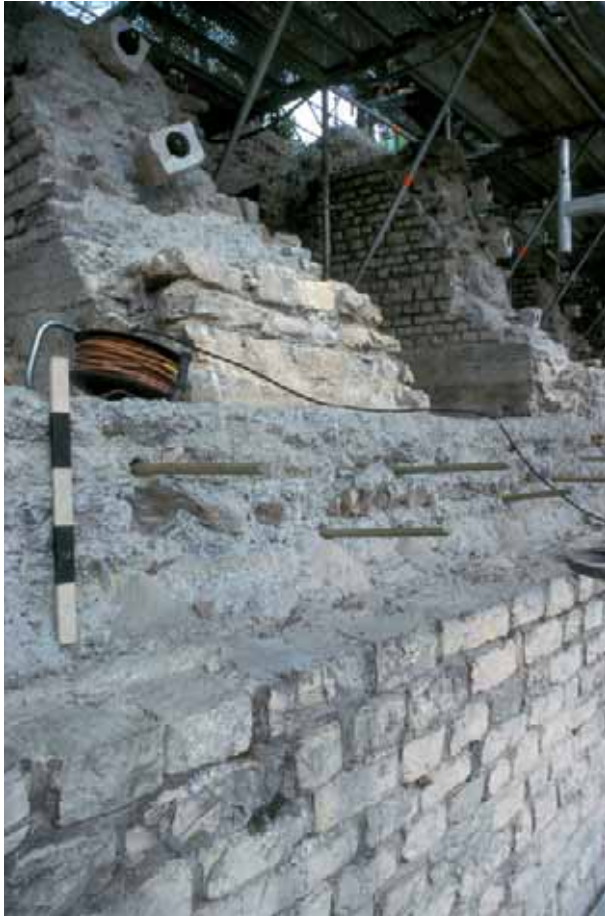
Abb. 56: Augst, Theatersanierung (Grabung 1992–2007.055). Peripheriemauer Keil 3, Blick von Süden. Kurze Glasfaseranker (im Vordergrund) und Glasfaserdübel mit verschraubtem Ankerkopf (Hintergrund, oben) verbessern die Verbindung zwischen antikem Mauerkern und moderner Vormauerung.
