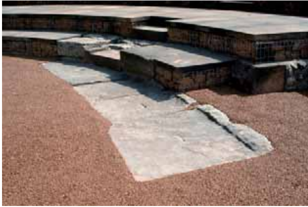
Abb. 23: Augst, Theatersanierung (Grabung 2007.055). Verfestigter Bodenbelag in der Orchestra, Detail mit Anschluss an die originalen Bodenplatten. Blick von Westen.
