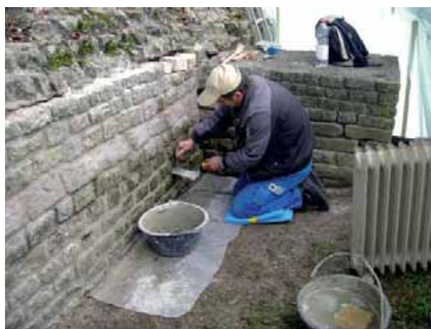
Abb. 96: Augst, Augusta Raurica. Der Sockelbereich der Basilica-Ostmauer wurde neu ausgefugt (im Bild Mladen Puklin von der Firma Markus Fux AG).
