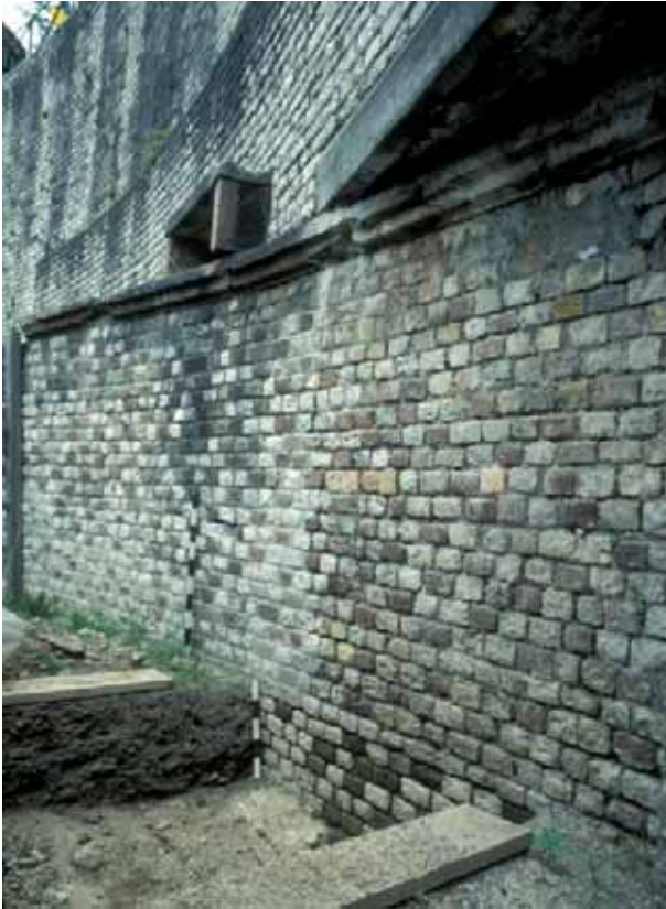
Abb. 16: Augst, Theatersanierung (Grabung 1992–2007.055). Ansicht an die äussere Begrenzungsmauer des untersten Couloirs des älteren szenischen Theaters. Die Mauer weist noch die originale Abdeckung aus einfach profilierten Buntsandsteinplatten auf; die Buntsandstein-Handquader sind so in das beige-graue Kalksteinmauerwerk integriert, dass ein dekoratives Muster entsteht.
