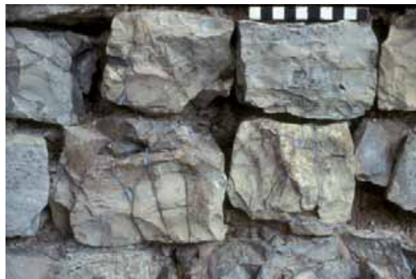
Abb. 59: Augst, Theatersanierung (Grabung 1992–2007.055). Die Kalkstein-Handquader der Mauerschalen weisen durch Alter und Witterung, aber auch durch Frosteinwirkung unzählige Haarrisse auf. In aufwendiger Feinarbeit wurden die Steinstücke verklebt und die Mauerschalen so wieder geschlossen.
