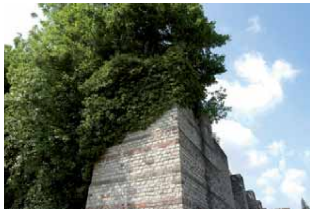
Abb. 93: Augst, Augusta Raurica. Der Pflanzenbewuchs auf der Krone der Basilica-Nordmauer verursacht viel Schaden an der Verblendung wie auch im Mauerkerne.
