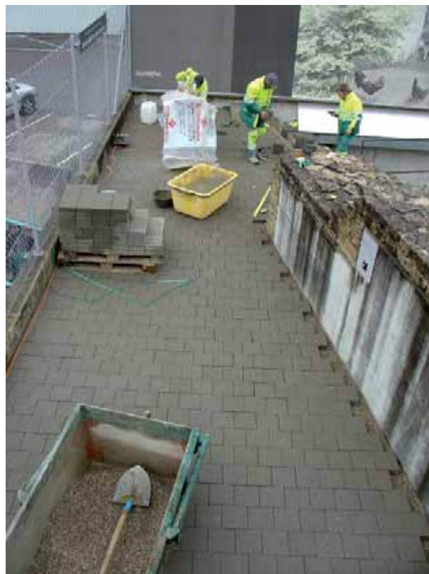
Abb. 100: Augst, Augusta Raurica. Der Splittbelag (Abb. 99) beim Zugang des Unterirdischen Brunnenhauses wurde auf Wunsch der Firma E. Frey AG durch Betonsickersteine ersetzt.
