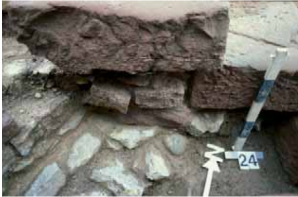
Abb. 7: Augst, Theatersanierung (Grabung 2007.055). Zone westlich des Westcarcars; Ostseite der älteren Mauer aus der Zeit vor den Theaterbauten. Die Situation, wonach der Mauerzug ausgebrochen wurde, um sekundär die Sandsteintreppe einzusetzen, ist gut erkennbar; das Fundament der Mauer zieht eindeutig unter den Treppenstufen durch, das aufgehende Mauerwerk ist gemäss der Unterkante der Treppe abgebrochen. Blick von Süden.
