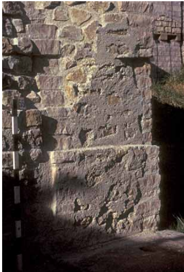
Abb. 77: Augst, Theatersanierung (Grabung 1992–2007.055). Amphitheater, Westcarcer. Zum besseren Verständnis der baulichen Situation wurden die Negative der Gewändequader der Carcerpforte wieder hergestellt. Die Rekonstruktion wurde durch die in den 1920er-Jahren dokumentierten Quaderabdrücke ermöglicht. Blick von Südwesten.
