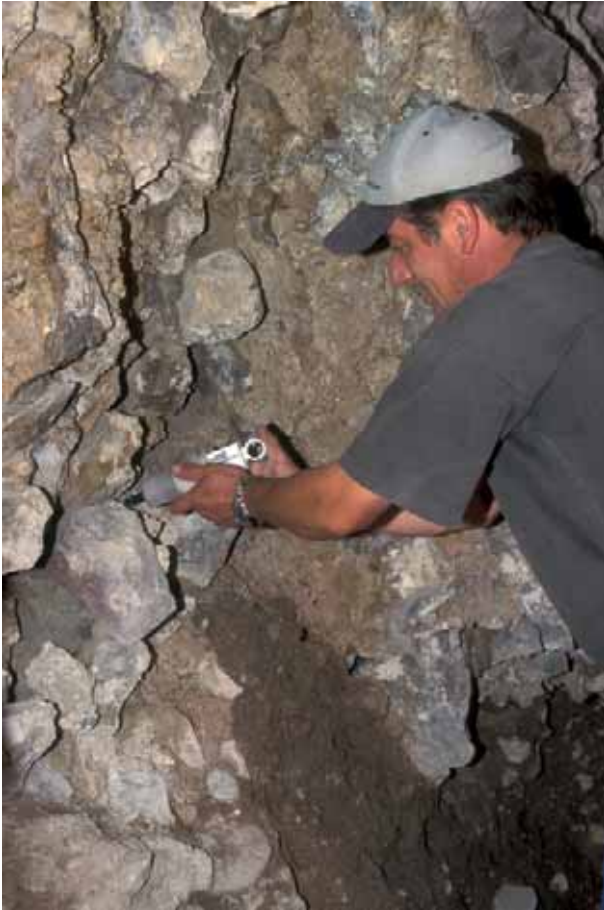
Abb. 27: Augst, Theatersanierung (Grabung 2007.055). Sanierung des Versturzsprofils über den Sandsteinfundamenten der nördlichen Eingangshalle des Theaters. Mladen Puklin, Mitarbeiter der Firma Fux AG, festigt das aufgelockerte Mörtelmaterial durch Applikation einer Kalkemulsion.
