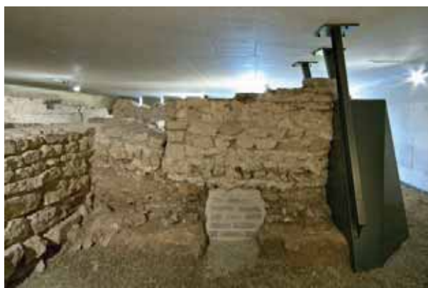
Abb. 50: Kaiseraugst, Annexbauten nördlich der Kastellkirche St. Gallus. Der Mauerklotz in der Bildmitte ist das Fundament eines winzig kleinen («Bade»-)Beckens, das bislang als frühchristliches Taufbecken neben der Kirche St. Gallus galt. Weil der ganze Bereich vom Erdsockel wegzukippen drohte, musste ein Teil des Fundaments mit einer eingebauten Stahlwand abgestützt werden (Abb. 49). Auch die neusten Sondierlöcher unter diesem späten Becken-Einbau mussten wieder zugeschüttet werden. Aus statischen Gründen erfolgte dies durch Backsteine (Bildmitte unten). In nächster Zeit sollen hier auch die didaktischen Informationen und die Ausstellung in der Vitrine (verdeckt rechts im Hintergrund) den Erkenntnissen des aktuellen Forschungsprojektes angepasst werden.
