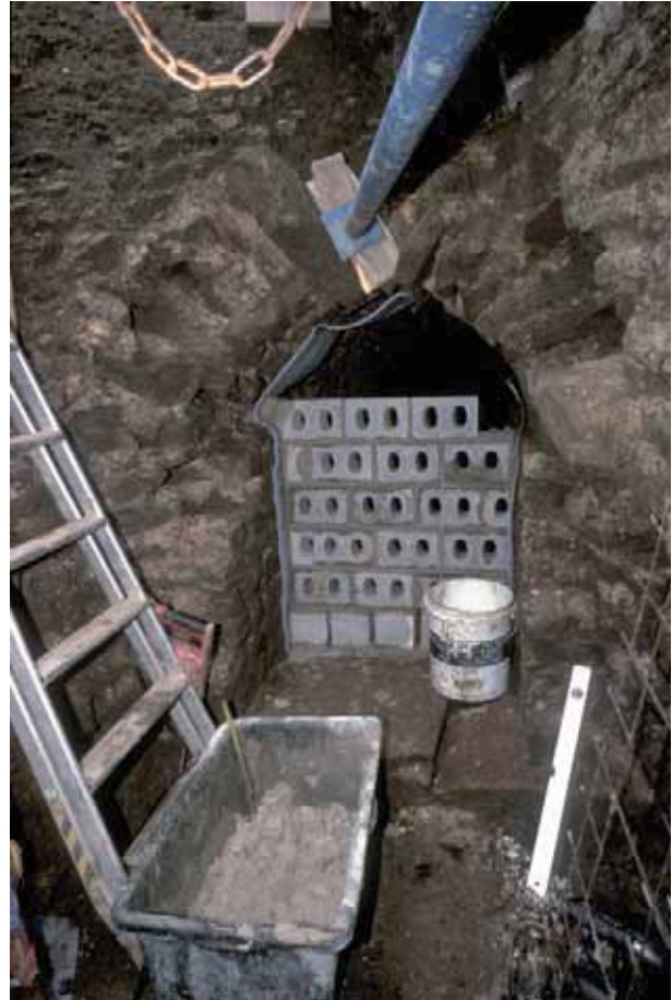
Abb. 2: Augst, Theatersanierung Grabung (2006). Das Westende des durch die Theaterparzelle führenden Abwasserkanals wird mit einer Mauer-scheibe aus modernen Kalksandsteinen verschlossen. Im Bild deutlich sichtbar die über Ölbohrte Kanalkonstruktion.
