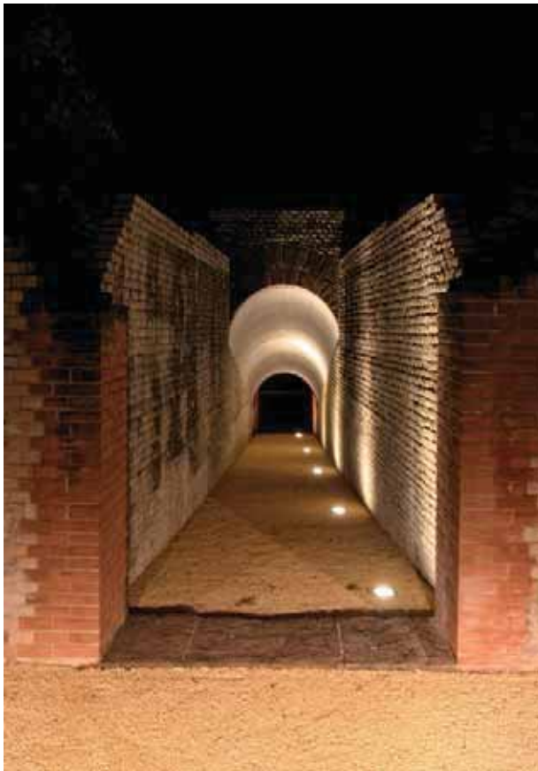
Abb. 1: Augst, Theatersanierung Grabung 2006. Monumentenbeleuchtung, Blick von der Peripherie durch das so genannte Südost-Vomitorium.
