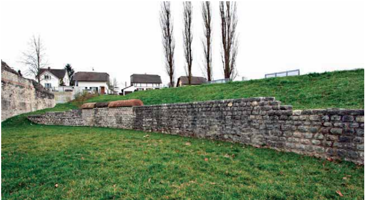
Abb. 10: Augst, Theatersanierung Grabung 2006 (Süd). Südöstliche Podiumsmauer des Amphitheaters, Ansicht über die fertig sanierte Mauerpartie.
