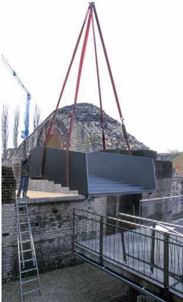
Abb. 10: Augst, Theatersanierung Grabung 2006. Eine Brückenkonstruktion aus Stahl wird mit dem Pneukran an ihren Platz zwischen Kioskplattform und ordaditus gebracht, so dass in Zukunft die Besucherinnen und Besucher entlang der antiken Zugangsachsen in die Orchestra gelangen können.
