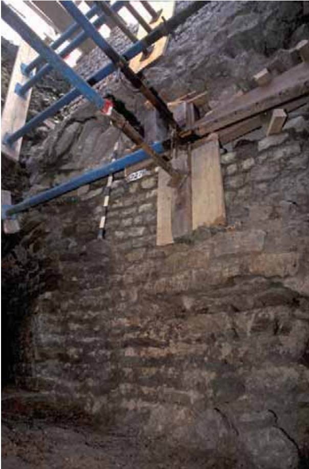
Abb. 1: Augst, Theatersanierung Grabung (2006). Sondierung Feld 1/2 ermöglicht das detaillierte Studium der komplexen mehrphasigen Mauerbefunde.
