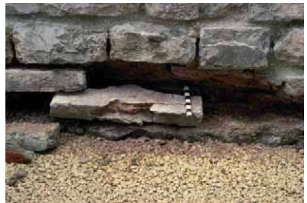
Abb. 11: Augst, Theatersanierung Grabung 2006 (Süd). Südost-Vomitorium: die zusammengeklebte Ziegelplatte wird an ihrem ursprünglichen Ort wieder in den Mauerbefund eingefügt.
