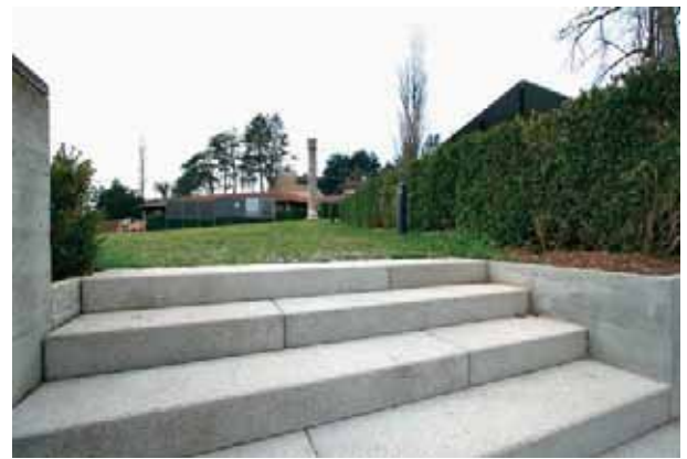
Abb. 11: Augst, Theatersanierung Grabung 2006. Der neu gestaltete Versammlungsplatz im nord-östlichen Theater-Vorfeld.
