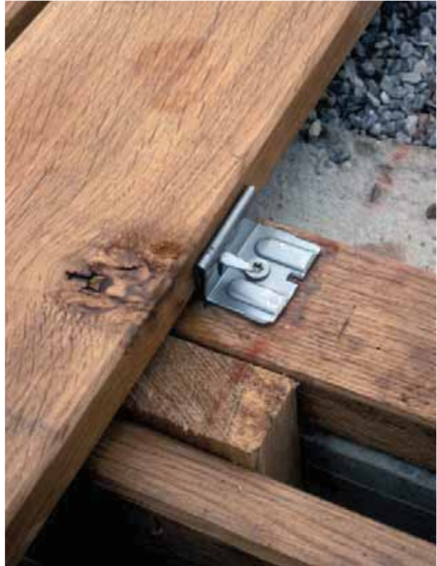
Abb. 2: Augst, Theatersanierung Grabung 2006. Einbau des Bühnenbodens aus Eichenbrettern: Die Dornen des Montagesystems werden seitlich in das nachfolgende Bodenbrett gedrückt, dadurch dringt weniger Regenwasser in die Hölzer ein und die Lebensdauer des Bodens wird verlängert.
