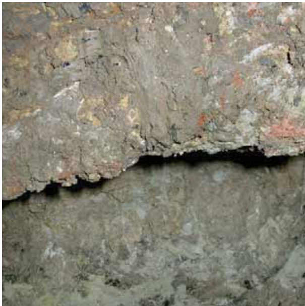
Abb. 24: Kaiseraugst AG, Wacht/Künzli (Grabung 2006.004). Sodbrunnen. Kavernenartige Aushöhlungen.
