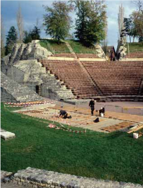
Abb. 1: Augst, Theatersanierung Grabung 2006. Einbau des Bühnenbodens aus Eichenbrettern durch Mitarbeiter der Holzbaufirma K. Graf, Mairach.
