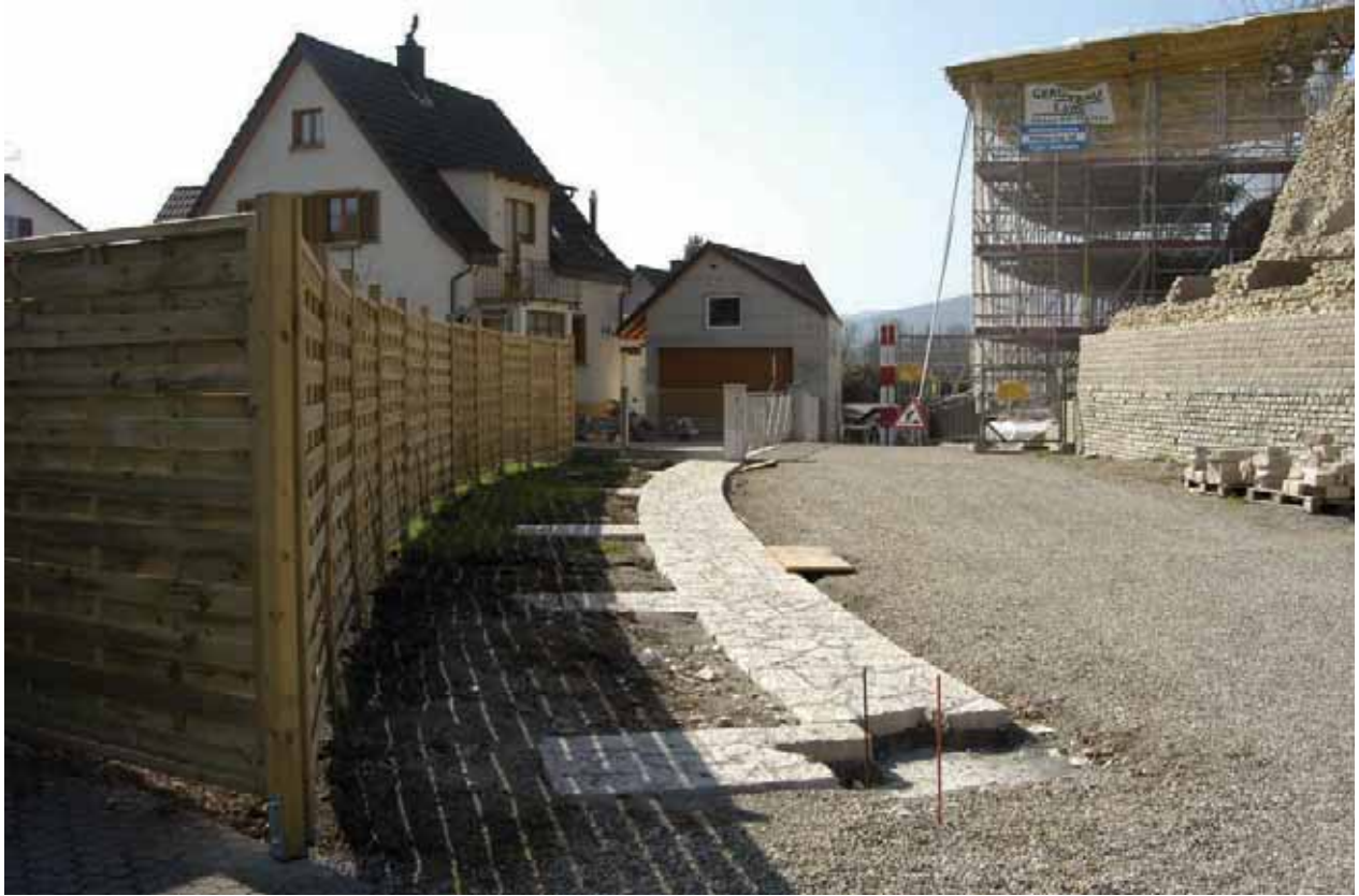
Abb. 67: Augst, Augusta Raurica, Theatersanierung. Rechts das letzte grosse Baugerüst der mehrjährigen Konservierungsarbeiten, von welchem aus die Mauerarbeiten an der Peripherie von Keil 4 ausgeführt werden konnten. Im Vordergrund ist der Grundriss des Ersten Theaters im Boden markiert, hier konkret die Peripheriemauer mit kleinen Strebepeilern in kurzen Abständen. Links im Bild die neu erstellte Sichtschutzwand gegen einen Privatgarten. Dank der Grundeigentümerin, der Stiftung Pro Augusta Raurica, konnte die alte Hecke mit Gartenmauer über dem Theaterbefund entfernt und der neue Zaun einige Meter innerhalb der Parzelle errichtet werden. So haben die Besucher ein einprägsames Gesamtbild vom Grundriss des ältesten Theaters von Augusta Raurica.
