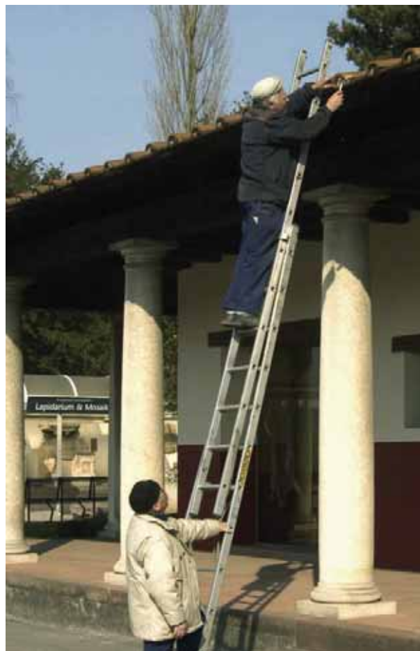
Abb. 69: Augst, Augusta Raurica. Am Römerhausdach müssen im Rahmen des normalen Unterhalts – aber in antiker Weise – die Hohlräume zwischen den untersten Leisten- und Hohlziegeln mit Kalkmörtel ausgefügt werden.
