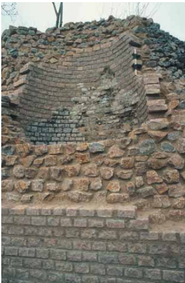
Abb. 41: Augst, Theatersanierung (Grabung 2005.055). Peripherie, Keil 4. Entlastungsbogen MR 138. Einzelne vorgesetzte Blendquader und eine zurückhaltend ausgeführte Übermörtelung des Mauerkerne bieten optimalen Schutz für die originalen Mauerpartien.
