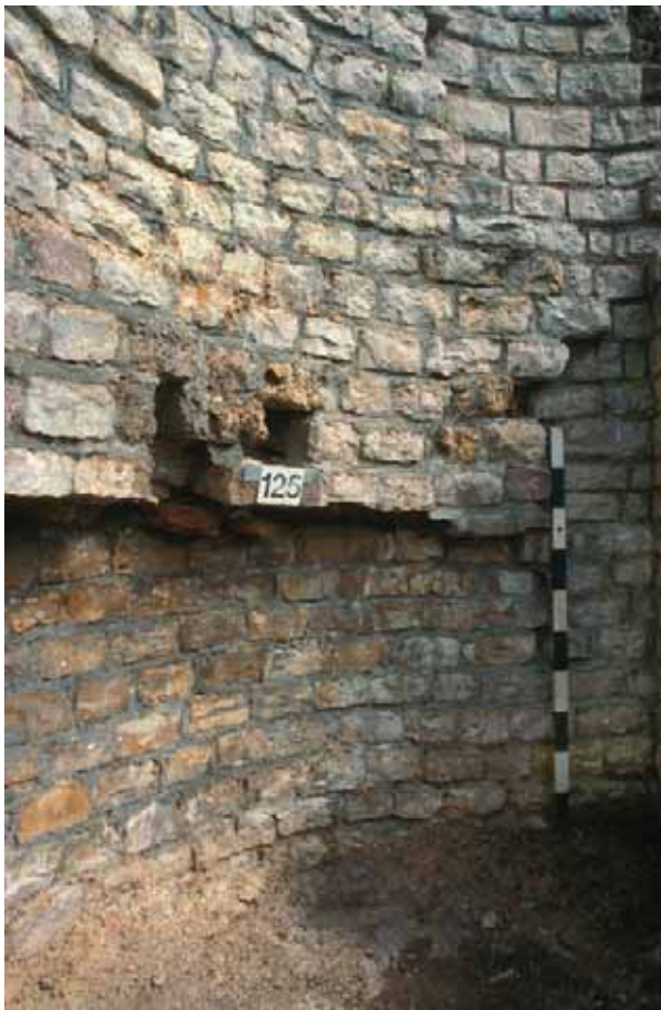
Abb. 36: Augst, Theatersanierung (Grabung 2005.055). Peripherie, Keil 4. Entlastungsbogen MR 141 mit horizontal verschobenem, originalem Kalksteinmauerwerk.
