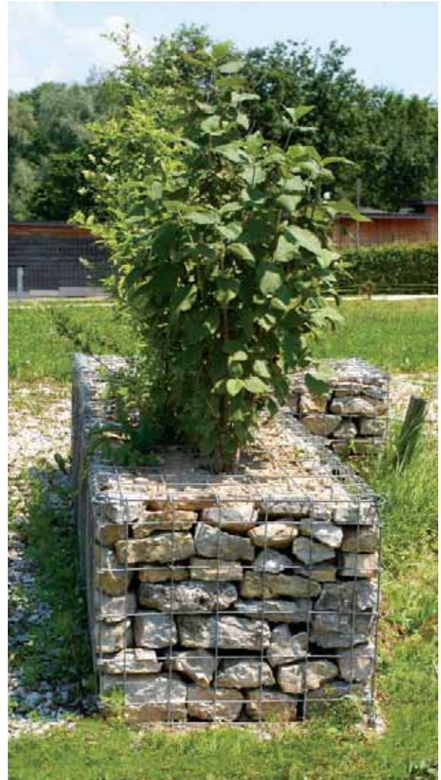
Abb. 19: Augst/BL, Augusta Raurica, Schwarzacker. Prototyp einer Reihe von Drahtkörben, gefüllt mit mauerartig aufgeschichteten Handquaden aus Kalkstein und gefüllt mit Humus und Heckenpflanzen (im Vordergrund: Wolliger Schneeball). In den Körben eingelegte Folien (und gelegentliches Zurückschneiden der Pflanzen) verhindern ein Wurzelwachstum unter die Erdoberfläche in die archäologischen Kulturschichten. Das Bild wurde ein Jahr nach der Anpflanzung im Frühjahr 2006 aufgenommen.
