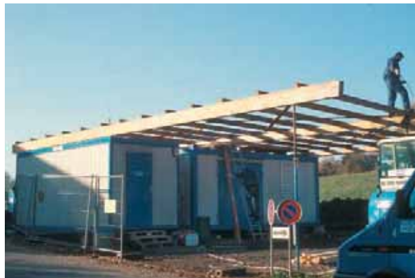
Abb. 55: Augst, Theatersanierung (Grabung 2005.055). Erstellen der redimensionierten, provisorischen Baustelleneinrichtung für die im Jahr 2006 verbleibenden Arbeiten; Aufbau von Büro- und Mannschaftscontainer auf dem Gelände jenseits der modernen Sichelenstrasse.
