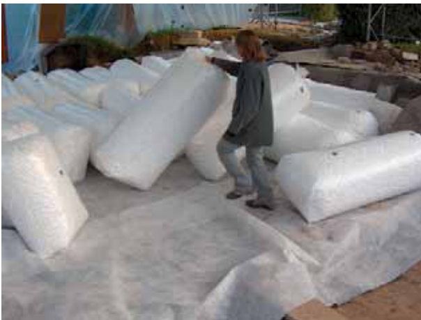
Abb. 50: Augst, Theatersanierung (Grabung 2005.055). Ziegelmosaikboden im nordwestlichen Theater-Vorgelände. Aufbau der provisorischen Wintersicherung, Margareth Warburton verteilt die mit Polysterolchips gefüllten Plastiksäcke als Isolation gegen Frost.
