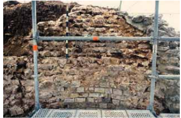
Abb. 40: Augst, Theatersanierung (Grabung 2005.055). Peripherie, Keil 4. Entlastungsbogen MR 138 mit freiliegendem, von Frost und Erosion stark in Mitleidenschaft gezogenem Mauerkerne.
