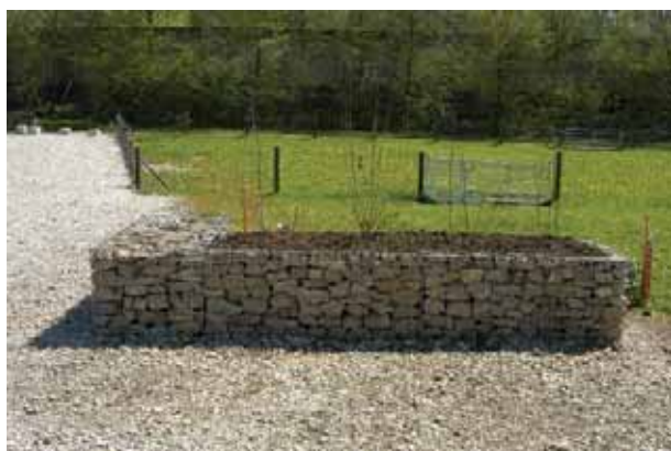
Abb. 68: Von der Ideenskizze bis zum Prototyp: Muster für eine Markierungsmöglichkeit römischer Mauerfluchten zur Veranschaulichung antiker Baufuchten im Freilichtmuseum. Drahtgitterkörbe sind mit Bruchsteinen (analog den römischen Mauern, aber ohne Mörtel) und mit einer dünnen Betonschicht oder Wurzelsperffolie ausgekleidet. In der Mitte sind sie mit Erde gefüllt und mit winterharten einheimischen Kleingehölzen bepflanzt. Die Konstruktion erfüllt sowohl die didaktisch angestrebte Assoziation «römische Mauer» bzw. «Baufucht» als auch den Schutz der ungestörten Kulturschichten vor unerwünschter Durchwurzelung und Auslaugung (das Anpflanzen von Hecken und Alleen zur Markierung antiker Bebauungslinien bzw. Strassenfluchten hingegen wäre ein grosses konservatorisches Risiko für die Fundschichten).
