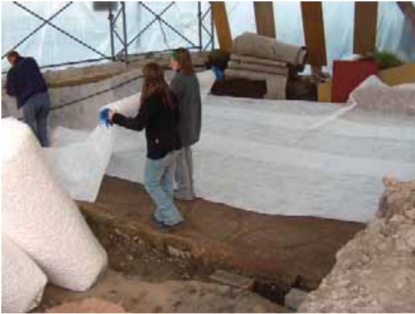
Abb. 49: Augst, Theatersanierung (Grabung 2005.055). Ziegelmosaikboden im nordwestlichen Theater-Vorgelände. Aufbau der provisorischen Wintersicherung, Einbringen des Geovlieses über dem Ziegelestrich durch die Ferienjobberinnen Margareth Warburton und Julia Baumann.
