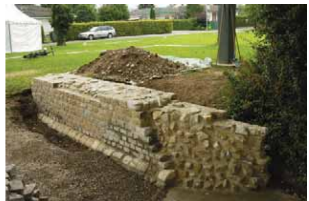
Abb. 60: Augst, Augusta Raurica. Die fertig konservierte Mauer neben der Curia (Abb. 59). Für einen nachhaltigen Schutz ist noch eine partielle Humusabdeckung mit dichtem Grasbewuchs erforderlich (vgl. Abb. 58).
