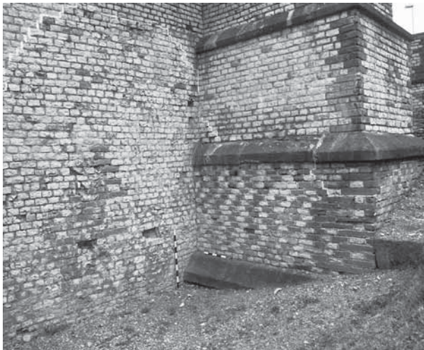
Abb. 11: Augst, Theatersanierung (Grabung 2001.055). Grundlagen zur Erarbeitung eines Auswertungskonzepts. Jüngeres szenisches Theater, Keil 4; Reparatur (?) mit aus Muschelkalk- und Buntsandstein-Handquadern gebildetem Muster, das sich ausschliesslich in dieser Zone beobachten lässt.
