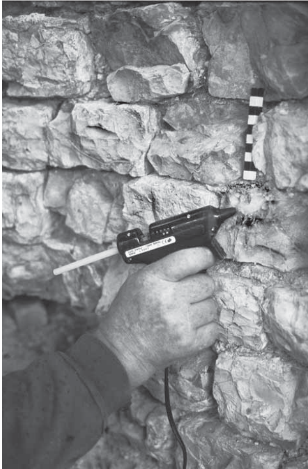
Abb. 39: Augst, Theatersanierung (Grabung 2004.055). Peripheriebereich Keil 3, Mauerinnenschale des Entlastungsbogens MR 131. Detail der Feinrestaurierung von Mauerschalen: Vor dem Ausinjizieren von Haarrissen in den Muschelkalkquadern der Mauerschale mit einem Injektionsharz werden mögliche Flüssigkeitsaustritte mit einem Heissiegelkleber abgedichtet. Maurer Max Heid mit der Klebepistole.
