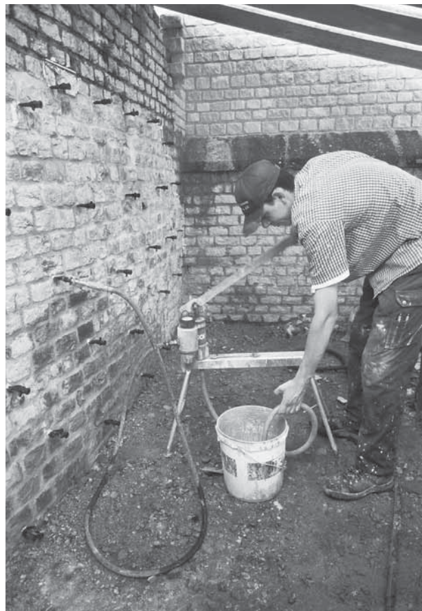
Abb. 46: Augst, Theatersanierung (Grabung 2004.055). Peripheriebereich Keil 4 (MR 58): Einpumpen des Injektionsmörtels in die Mauerkluft; Maurer Dominik Fux mit der Handkolbenpumpe. Blick von Süden, im Hintergrund Pfeiler MR 195.
