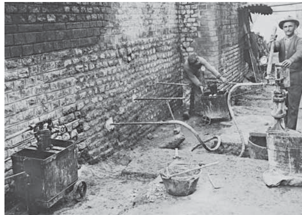
Abb. 22: Augst, Theatersanierung (Grabung 1934.059). Grundlagen zur Erarbeitung eines Auswertungskonzepts. Injektionsarbeiten an den Mauern des Südaditus im Jahre 1934; Einbringen von Portlandzementmasse mit der Handpumpe unter niedrigem Druck.
