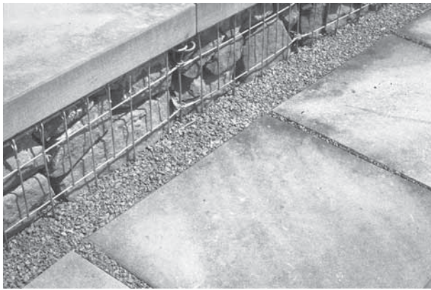
Abb. 25: Augst, Theatersanierung (Grabung 2004.055). Rekonstruktion des Sitzstufenbereichs: Die Zwischenräume hinter den aus Normmassen gefertigten Sandsteinplatten der Sitzstufen wurden mit Granitsplitt geschlossen. Im Hinblick auf zukünftige Unterhalts- und Reinigungsarbeiten wurden die Granitsplitt mit einem Kieskleber verfestigt.
