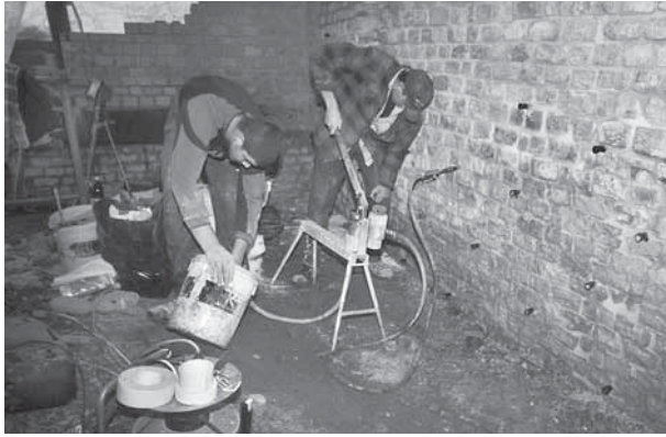
Abb. 47: Augst, Theatersanierung (Grabung 2004.055). Peripheriebereich Keil 4 (MR 58): Einpumpen des Injektionsmörtels in die Mauerklufft; an der Handkolbenpumpe arbeiten Dominik Fux und Mubekir Hajrizi. Blick von Osten, im Hintergrund Pfeiler MR 196.
