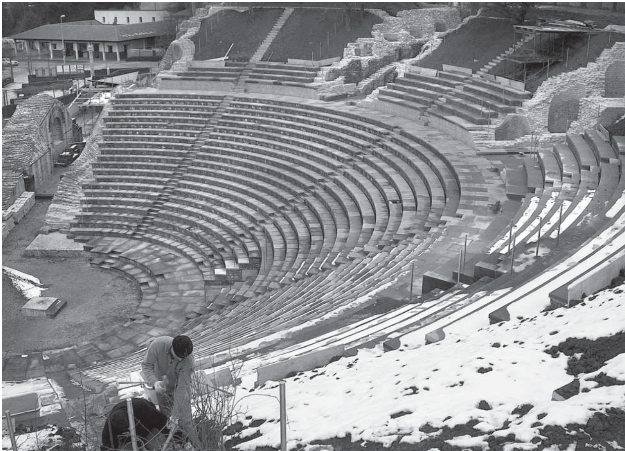
Abb. 23: Augst, Theatersanierung (Grabung 2004.055). Rekonstruktion des Sitzstufenbereichs: Im frisch mit Erde angeböschten Bereich des zweiten Sitzstufenrangs zeichnen sich die Stirnbretter der Treppenläufe, die im oberen, nicht mit Sitzstufenkörben rekonstruierten Teil von Rang 2 provisorisch erscheinen sollen, noch überdeutlich ab. Blick von Osten.
