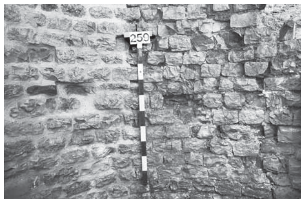
Abb. 38: Augst, Theatersanierung (Grabung 2004.055). Peripheriebereich Keil 3, Mauerinnenschale des Entlastungsbogens MR 131. Am gezeigten Mauerausschnitt lassen sich die verschiedenen Restaurierungsabläufe erkennen: Am rechten Bildrand ist der Zustand des Mauerwerks vor Beginn der Arbeiten erkennbar; die mit Zement geschlossenen antiken Mauerfugen werden ausgespitzt (Bildmitte), schadhafte Schalenquader geklebt und das Mauerwerk mit dem im Berichtsjahr entsprechend den neuen Erkenntnissen modifizierten Mörtel neu verfügt (linker Bildrand).
