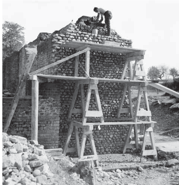
Abb. 20: Augst, Theatersanierung (Grabung 1938.059). Grundlagen zur Erarbeitung eines Auswertungskonzepts. Improvisiertes «Baugeriüst» bei den Restaurierungsarbeiten am Nordaditus im Jahre 1938.
