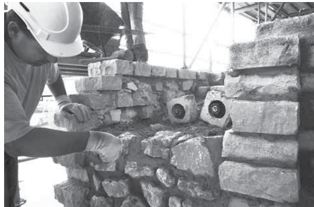
Abb. 37: Augst, Theatersanierung (Grabung 2004.055). Peripheriebereich Keil 3 (MR 58): Die Schraubenmutter der Glasfaseranker werden in den Mauerwerk integriert. Maurer Agim Delija beim Erstellen der neuen Kernvormauerung.
