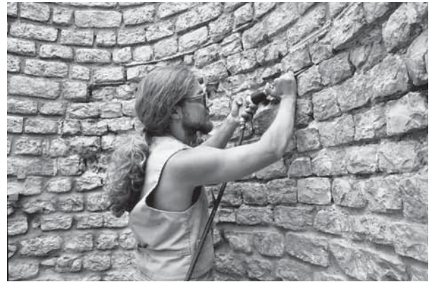
Abb. 34: Augst, Theatersanierung (Grabung 2003.55). Sanierung originaler Mauerschalen. Steinbildhauer Flavian Naber bei Konservierungsarbeiten an einem der Entlastungsbögen der Peripherie von Keil 1. Nach dem Ausspitzen der bei neuzeitlichen Restaurierungen angebrachten, harten Fugen aus Portlandzement werden vorhandene Frostschäden am Kalksteinmauerwerk repariert. Danach muss das Mauerwerk mit einem «weicheren» Restauriermörtel neu verfugt werden.
