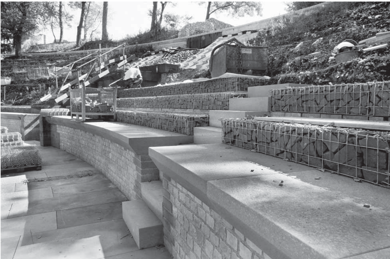
Abb. 29: Augst, Theatersanierung (Grabung 2003.55). Rekonstruktion der Sitzstufen im zweiten Rang. Aufbau der modernen Korbkonstruktion in Keil 4, im Vordergrund die Gürtelmauer der ersten praecinctio mit den gefasten Sandstein-Abdeckplatten und dem Treppendurchbruch zum zweiten Rang.
