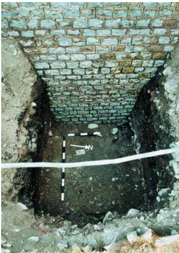
Abb. 4: Augst, Theatersanierung (Grabung 2003.55). Peripheriemauer (MR 58) Keil 3. Sondierloch an der Peripheriemauer, Übersicht. Zweiphasiger, gut erhaltener, rot bemalter Fugenstrich in situ an der Mauerschale von MR 58.
