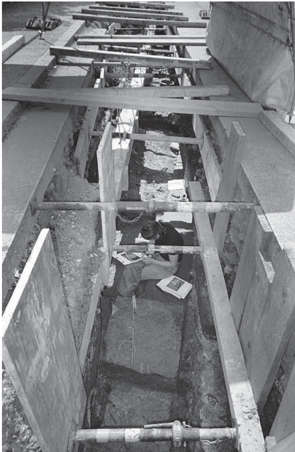
Abb. 6: Augst BL, Wasserleitung Giebenacherstrasse (Grabung 2003.51). Spriessungen, ein schmaler Graben, eine schleifend geschnittene Mauer und irgendwo zwischendrin die Archäologin (Barbara Pfäffli) am Dokumentieren – Alltag einer Leitungsgrabung.
