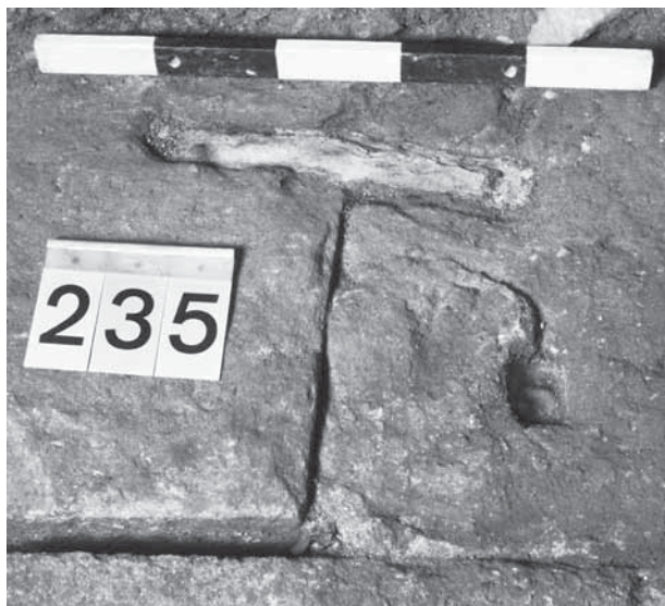
Abb. 17: Augst, Augusta Raurica. Theater-Nordwestecke, Fundament des Dritten (Szenischen) Theaters. Eiserne Bauklammer mit Verbleiung in situ. Diese Verbleiung wurde nicht analysiert; die eiserne Klammer wurde im Monument belassen (vgl. Tab. 4). Der Befund ist heute mit Schutt überdeckt. M. ca. 1:7.
