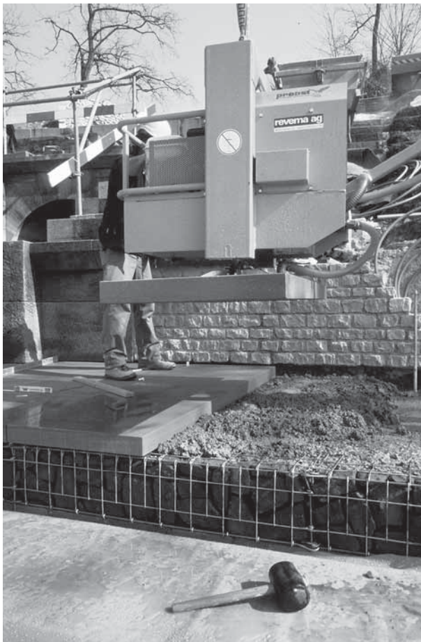
Abb. 22: Augst, Theatersanierung (Grabung 2003.55). Rekonstruktion der Sitzstufen im ersten Rang. Versetzen des Plattenbelags des Diazoma-Umgangs (Umgang der ersten praecinctio). Steinmetz Hanspeter Witschi in Aktion mit dem Vakuum-Hebegerät.
