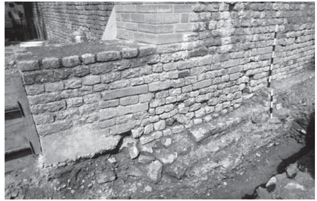
Abb. 14: Augst, Theatersanierung (Grabung 2003.55). Schwellensituation des Mittelvomitoriums. Innere Peripheriemauer 55 mit den darunter liegenden Mauern einer älteren Bauphase, wohl des älteren szenischen Theaters.
