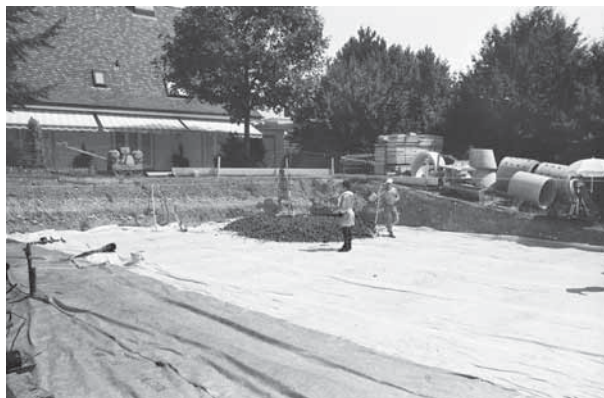
Abb. 39: Kaiseraugst AG, EFH Hockenjos, Äussere Reben (2003.05). Blick von Nordwesten auf die Trennfolie mit einer ersten Schüttung des Schaumglasschotter für die Isolationschicht. Im Osten steigt das Gelände an und unter der modernen Planierschicht liegen römische Schichten.
