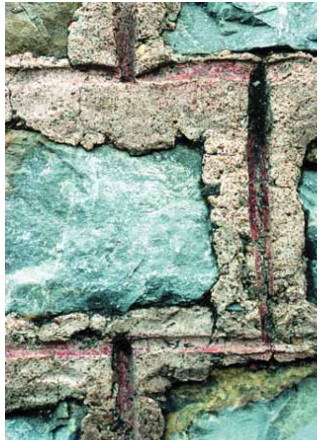
Abb. 3: Augst, Theatersanierung (Grabung 2003.55). Peripheriemauer (MR 58) Keil 3. Detail des hervorragend erhaltenen Fugmörtels mit eingedrücktem, U-förmigem Fugenstrich und dunkelroter Bemalung (Bereich der oberen, originalen Zone).
