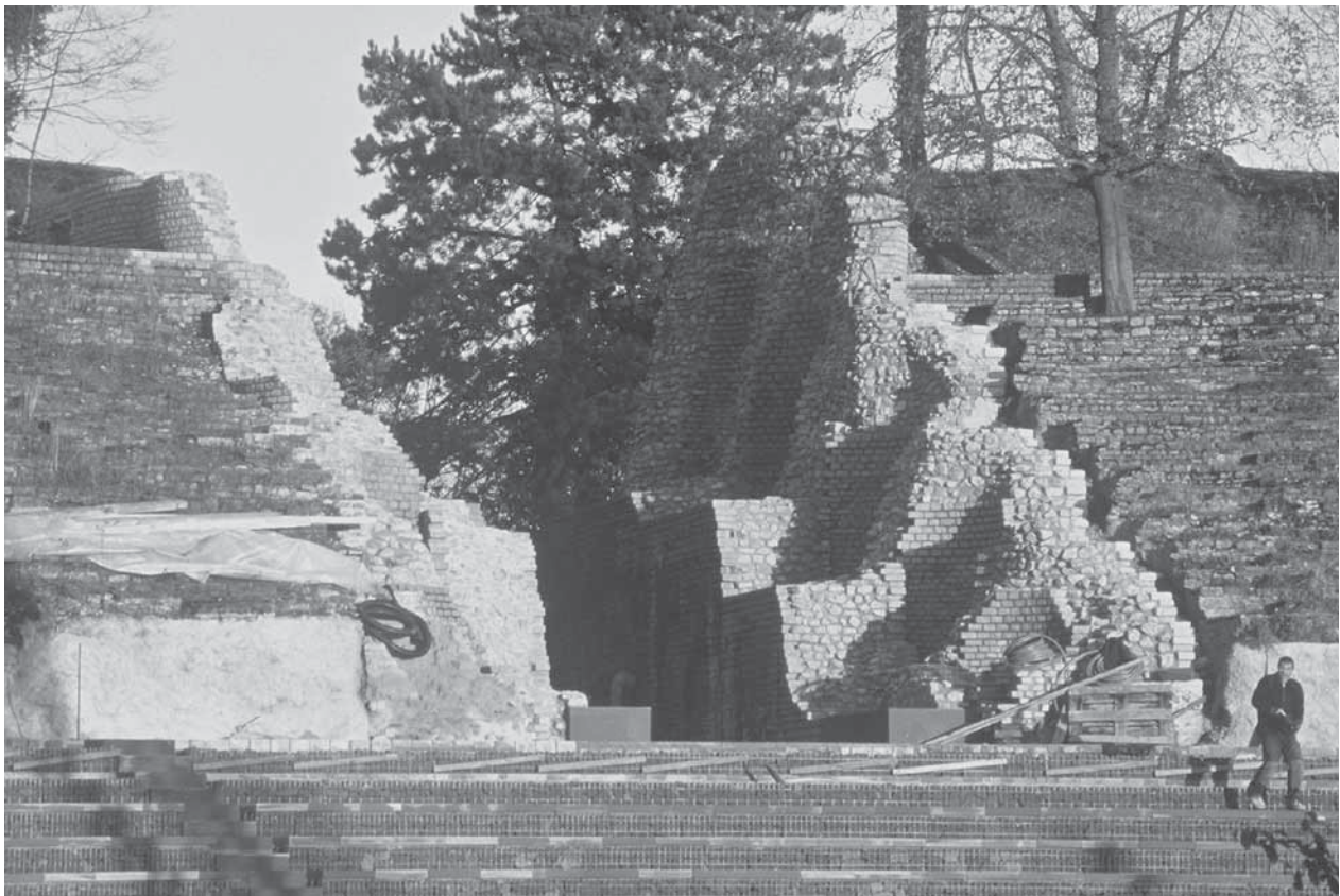
Abb. 40: Augst, Theatersanierung (Grabung 2002.55). Sanierungsarbeiten am Mittelvomitorium nach Fertigstellung der Sanierungsarbeiten von 2002. Die Wangenmauern und die Entlastungsbögen sind restauriert und wo nötig repariert. Die stark zerstörten modernen Kernvormauerungen in den oberen Bereichen wurden erneuert. Im Mündungsbereich zur cavea wurde die unterste Sandsteinquaderlage gemäss den im Baubefund erhaltenen Hinweisen ergänzt.
