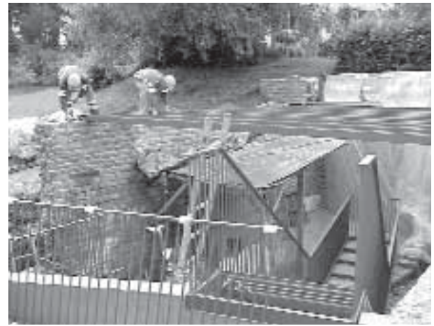
Abb. 41: Augst, Gebäude zwischen der Insula 9 und dem Theater. Konservierung «Bäckerei» und «Wachposten» (2002.907). Montage der Dachträger und des Laufstegs.
