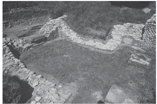
Abb. 42: Augst, Theatersanierung (Grabung 2002.55). Sanierungsarbeiten am Westcarcer des älteren Amphitheaters. Übersicht nach Entfernung der alten, stark beschädigten Zementrestaurierungen. Die antike Mauerkrone ist vollständig freigelegt, gereinigt und partiell injiziert. In einem nächsten Arbeitsschritt erfolgt das Aufbringen einer dampfdiffusionsfähigen Isolationschicht zum Schutz vor eindringendem Meteorwasser. Nach der Ergänzung der abgebauten Mauerteile folgt als Verschleisschicht eine den antiken Mauerkern imitierende Abdeckung aus Kalksteinschroppen.
