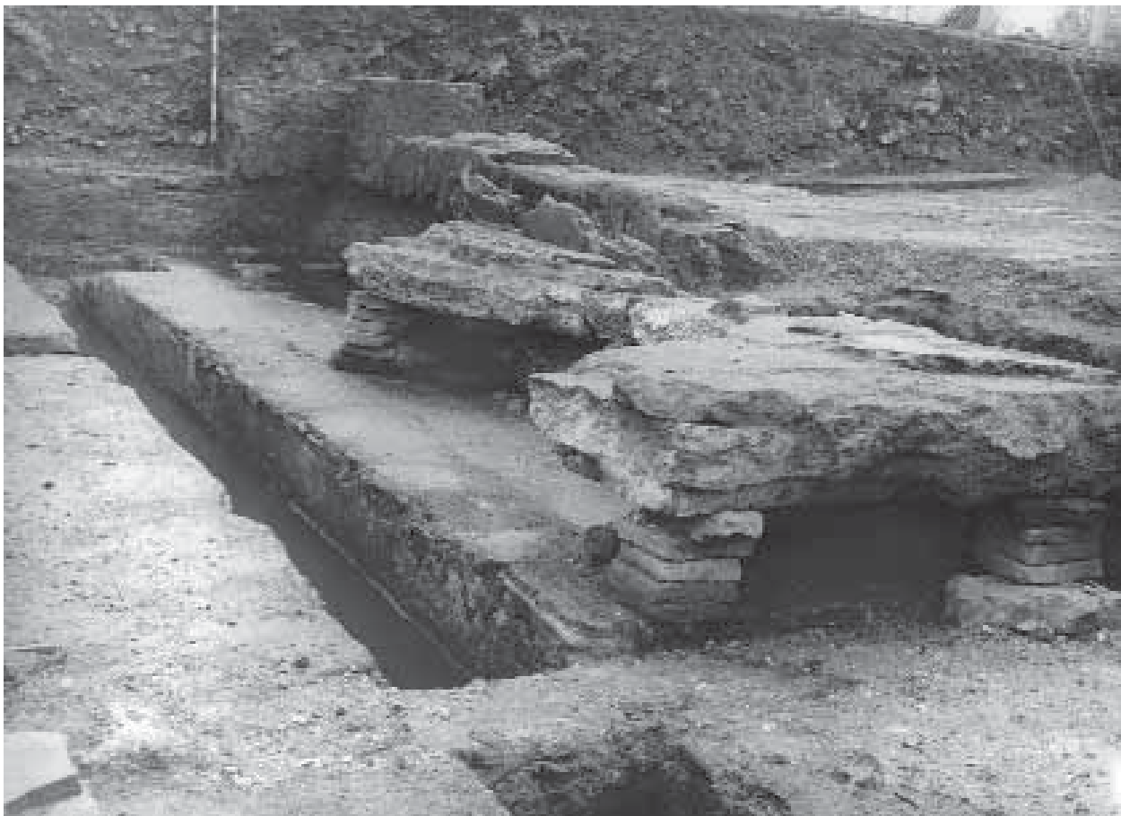
Abb. 15: Augst, BL, Thermenstrasse (Grabung 1937.51). Reste des auf Hypokaustpfeilern ruhenden Beckenbodens mit den Heissluft zuführenden Kanälen. Zustand 1937. Blick von Süden. Beim hinteren Teil des Beckenbodens handelt es sich um das gleiche Stück wie auf Abb. 14.
