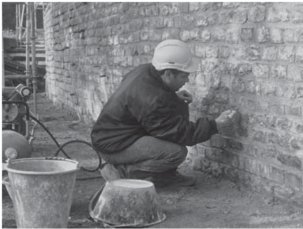
Abb. 41: Augst, Theatersanierung (Grabung 2002.55). Sanierungsarbeiten an der Peripherie von Keil 2. Arbeiter Salim Leghdeysi beim Neuverfugen der Mauerschalen.
