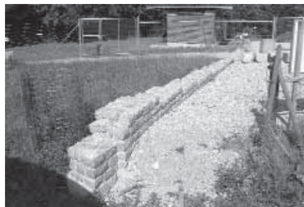
Abb. 49: Augst, Osttor (2002.902) Die im Areal der Publikumsgrabungen 2000–2002 neu aufgemauerte Mauer 9. Die Überbrückung mit Kalkgussmörtel über dem (hier bereits zugeschütteten) Originalfundament und der Teilrekonstruktion in Kalkbruchstein ist noch deutlich sichtbar, bevor der Maueranschluss mit Humus angeschüttet wird. Hinten rechts beim Zaun senkt sich die rekonstruierte Mauerkrone beim Überqueren der modernen Schwarzackerstrasse auf Fahrniveau ab, um dahinter im Bereich Osttor wieder zwei bis fünf Lagen anzusteigen.
