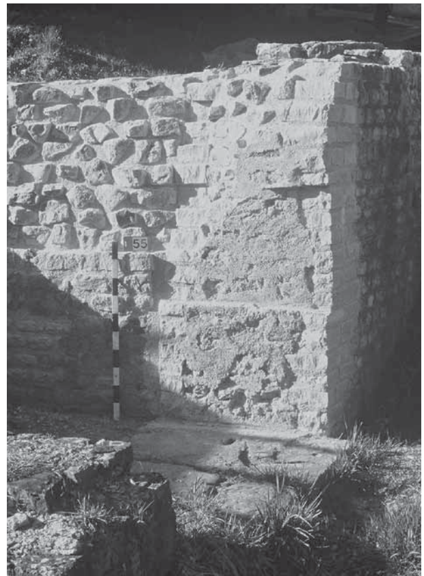
Abb. 43: Augst, Theatersanierung (Grabung 2002.55). Sanierungsarbeiten am Westcarcer des älteren Amphitheaters. Fertig gestellte Anschlüsse der Podiumsmauer an die Nordwestecke des Westcarcers. Wo einst Sandsteingewände der Carcerpforten eingebaut waren, finden sich heute, als Folge des antiken und frühneuzeitlichen Steinraubs, nur noch die beim Ausbrechen der Quader entstandenen Raubtrichter. Im Falle des Westcarcers konnte Karl Stehlin in den 1920er Jahren noch die im Kernmauerwerk der Podiumsmauer erkennbaren Negativabdrücke der einst vorhandenen Steinblöcke dokumentieren. Auf der Basis dieser Dokumentation wurden 2002 diese Quadernegative zum besseren Verständnis der baulichen Situation wieder hergestellt.
