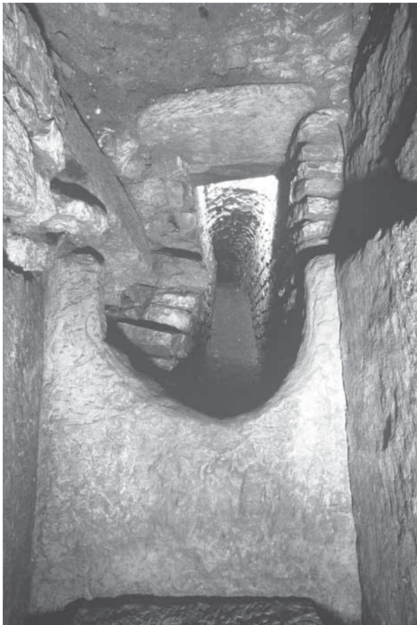
Abb. 24: Augst, Theatersanierung (Grabung 2002.55). Abwasserkanal, Verzweigung im Süden, südöstlicher Abschnitt mit Sandsteinkammer. Blick von Nordwesten, von der Sandsteinkammer aus in den südöstlichen Fortsetzungskanal. Im Zentrum die U-förmig ausgehauene Mündung; in der oberen Bildhälfte der Sandsteinarchitrav mit dem Entlastungsbogen aus Buntsandsteinecken (vgl. Abb. 27). Links der verstürzte Sandsteinarchitrav des von den Frauenthermen her kommenden, nordöstlichen Seitenkanals (vgl. Abb. 29).
