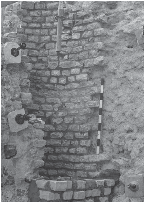
Abb. 38: Augst, Theatersanierung (Grabung 2002.55). Sanierungsarbeiten am Mittelvomitorium. Feinsanierung an den originalen Muschelkalk-Mauerschalen der Entlastungsbögen. Beschädigte Handquader werden, soweit möglich, mit speziellem Restauriermörtel geklebt oder ergänzt und «weicherer» Mörtel auf Kalkbasis ersetzt die entfernten harten Zementfugen der älteren Restaurierungen. Sämtliche geklebten Handquader werden für die Dauer der Arbeiten markiert (vgl. Mauerschale in oberer Bildhälfte), damit die Informationen am Schluss auf die Pläne der Restaurierungsdokumentation übertragen werden können.
