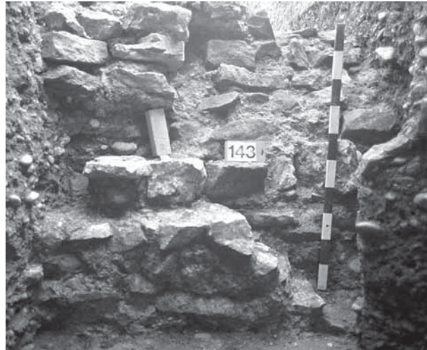
Abb. 12: Augst, Theatersanierung (Grabung 2002.55). Abwasserkanal, Einstiegschacht im nördlichen Abschnitt. Blick von Westen an die Kanalwange, das Gewölbe und die Aussenwand des Einstiegschachts. In der unteren Bildhälfte die abgetreppt verlaufende Baufuge, die zeigt, dass die Kanalwange rechts jünger sein muss als das Mauerstück links. Aufgrund des Mauerverlaufs und des Baubefunds auf der Innenseite des Abwasserkanals wird deutlich, dass es sich bei dem älteren Mauerstück links vermutlich um einen weiteren Rest der vortheaterzeitlichen Bebauung handelt, der in diesem Abschnitt in die Kanalwandung integriert wurde.
