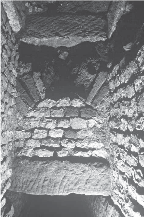
Abb. 14: Augst, Theatersanierung (Grabung 2002.55). Abwasserkanal, Verzweigung im Süden, südwestlicher Abschnitt. Einstiegschacht, Blick in Richtung Verzweigung. Über dem Sandsteinarchitrav der Mündung liegt der im Zentrum ausgebrochene Entlastungsbogen aus Buntsandsteinkeilen. Darüber die intakte Schachtrahmung aus grossen Buntsandsteinquadern; die Deckplatte fehlt.
