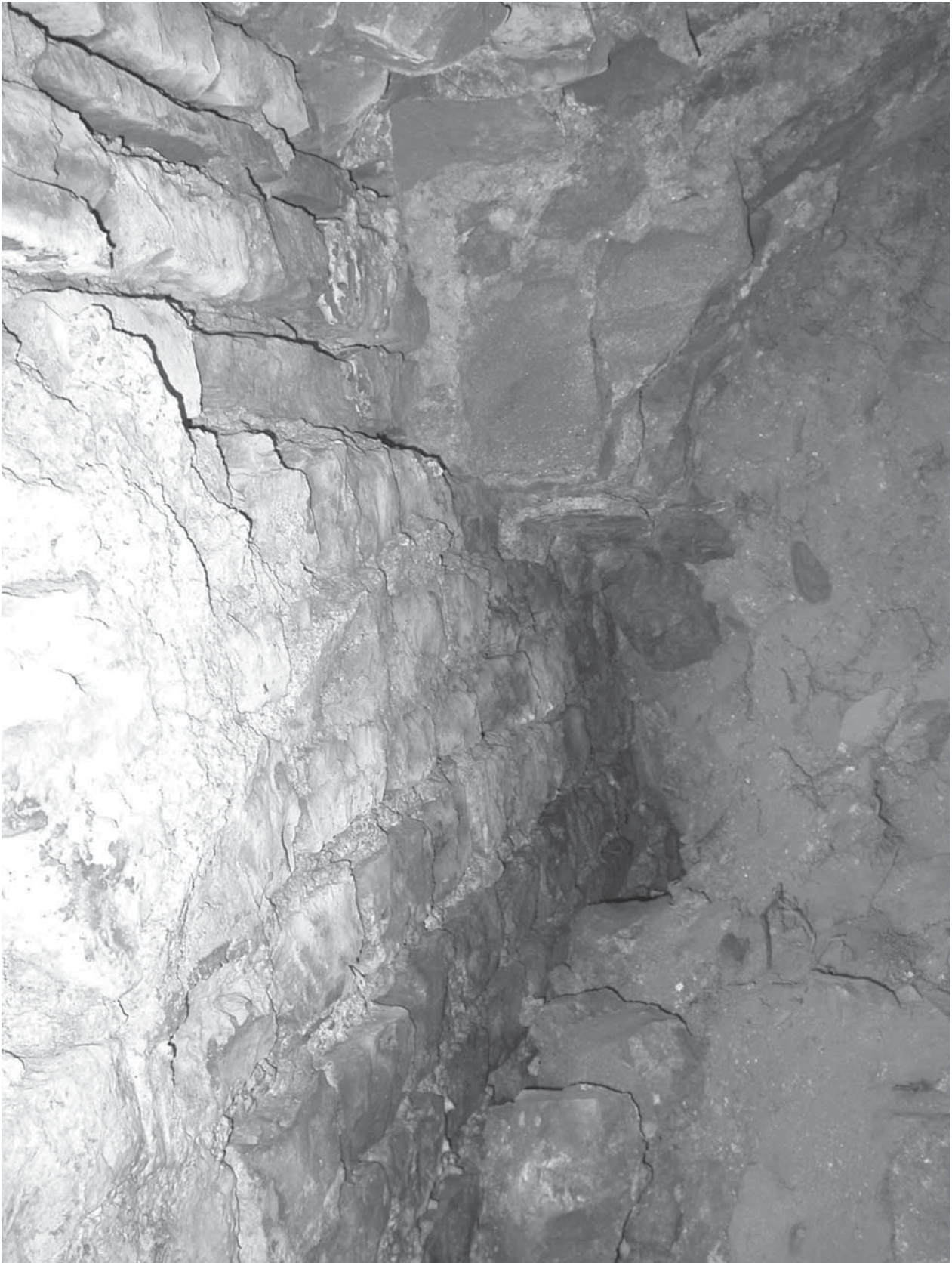
Abb. 7: Augst, Theatersanierung (Grabung 2002.55). Blendbogen der südlichen Eingangshalle. Die Abbildung gibt die Lage des Blendbogens in seinem ursprünglichen baulichen Zusammenhang wieder. Deutlich erkennbar ist die bogenförmig verlaufende Mörtelbraue am Übergang von der Nischenrückwand zur inneren Leibung des Buntsandsteinbogens. Im Zentrum der Verputzrest mit der aufgemalten Sandsteinquaderimitation (vgl. Abb. 8). Korrespondierend mit dem Scheitel der Innenleibung des Bogens ist ein 8–10 cm starker Rücksprung im opus vittatum-Mauerwerk der Nischenrückwand erkennbar. Die Quaderlagen über dem Rücksprung weisen eine geringere Stärke und einen deutlich höheren Anteil an Buntsandsteinquäderchen auf als die auf Sicht gemauerte, mit rot bemaltem Fugenstrich versehene Schale unterhalb des Rücksprungs.
