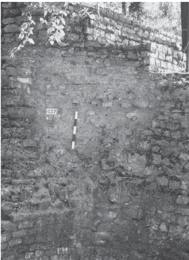
Abb. 36: Augst, Theatersanierung (Grabung 2002.55). Sanierungsarbeiten am Mittelvomitorium. Stark beschädigtes Kernmauerwerk der Entlastungsbögen; Zustand vor der Restaurierung.
