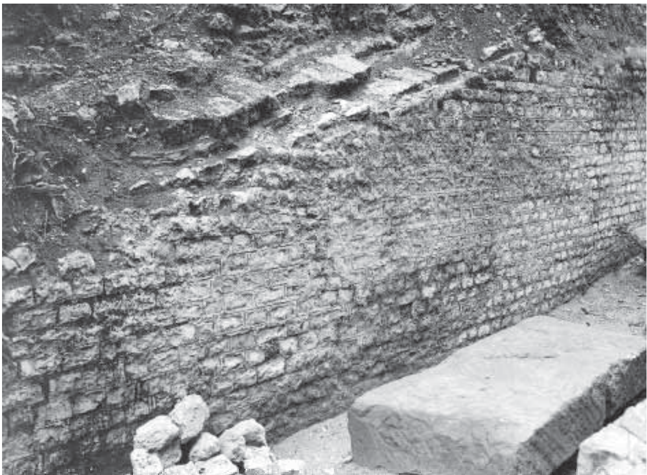
Abb. 8: Augst, Theater. Südost-Vomitorium, Nordwange mit fast vollständig erhaltenem Wanddekor (petra rasa-ähnliche Fugenbehandlung und rot bemalter Fugenstrich), Zustand nach der Freilegung 1939. Im oberen Bildteil die erhaltenen Überreste des schräg verlaufenden Tuffsteingewölbes. Erkennbar sind die geneigte Bettung mit den plattigen Kalksteinen des Kämpfers und den darüber liegenden Tuffkeilsteinen der Anfängerreihe. Bei den drei letzten Tuffkeilen links und den darunter erkennbaren Ziegelplatten handelt es sich um eine antike Reparatur.
