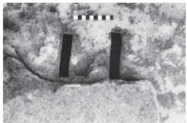
Abb. 7: Augst, Theatersanierung (Grabung 2001.55). Sitzstufenquader aus Buntsandstein des jüngeren szenischen Theaters. Ausschnitt der Oberfläche mit doppeltem Wolfsloch.
