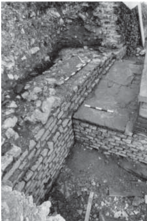
Abb. 29: Augst, Theatersanierung (Grabung 2001.55). Umfassung jüngeres szenisches Theater, Stützpfiler MR 194/Umfassung älteres szenisches Theater MR 59. Mauerbefund in den Feldern 170 und 172 von Nordosten. Gut erkennbar der gegen die Peripheriemauer des älteren szenischen Theaters gebaute, verbreiterte Fundamentbereich des Stützpfilers MR 194 mit Abdeckung aus Sandsteinplatten.
