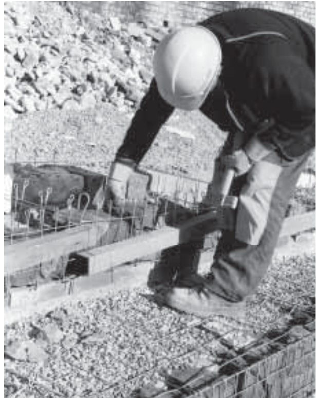
Abb. 21: Augst, Theatersanierung (Grabung 2001.55). Moderne Sitzstufenrekonstruktion. Aufschichten der Stirnfüllung aus roten Buntsandsteinschroppen. Um ein Ausbauchen der Gitterkörbe zu verhindern, wird während dieser Arbeitsphase die Stirnseite mit Holzbalken verstärkt.
