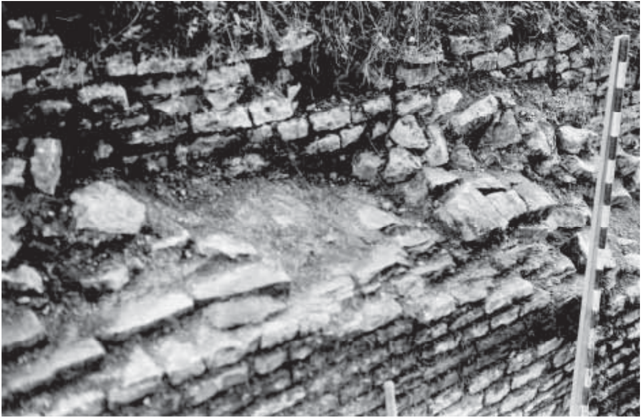
Abb. 9: Augst, Theater. Südost-Vomitorium, Südwanne mit ansteigendem Gewölbeauflager des Tuffsteingewölbes, Zustand nach der Freilegung 1939. Im oberen Bildteil ist deutlich die getrept ansteigende Widerlagermauer erkennbar. Davor, im Bereich der Mauerschale erodiert, der Bettungskeil für die Kämpferreihe. Links sind noch drei Tuffkeilsteine der Anfängerreihe zu erkennen (vgl. Abb. 10) sowie Reste der Kalksteinfüllung zur Verstärkung der Auflast über den Bogenschenkeln.
