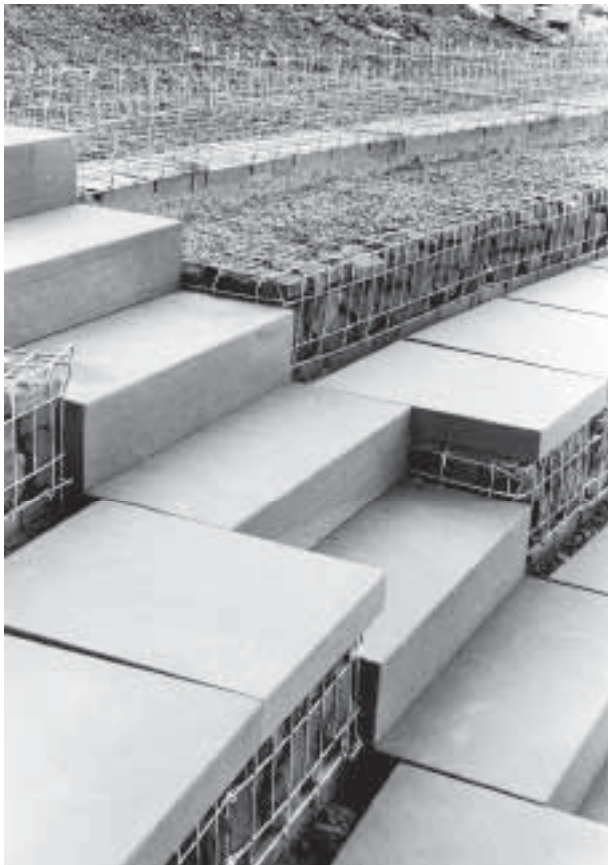
Abb. 16: Augst, Theatersanierung (Grabung 2001.55). Moderne Sitzstufenrekonstruktion. Konstruktion während des Aufbaus. Im Zentrum ein Treppenlauf aus Sandstein-Blocktritten, daran anschliessend Sitzstufen in unterschiedlichem Aufbauzustand.
