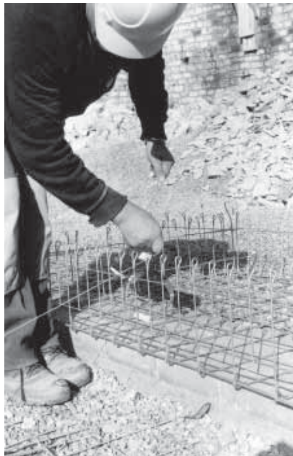
Abb. 18: Augst, Theatersanierung (Grabung 2001.55). Moderne Sitzstufenrekonstruktion. Einrichten und Kontrollieren der Gitterkörbe mit Hilfe eines gespannten Drahtseils. Gut erkennbar ist, wie die Körbe ca. 5 cm über das Ringfundament aus Zementsteinen und Beton vorkragen.
