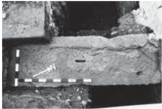
Abb. 7: Augst, Theater. Südost-Vomitorium, Mündungsbereich zur cavea. Grob behauene Unterlagsschwelle aus Buntsandstein des doppelten Schwellensystems. Der feiner behauene Randstreifen am oberen Ende dient zum Aufsetzen der oberen, auf Sicht gearbeiteten Schwelle. Der Quader in der linken oberen Ecke ist modern und wurde 1940/41 von Rudolf Laur-Belart versetzt.
