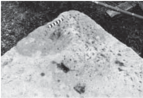
Abb. 5: Augst, Theatersanierung (Grabung 2001.55). Sitzstufenquader aus Buntsandstein des jüngeren szenischen Theaters. Oberfläche mit am hinteren Rand niveaugleicher, ca. 15 cm breiter geglätteter Zone zum Aufsetzen des nächsthöheren Quaders. Davor drei Stemmlöcher in unterschiedlichem Abstand.
