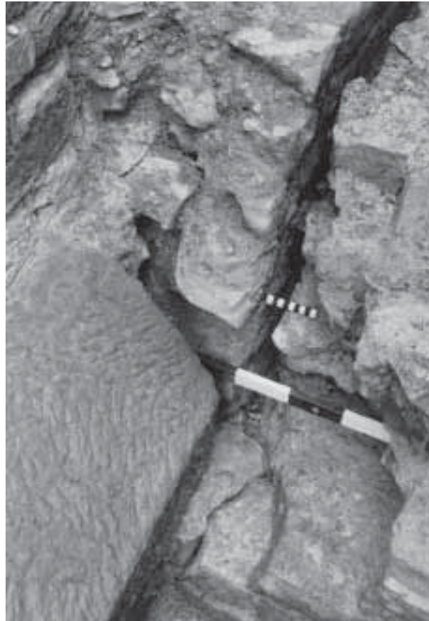
Abb. 33: Augst, Theatersanierung (Grabung 2001.55). Umfassung jüngeres szenisches Theater, Stützpfiler MR 195/Umfassung älteres szenisches Theater MR 59. Detail zu Abb. 31. Links Sandsteingurtquader des Stützpfilers MR 195 auf der Abbruchkante der Peripheriemauer des älteren szenischen Theaters MR 59 aufliegend. Rechts die gegen die äussere Mauerschale von MR 59 gebaute Hangstützmauer MR 337, die beim Versetzen des Gurtquaders ausgebrochen worden ist.
