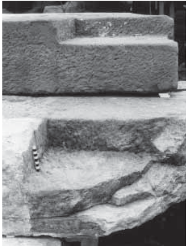
Abb. 10: Augst, Theatersanierung (Grabung 2001.55). Architekturprobe unter Verwendung von originalen Sitzstufenquadern des jüngeren szenischen Theaters (Ausschnitt aus Abb. 11). Detail eines Treppenlaufs. Beim oberen Quader ist die unregelmässige Tritthöhe deutlich erkennbar, die als Folge des erst nach dem Versetzen erfolgten Aushauens entstanden ist. Beim unteren Quader ist hinter dem Massstab die Eckzone nicht sauber ausgehauen, so dass sie am Rand leicht aufbördelt.
