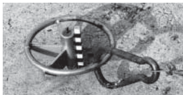
Abb. 19: Augst, Theatersanierung (Grabung 2001.55). Moderne Sitzstufenrekonstruktion. Einbetonierter Mittelpunkt mit Stahlring zum Einhängen des Drahtseils für die Kontrolle der Diagonalmasse.
