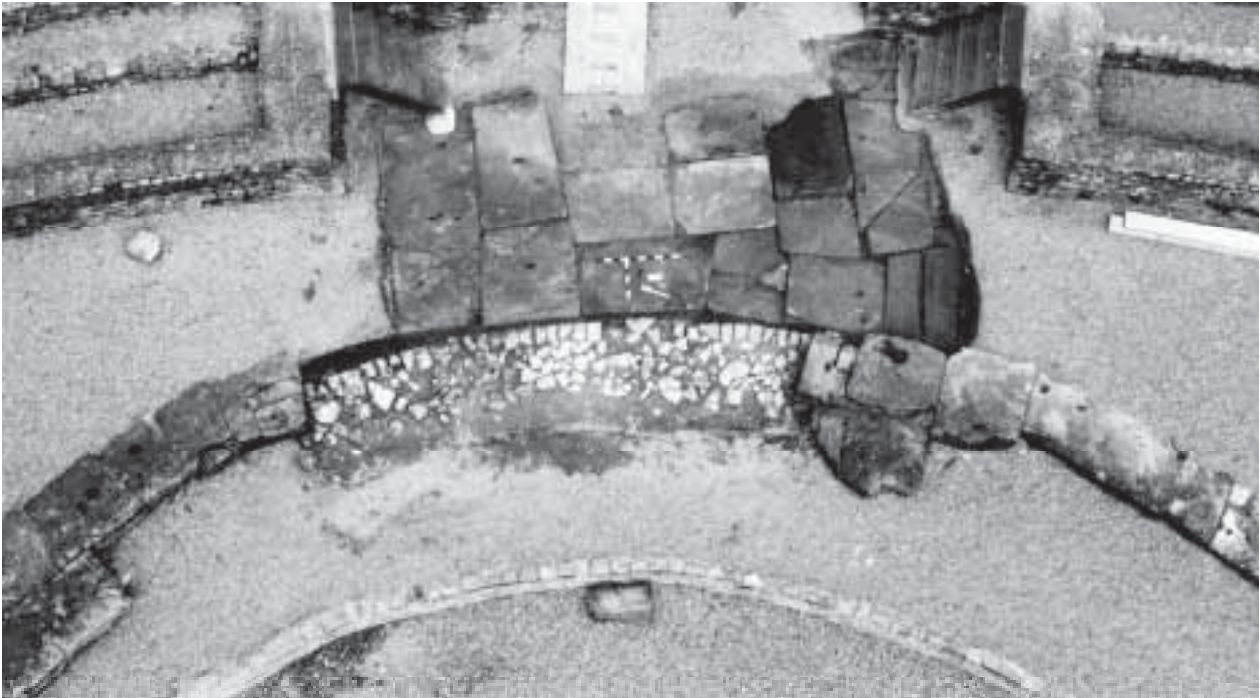
Abb. 13: Augst, Theatersanierung (Grabung 2001.55). Aufsicht auf die erhaltenen Überreste des Orchestraumgangs mit der darunter liegenden Widerlagermauer. Am hinteren Rand der Mauer sind noch die Bodenquader des Umgangs erkennbar. Im Zentrum das Fundament resp. der Bodenbelag der an den Orchestraumgang anschliessenden Nische.
