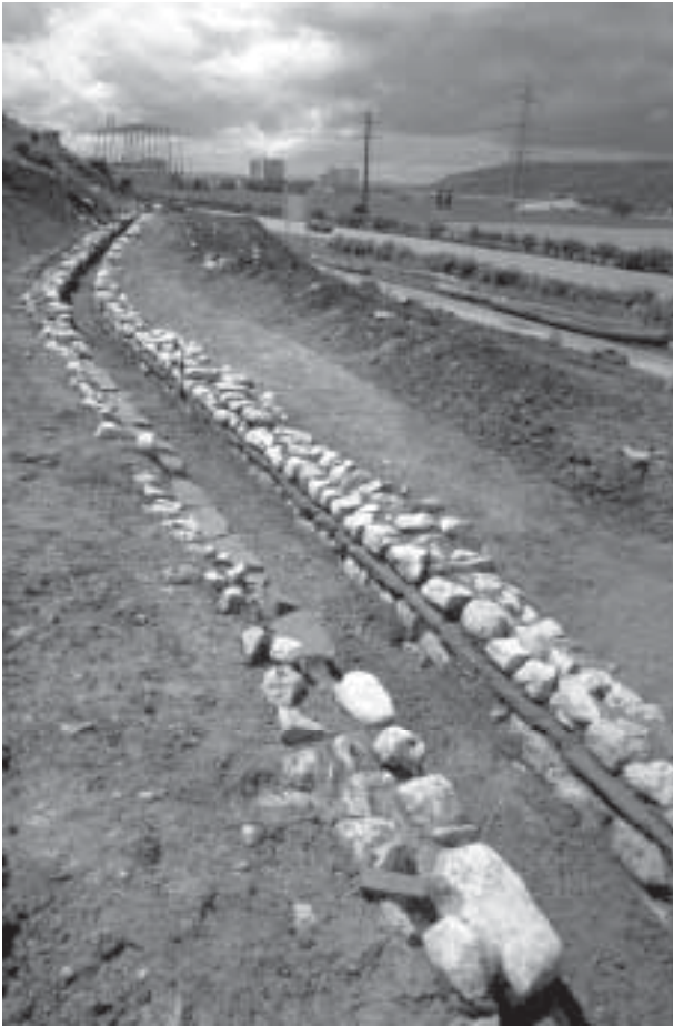
Abb. 5: Kaiseraugst-Hardhof AG. Aufsicht: der obere Kanal.
