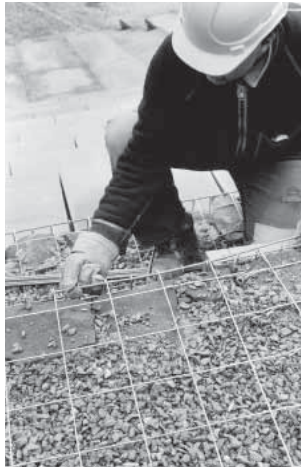
Abb. 24: Augst, Theatersanierung (Grabung 2001.55). Moderne Sitzstufenrekonstruktion. Einsetzen und Verschliessen des Deckels und Auffüllen des Korbs mit Granitschotter und -splitt.
