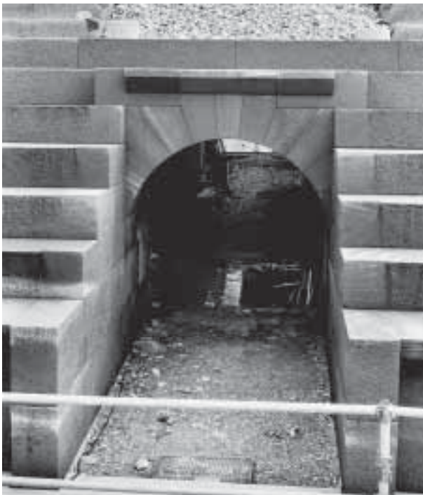
Abb. 5: Augst, Theater. Südost-Vomitorium, Mündungsbereich zur cavea. Im Jahr 2000 nach den neuesten Forschungsergebnissen errichtete Rekonstruktion des Werksteinbogens als Ersatz des schadhaften, 1940/41 durch Rudolf Laur-Belart rekonstruierten Bogens (ausgeführt von Steinmetz Gregor Bucher, unter Anleitung von Bildhauermeister Markus Horisberger).
