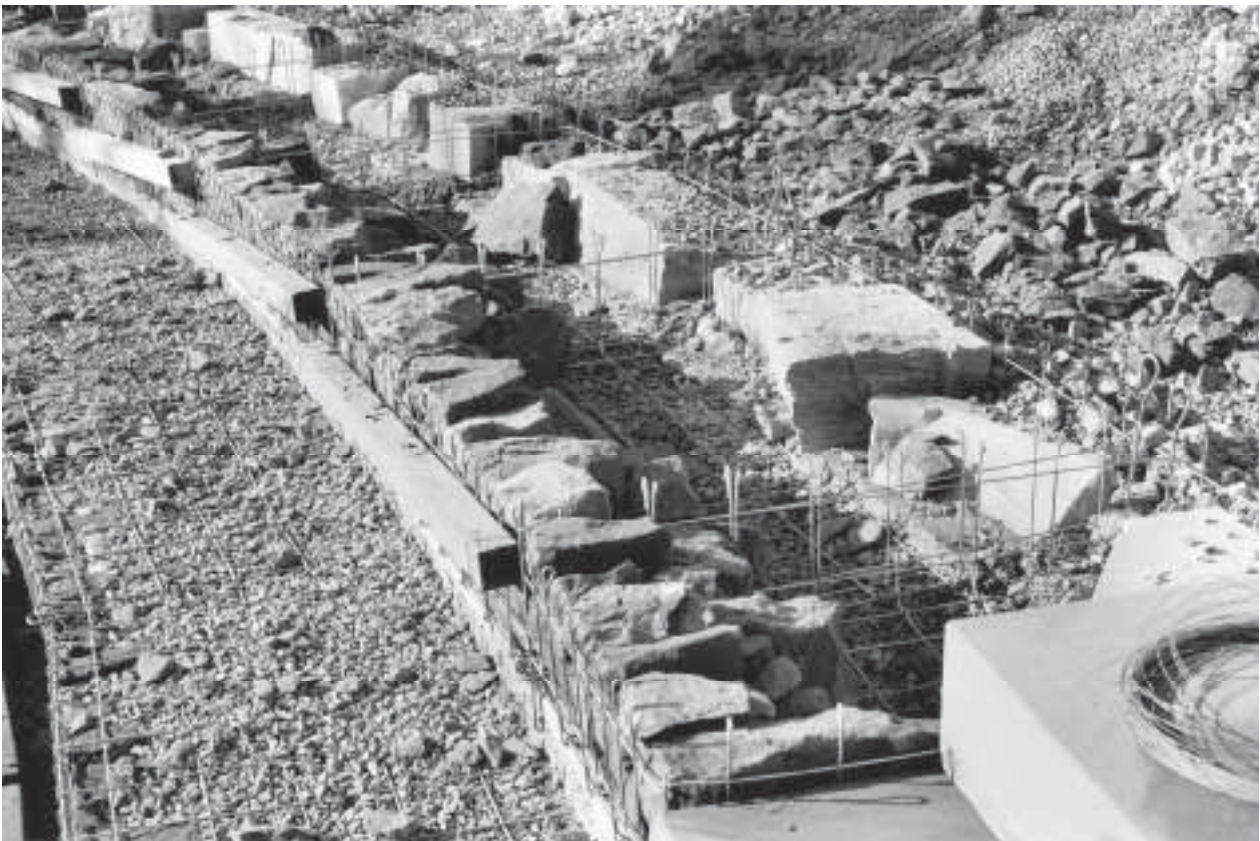
Abb. 22: Augst, Theatersanierung (Grabung 2001.55). Moderne Sitzstufenrekonstruktion. Fertig geschichtete Sandsteinfüllungen an den Stirnseiten der Körbe. Die festgebundenen Holzbalken verhindern ein Ausbauchen der Gitterkörbe während den Füllarbeiten.
