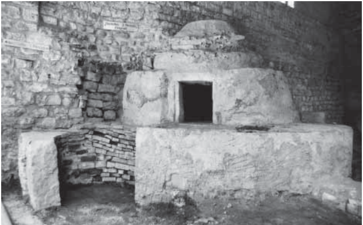
Abb. 34: Augst, Gebäude zwischen der Insula 9 und dem Theater. Konservierung des Backofens in der «Taberne» (2001.907). Der ursprünglich vorzüglich erhaltene, im Laufe der letzten Jahre jedoch zerfallende Backofen mit der links angebauten Herdstelle hatte unter Austrocknung von oben, Bodenfeuchte von unten sowie wegen vieler Wespenester (Abb. 36) stark gelitten und musste dringend saniert werden.
