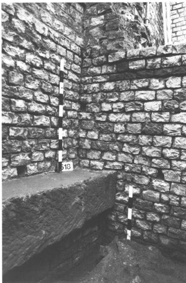
Abb. 14: Augst, Theatersanierung (Grabung 2000.55). Umfassung im Bereich des Stützpfilers MR 194. Blick von Osten. Rechts die Umfassungsmauer MR 58, links der später angebaute Stützpfiler MR 194. In der Mauer- schale von MR 58 ist die beim Anbau des Stützpfilers entstandene Fuge erkennbar (vgl. Abb. 13).
