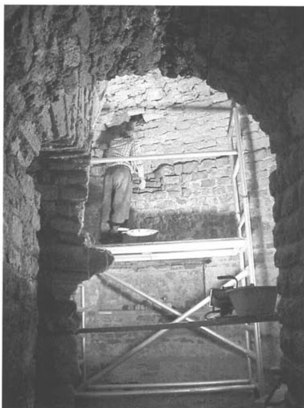
Abb. 44: Augst, Violenried, ehemaliges E. Frey-Areal (Grabung 2000.60, Konservierung 2000.925). Konservierungsarbeiten im unterirdischen Brunnenhaus: Am intakt erhaltenen Tuffsteingewölbe werden – aus Sicherheitsgründen – lediglich die Fugen mit Kalkmörtel neu ausgestrichen.
