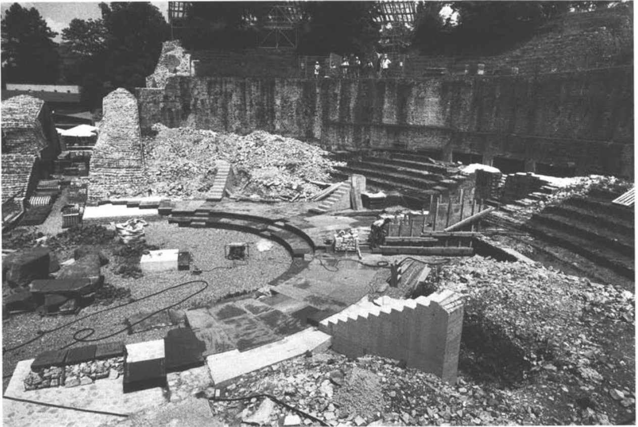
Abb. 28: Augst, Theatersanierung (Grabung 2000.55). Rekonstruktion der Sitzstufen im 1. Rang des Theaters (Abb. 1,B). Aufnahme im Frühsommer 2000, während dem Betonieren der Treppenfundamente.
