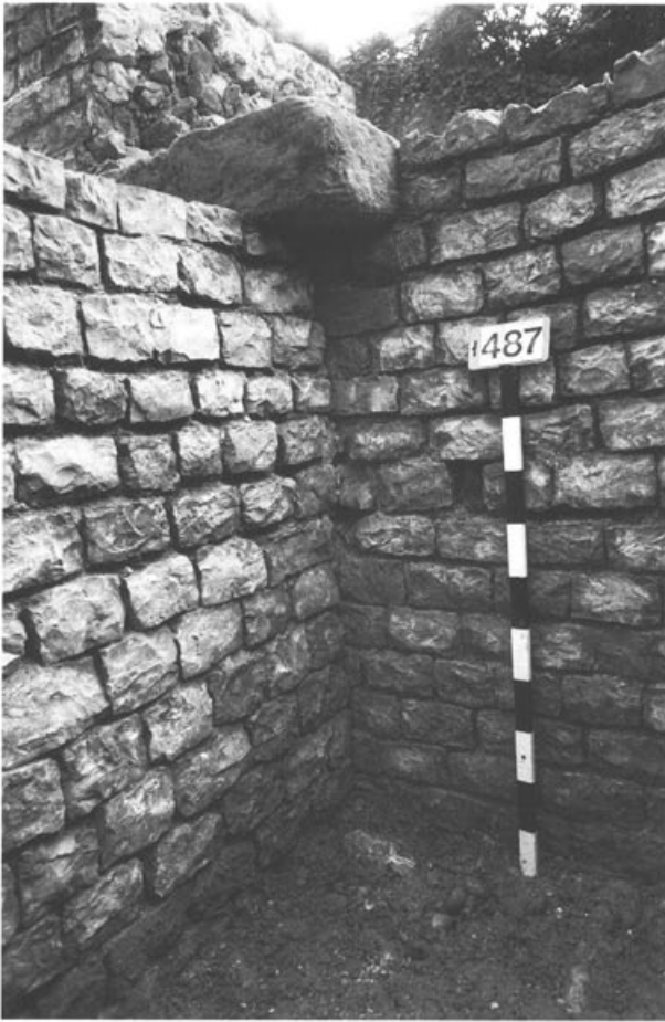
Abb. 12: Augst, Theatersanierung (Grabung 2000.55). Eingangsbereich des Südost-Vomitoriums, Feld 163 (vgl. Abb. 11). Blick von Westen. Rechts die Umfassungsmauer MR 58, links die stumpf anstossende Quermauer MR 331. Im Mauerwinkel unter dem Sandsteinquader in MR 58 ist der Ansatz der Reparatur MR 336 erkennbar.
