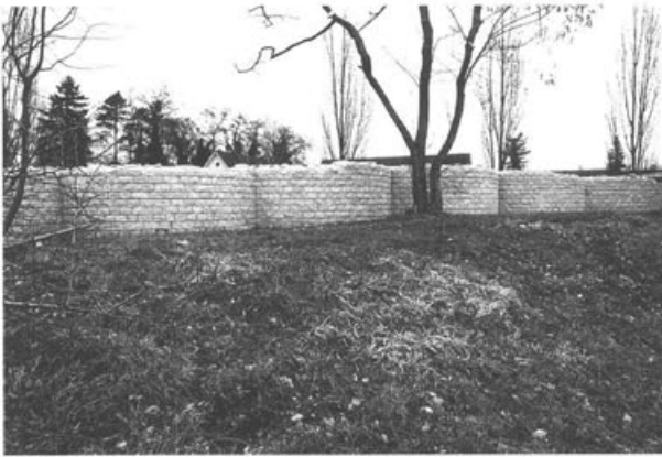
Abb. 10: Augst, Theatersanierung (Grabung 2000.55). Keil 1, dritter Rang. Aufmauerung der Entlastungsbögen MR 114–MR 120 als durchgehende Brüstung.
