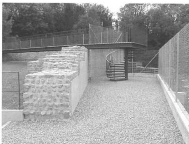
Abb. 39: Augst, Violentried, ehemaliges E. Frey-Areal (Grabung 2000.60, Konservierung 2000.925). Teilrekonstruktion der nördlichen Hangstützmauer mit Wendeltreppe. Der Zaun rechts steht auf einer neuen hohen Betonstützmauer, die das Gelände bis zur Sohle der ehemaligen Kastelen-Kiesgrube (rechts und hinten) abfängt.
