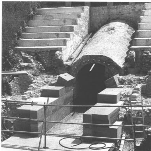
Abb. 23: Augst, Theatersanierung (Grabung 2000.55). Rekonstruktion des Werksteinbogens am Mündungsbereich des Südost-Vomitoriums. Aufnahme nach dem Versetzen der Wandblöcke und der beiden ersten Bogensteine.
