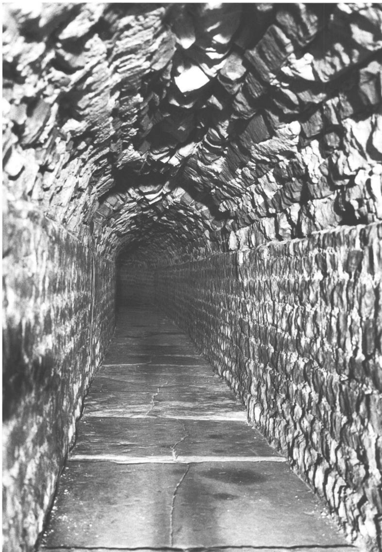
Abb. 2: Augst, Theatersanierung (Grabung 2000.55). Nordabschnitt des Abwasserkanals. Blick von Süden mit älterem Gewölbeabschnitt aus plattigen Buntsandsteinen. Boden aus grossen Buntsandsteinblöcken.
