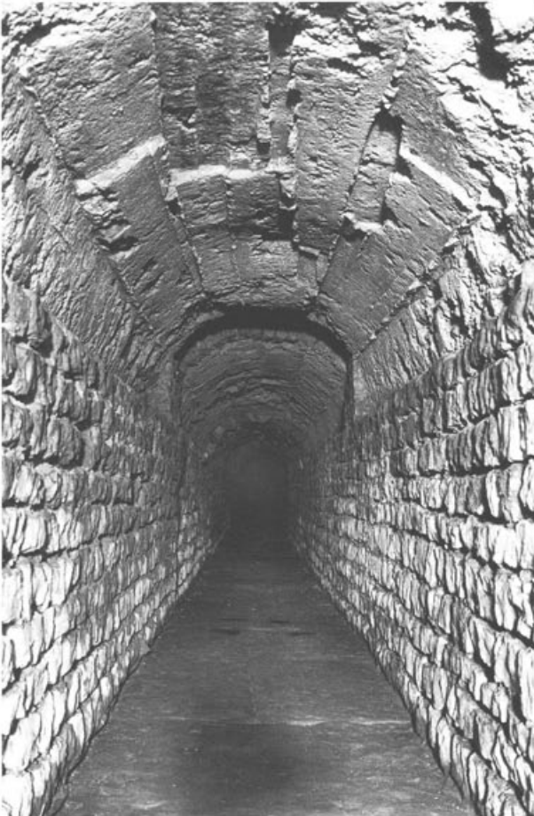
◀ Abb. 4: Augst, Theatersanierung (Grabung 2000.55). Nordabschnitt des Abwasserkanals. Blick von Süden in den jüngeren Gewölbeabschnitt mit deutlich erkennbaren Negativabdrücken der Schalungsbretter. Im Zentrum ist ein zweiter, zur jüngeren Phase gehörender Einstiegschacht zu erkennen. Boden aus grossen Buntsandsteinblöcken.
