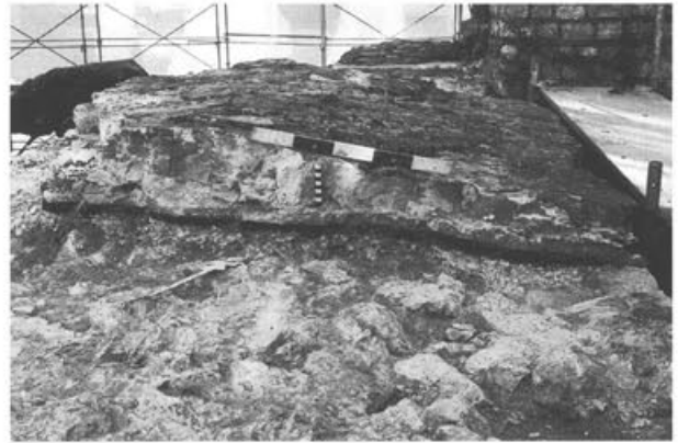
Abb. 39: Augst, Theatersanierung (Grabung 1998.55). Südaditus. Abbau der schadhaften modernen Übermauerung von 1936 auf der inneren Bühnenmauer 43. Die in der Bildmitte quer verlaufende, schwarze Linie ist eine 1936 angebrachte, jetzt unwirksam gewordene Isolationsschicht aus Asphalt gegen Regenwasser.
