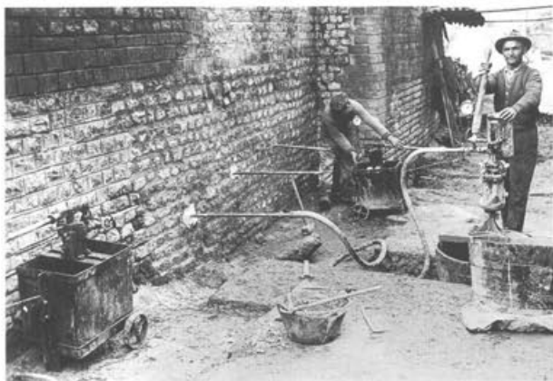
Abb. 30: Augst, Theatersanierung (Grabung 1936.59). Südaditus, Injektionsarbeiten von 1936. Mit einer handbetriebenen Pumpe wird versucht, Zementleim in die Hohlräume des Mauerwerks zu pressen.
