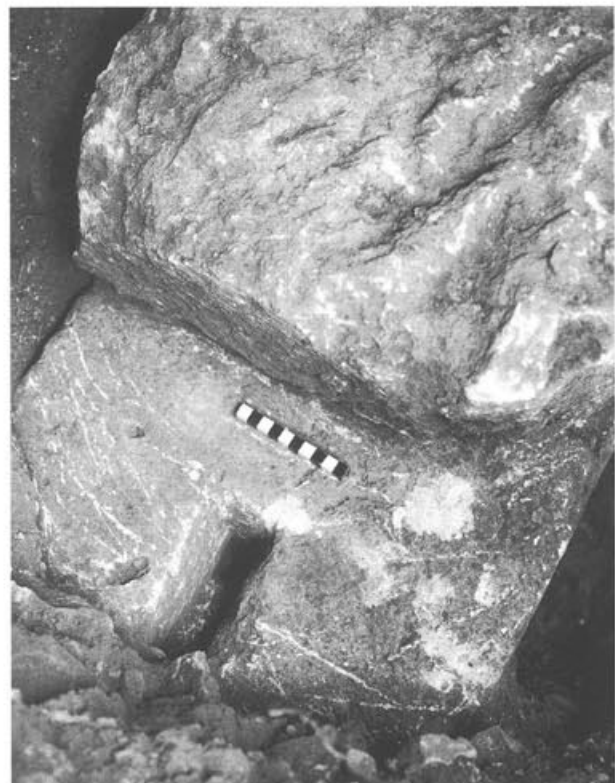
Abb. 23: Augst BL, Amphitheater Westseite, Region 3,A (Grabung 1998.64). Stein Nummer 8 (vgl. Abb. 18) mit einem sehr schön gearbeiteten Wolfsloch. Von oben.
