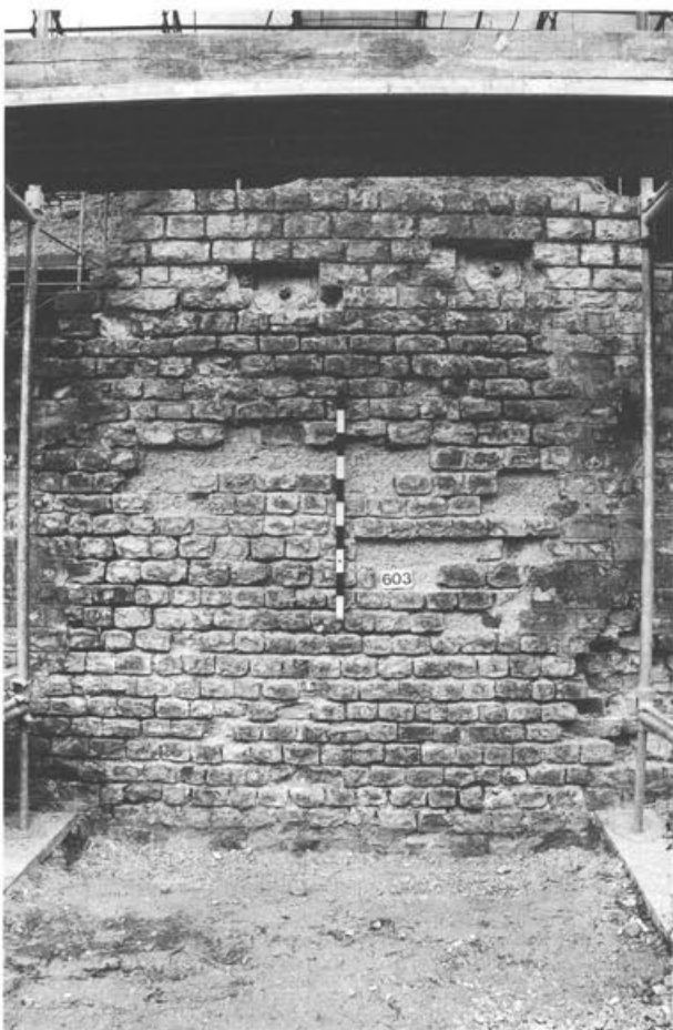
Abb. 42: Augst, Theatersanierung (Grabung 1998.55). Südaditus. Ausschnitt aus der Westseite der äusseren Bühnenmauer 44 während den Restaurierungsarbeiten. Gut sichtbar sind die vom Zementmörtel befreiten, offenen Fugen und zwei noch unvermauerte Nischen mit den Ankerköpfen im oberen Bereich der Mauer.
