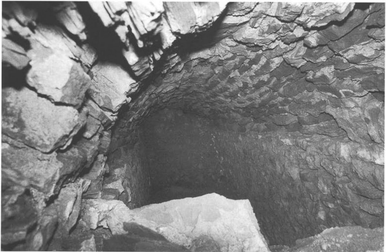
Abb. 5: Augst BL, E. Frey AG (Grabung 1998.60). Blick in den teilweise verschütteten Zugangstunnel (Abb. 2,3) zum unterirdischen Gewölbe. Im Gegensatz zu den Wänden aus Kalksteinmauerwerk besteht das Gewölbe aus Buntsandsteinen. Breite des Tunnels rund 1,2 m.
