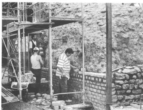
Abb. 45: Augst, Theatersanierung (Grabung 1998.55). Südaditus. Aufmauerung der östlichen Schale von Mauer 44.
