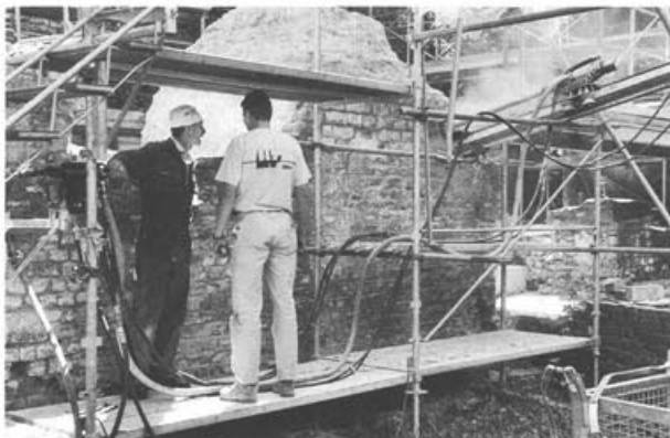
Abb. 41: Augst, Theatersanierung (Grabung 1998.55). Südaditus. Spezialisten der Firma Hoch & Tiefbau AG aus Sursee beim Einbau der Anker in die äussere Bühnenmauer 44.
