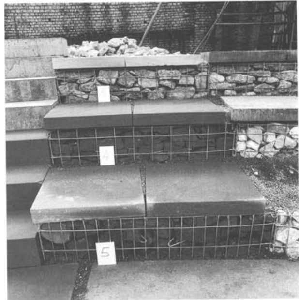
Abb. 53: Augst, Theatersanierung (Grabung 1998.55). Das definitiv ausgewählte System mit Abdeckplatten aus rotem Sandstein (Muster Nr. 5).
