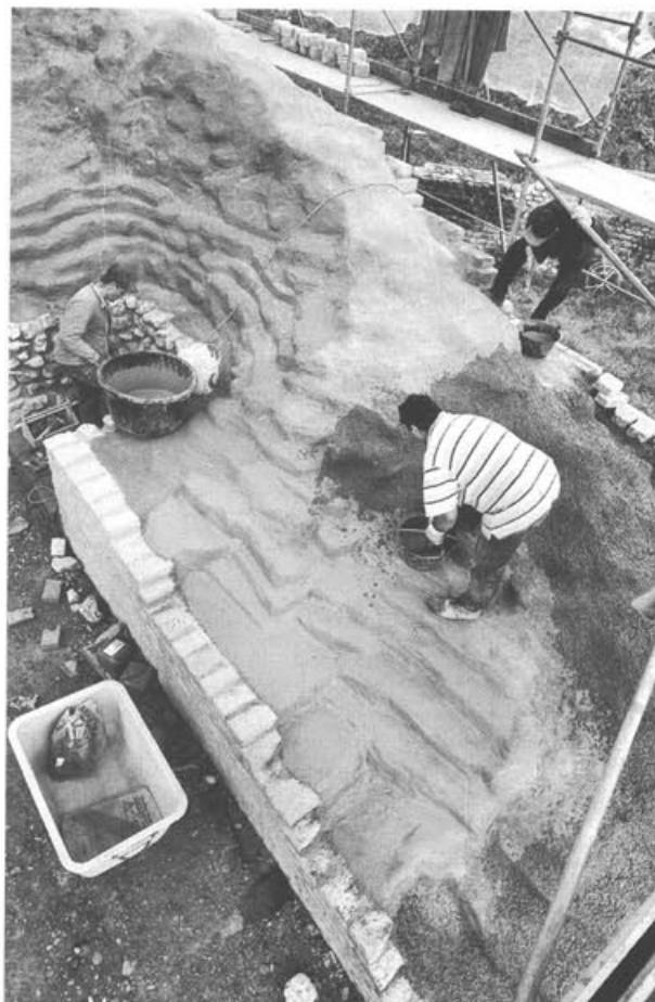
Abb. 47: Augst, Theatersanierung (Grabung 1998.55). Südaditus. Die neue Isolationsschicht gegen Meteorwasser wird auf der Mauerkrone appliziert.
