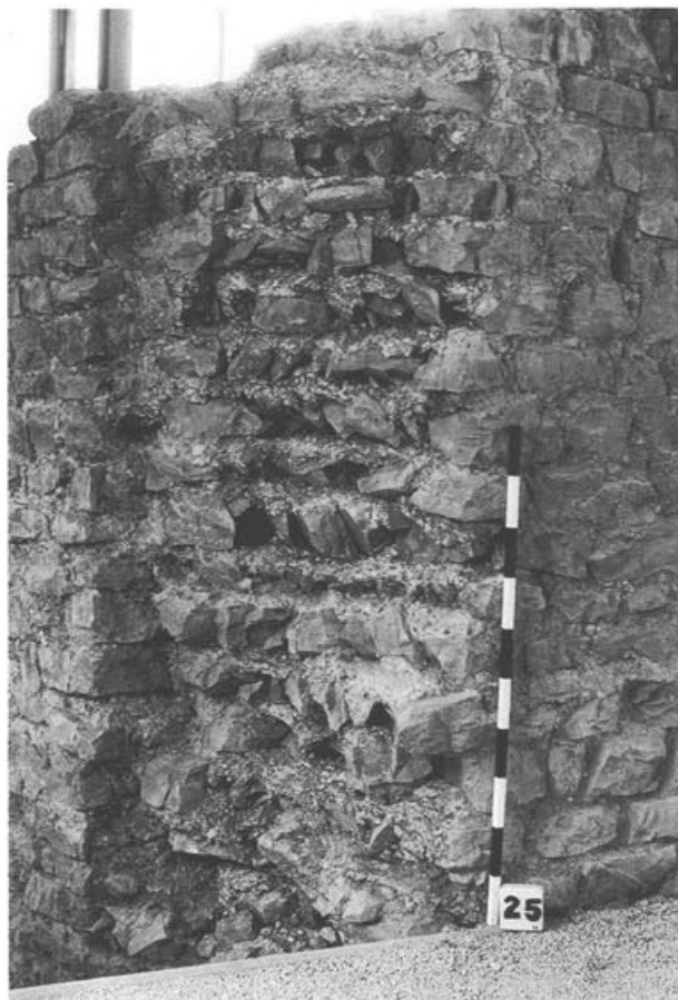
Abb. 31: Kaiseraugst, Gewerbehaus Schmidmatt, Mauerrest MR7. Hier ist sehr gut der Aufbau im Kern einer römischen Mauer zu erkennen. Restaurierung/Konservierung: Hanspeter Witschi. Festigung der vorhandenen absandenden Mörtelreste und rissgeschädigten Kalksteine mit Acryldispersion Lascaux D498M. Die statische Sicherung des Mauerrestes erfolgte punktuell mit Ledan LD1.
