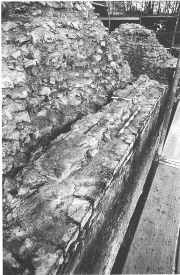
Abb. 3: Augst, Theatersanierung (Grabung 1998.55). Südaditus, westliche Bühnenmauer (MR 44). Antik reparierte Vormauerung mit Ziegelschrotnörtel als Bindemittel und eingesetztem, zweilagigem Ziegelband. Im Zentrum der breite Spalt mit dem dahinterliegenden älteren Kernmauerwerk.
