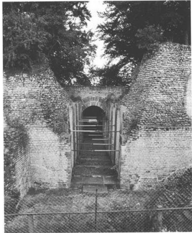
Abb. 24: Augst, Theatersanierung (Grabung 1996.55). Blick von Osten in das Südostvomitorium. Im Vordergrund die um 1939/40 ergänzten, 1992 aus Sicherheitsgründen abgespriessten Wangenmauern. Im Hintergrund die ebenfalls um 1939/40 rekonstruierte Überwölbung aus Stahlbeton und Sandsteinquadern.
