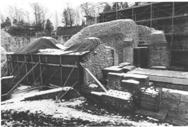
Abb. 49: Augst, Theatersanierung (Grabung 1998.55). Südaditus. Zustand nach Beendigung der Restaurierungsarbeiten von 1998. Die Westseite der äusseren Bühnenmauer 44 wurde über den Winter verpackt, um Frostschäden am neuen, noch nicht ganz ausgehärteten Fugenmörtel aus Luftkalk zu vermeiden.
