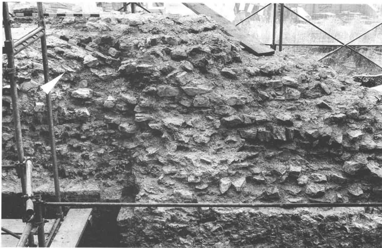
Abb. 5: Augst, Theatersanierung (Grabung 1998.55). Südaditus, westliche Bühnenmauer (MR 44). Ostseite von Mauer 44 mit der abgestuft verlaufenden Abmauerung für das Widerlager der Aditusüberwölbung. Der Pfeil markiert den Ausschnitt von Abbildung 6.
