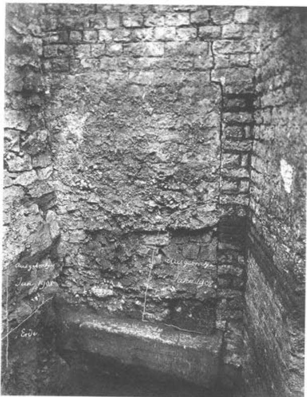
Abb. 19: Augst BL, Curia (Grabung 1907/1908,60). Ansicht der ursprünglich in das Untergeschoss der Curia führenden und später zugemauerten Türe. Von links stösst Mauer U direkt an die zugemauerte Türöffnung; rechts befindet sich der Stützpfiler Nr. 2 (vgl. Abb. 16). Am unteren Bildrand ist die Schwelle aus Kalkstein zu erkennen.
