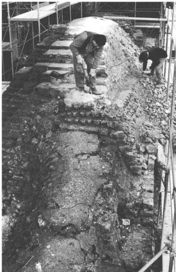
Abb. 38: Augst, Theatersanierung (Grabung 1998.55). Südaditus. Abbau der stark beschädigten modernen Übermauerungen von 1907 und 1936 auf der äusseren Bühnenmauer (MR 44).
