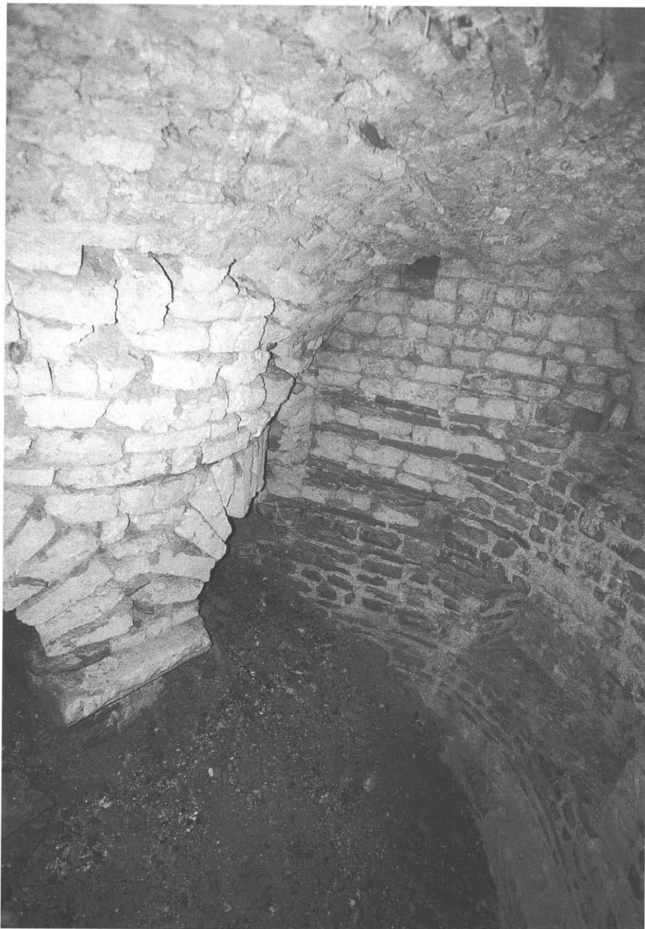
Abb. 8: Augst BL, E. Frey AG (Grabung 1998.60). Blick nach Südwesten in das Gewölbeinnere. Rechts am Bildrand, im unteren Bereich der Mauer, befindet sich eine der rechteckigen Nischen. Beim oberen Teil der westlichen Abschlussmauer könnte es sich um einen Einbau im Zuge der Errichtung des Tonnengewölbes handeln. Die in der Mauer erkennbare, nahezu im Scheitelpunkt des Tonnengewölbes liegende Öffnung wurde 1998 nicht freigelegt. Links ist der zum grössten Teil durch das eingedrungene Erdmaterial verschüttete Pfeiler zu erkennen.
