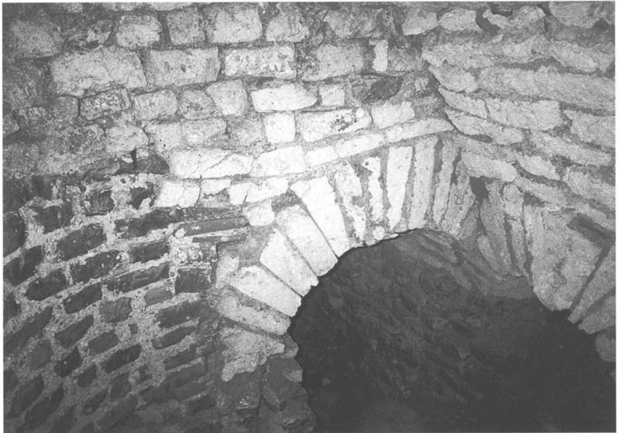
Abb. 9: Blick mit ferngesteuerter Kamera durch einen der Lüftungsschlitze (Abb. 22, unten) in die sensationell gut erhaltene Gewölbezisterne. Erkennbar sind (von links nach rechts) eine anscheinend ältere Mauerpartie aus dunklen Steinen, ein einmündender Zugangstunnel und ein – vermutlich später eingebauter – Stützbogen (rechts aussen angeschnitten).
