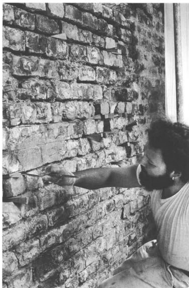
Abb. 43: Augst, Theatersanierung (Grabung 1998.55). Südaditus. Sanierung der Westseite von Mauer 44. In mühevoller Kleinarbeit werden gebrochene, originale Mauerquader verklebt oder ersetzt.
