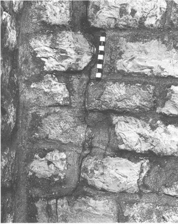
Abb. 39: Augst, Theatersanierung (Grabung 1997.55). Nördliche Cavea-Abschlussmauer (MR 60). Detail mit vertikal durch mehrere Steinschichten verlaufendem Riss in einem Entlastungsbogen. M. 1 : 5.
