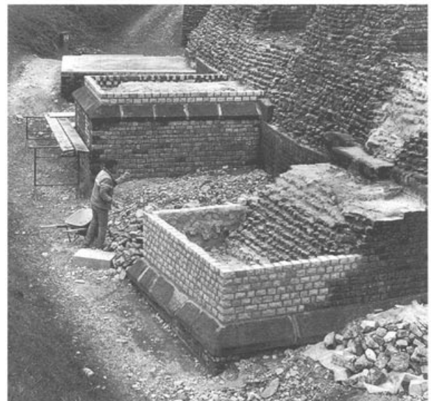
Abb. 31: Augst, Theatersanierung (Grabung 1997.55). Aufmauern der Stützpfeiler nördlich der Umfassungsmauer (MR 57) in antiker Mauertechnik, also mit äusserer Schale und Kernmauerwerk aus Stampfmörtel und Bruchsteinen.
