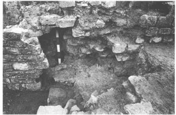
Abb. 15: Augst, Theatersanierung (Grabung 1997.55). Umfassung von Keil 1 mit Stützpfйлern MR 189–193. Detail des nachträglich an die Umfassungsmauer angefügten Stützpfйлers 193. Am rechten Bildrand die originale Mauerschale der Umfassungsmauer, die hinter dem Pfeilerkörper durchzieht; im Zentrum der in Zusammenhang mit den Bauabklärungen entstandene Ausbruch in der Umfassungsmauer, der zum Einbinden des Schalenmauerwerks von Stützpfйler 193 diente. Der rötliche Mörtel des Stützpfйлers enthielt Ziegelschrot, während die Umfassungsmauer aus «normalem» beigem Kalkmörtel bestand.
