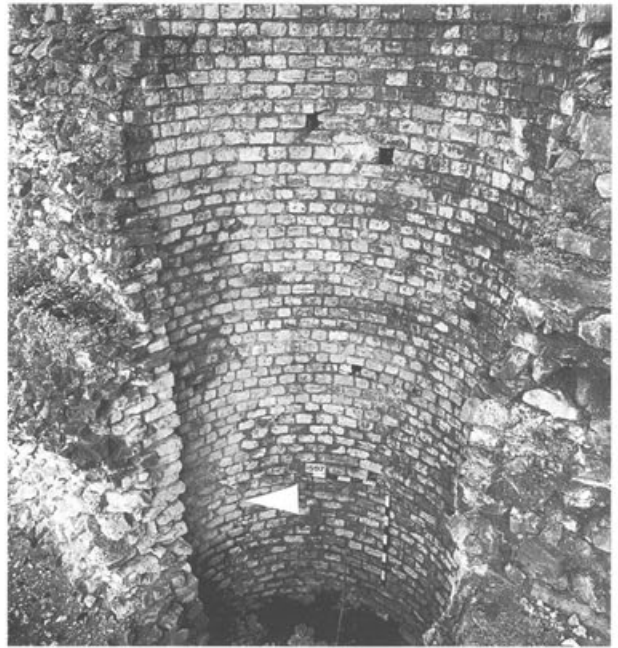
Abb. 38: Augst, Theatersanierung (Grabung 1997.55) Nördliche Cavea-Abschlussmauer (MR 60). Blick in einen der 1938 stark ergänzten Entlastungsbogen. Der Pfeil zeigt die Lage eines alarmierenden Risses zwischen moderner Ergänzung und originalem Mauerwerk an.
