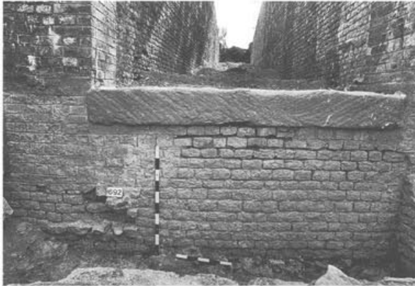
Abb. 20: Augst, Theatersanierung (Grabung 1997.55). Eingangsbereich des Nordost-Vomitoriums. Ansicht an die erhaltene Schwelle des Nordost-Vomitoriums und die innere Umfassungsmauer (MR 55). Links vom Massstab sind die Spuren einer Reparatur an der Mauerschale zu erkennen; die vorstehenden und ausgebrochenen Steine unter der Fotonummer sind Reste einer abgebrochenen Quermauer (gleich derjenigen am rechten Bildrand), die ausgebrochene Hälfte der Verzahnung wurde nachträglich repariert. Die Zone über der Fotonummer ist eine zu Beginn des 20. Jahrhunderts erneuerte Mauerschale.
