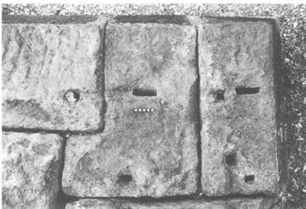
Abb. 18: Augst, Theatersanierung (Grabung 1997.55). Umfassung von Keil 1 mit Stützpfeilern MR 189–193. Ausschnitt des Sandsteingurts von Abbildung 17. Deutlich erkennbar sind die Verzahnung der Quader und die Spuren der Eisenverklammerung. Im Zentrum ein Wolfsloch, das nach dem Versetzen als doppeltes Klammerloch weiterverwendet wurde. Im Klammerloch links in situ erhaltene Reste der originalen Verbleiung. Einteilung des Massstabs: 1 cm.
