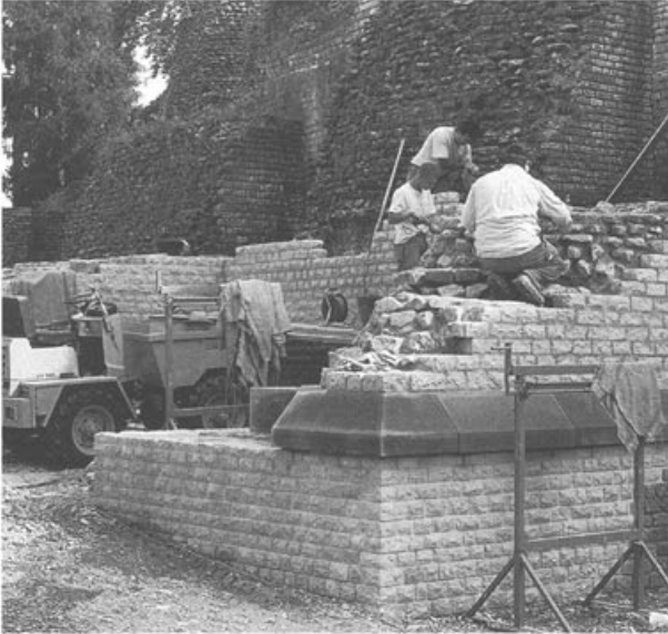
Abb. 32: Augst, Theatersanierung (Grabung 1997.55). Aufmauern der Stützpfeiler nördlich der Umfassungsmauer (MR 57). Vermauern der Deckschicht aus Bruchsteinen.
