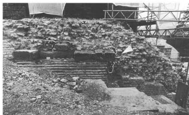
Abb. 13: Augst, Theatersanierung (Grabung 1997.55). Umfassung von Keil 1 mit Stützpfйлern MR 189–193. Ansicht an die Umfassung und die Überreste des westlichsten Stützpfйлers von Keil 1 (MR 189). Die weisse Linie markiert die Grenze zwischen dem älteren, beigen Kalkmörtel (oberhalb und rechts der Linie) und dem jüngeren, bräunlichroten Mörtel mit Ziegelschrotzuschlag (unterhalb und links der Linie). Die Mörtelgrenze deutet auf einen massiven Umbau am Stützpfйler hin. Der Pfeil markiert den Ausschnitt von Abbildung 14.
