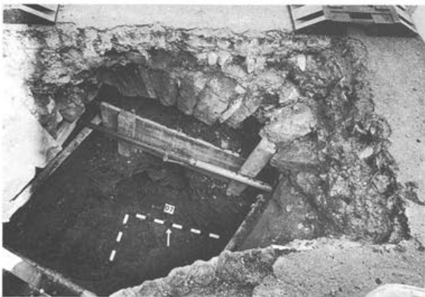
Abb. 8: Augst BL, Region 10,B (Grabung 1997.54). Blick an das bei Bauarbeiten durchschlagene, aus Sandsteinquadern gefügte Gewölbe des spätmittelalterlichen Mühlekanals. Der freigelegte Abschnitt wurde offenbar noch lange als Leitungstunnel benutzt und erst in jüngerer Zeit aus Sicherheitsgründen verfüllt.
