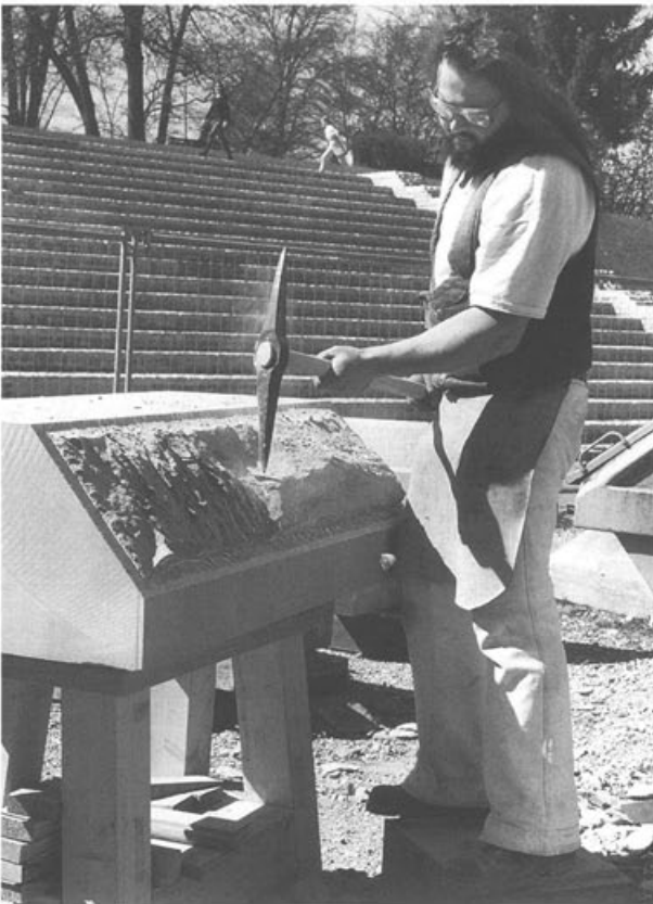
Abb. 33: Augst, Theatersanierung (Grabung 1997.55). Aufmauern der Stützpfeiler nördlich der Umfassungsmauer (MR 57). Steinmetz Gregor Bucher an der Arbeit. Zurichten der Gurtstücke aus Sandstein mit dem Zweispitz, einem schon in der Antike bekannten Werkzeug.
