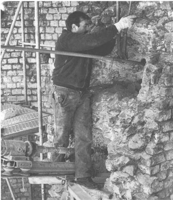
Abb. 41: Augst, Theatersanierung (Grabung 1997.55). Nördliche Cavea-Abschlussmauer (MR 60). Einfädeln eines der 7–9 m langen Erdanker in ein Bohrloch. Anschließend wird das Bohrloch durch eine Öffnung im Zentrum der Ankerstange mit einer speziellen Zementmischung unter Druck verpresst.
