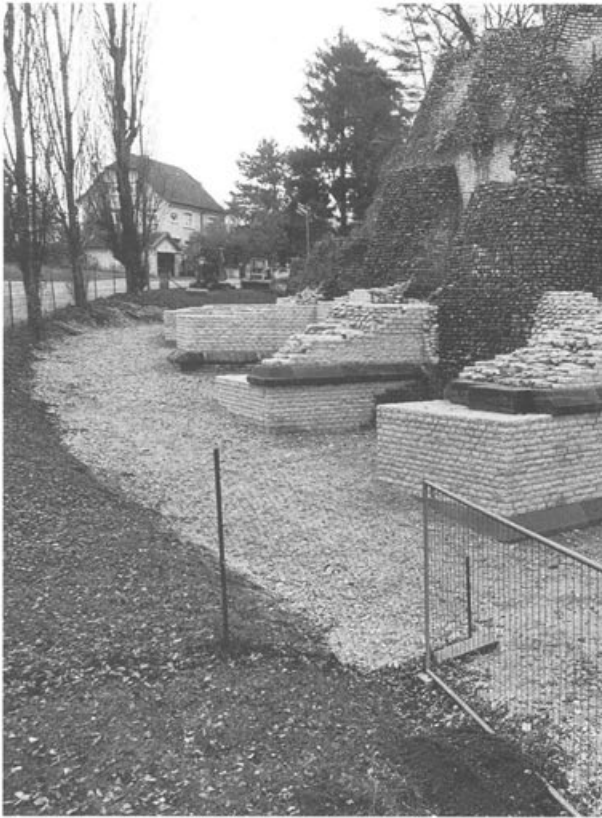
Abb. 36: Augst, Theatersanierung (Grabung 1997.55) Die Stützpfeiler nördlich der Umfassungsmauer (MR 57) nach Beendigung der Arbeiten. Das Gehniveau liegt jetzt ca. 1,50 m höher. Die stark bröckeligen, zum Teil noch originalen Partien am Fuss der Umfassungsmauer sind jetzt dauerhaft geschützt.
