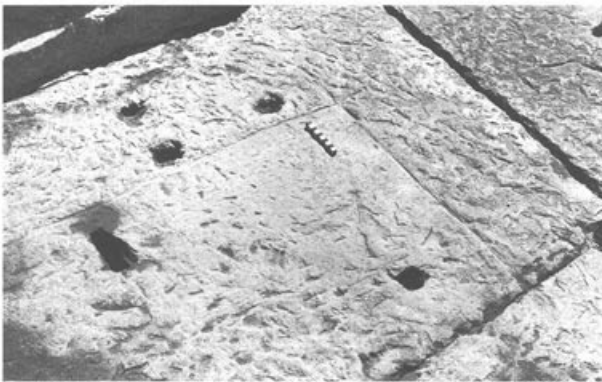
Abb. 30: Augst, Theatersanierung (Grabung 1997.55). Südaditus und südliche Eingangshalle. Sandsteinfundament mit den Baurisslinien eines Gurtpfeilers. Rechts das Wolfsloch zum Versetzen des Quaders, links ein Dübelloch; im Hintergrund drei Stemmlöcher.
