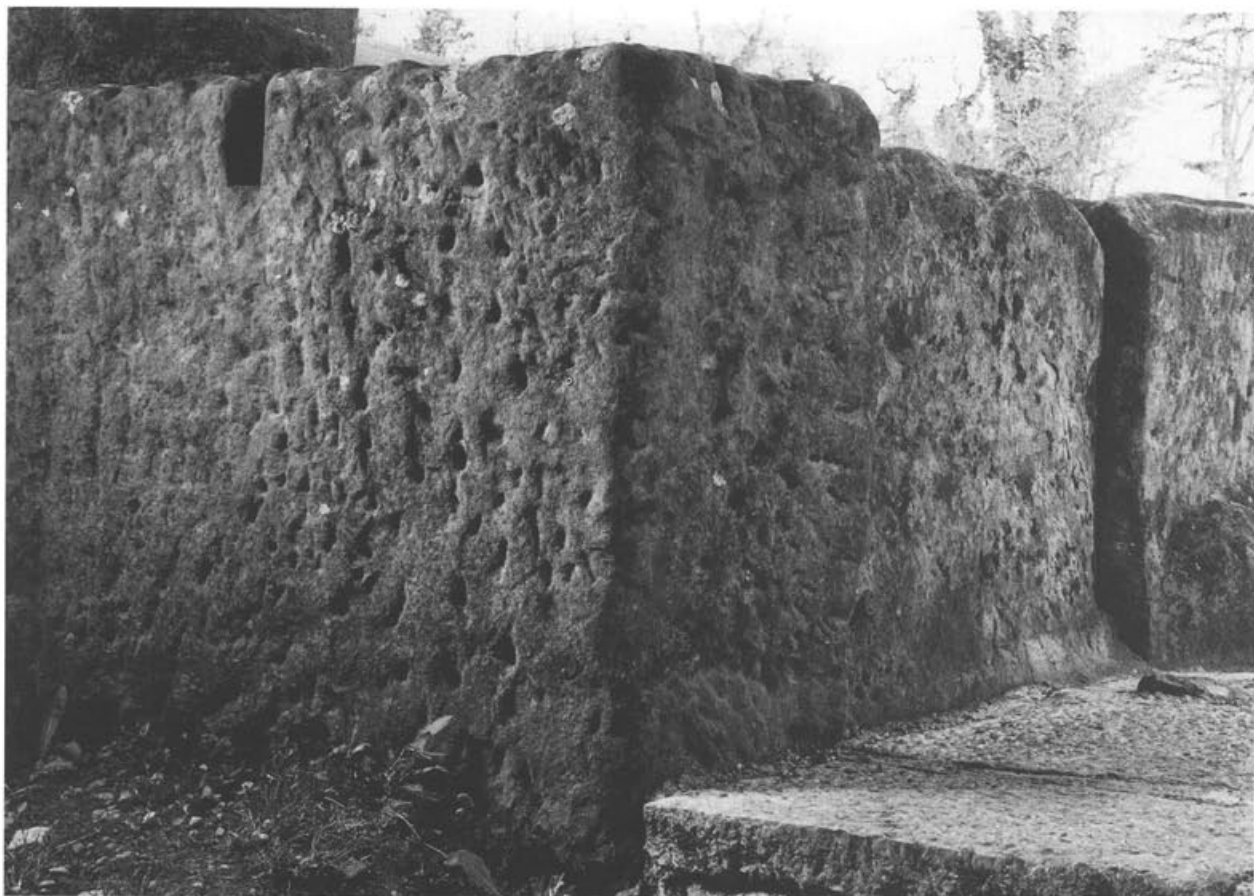
Abb. 26 Augst, Insula 44 (Grabung 1971.53). Wiederaufgebauter Strassenbrunnen 7b. Aussenseite der Wandplatten 748, 754 und 755. Bearbeitungsspuren von der Erstverwendung der Platte 748. Rechts: zurückgesetzte Aussenseitenflächen der Platten 754 und 755.
