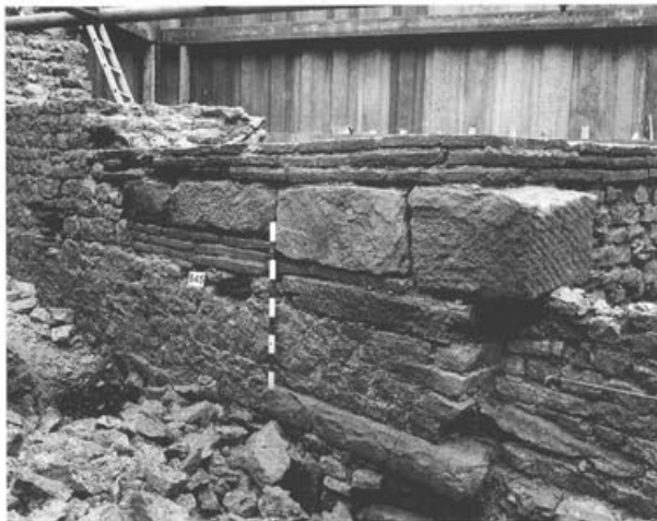
Abb. 28 Augst BL, Insula 17 (Frauenthermen) und Region 2, A (Grabung 1996.61). Blick an die durch den Einbau von grossen Sandstein-spolien und Ziegellagen aus tegulae und suspensura -Platten charakterisierte Flickstelle der 4. Bauperiode im Bereich des Eckverbandes zwischen MR 1 (links) und MR 2 (rechts oben). Gut zu erkennen ist namentlich die Baufuge zwischen dem bereits in der 3. Bauperiode errichteten (im Zuge der Grabung z.T. abgebrochenen) Teil der MR 1 und den Reparaturen der 4. Bauperiode. Rechts im Vordergrund die ebenfalls in der 4. Bauperiode erstellte Wange des Abwasserkanals (MR 3). Zur Lage vgl. Abb. 22, 4.
