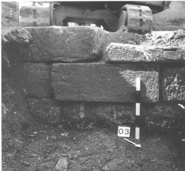
Abb. 19 Augst BL, Region 10,C (Grabung 1996.59). Beim Aushub von Werkleitungsgräben angeschnittene, neuzeitliche Stützmauer (MR 23). Bei den darin verbauten Sandsteinquadern handelt es sich um (römische?) Spolien, welche beim Abbruch der Wangen des Mühlekanals angefallen sind. Zur Lage vgl. Abb. 18.
