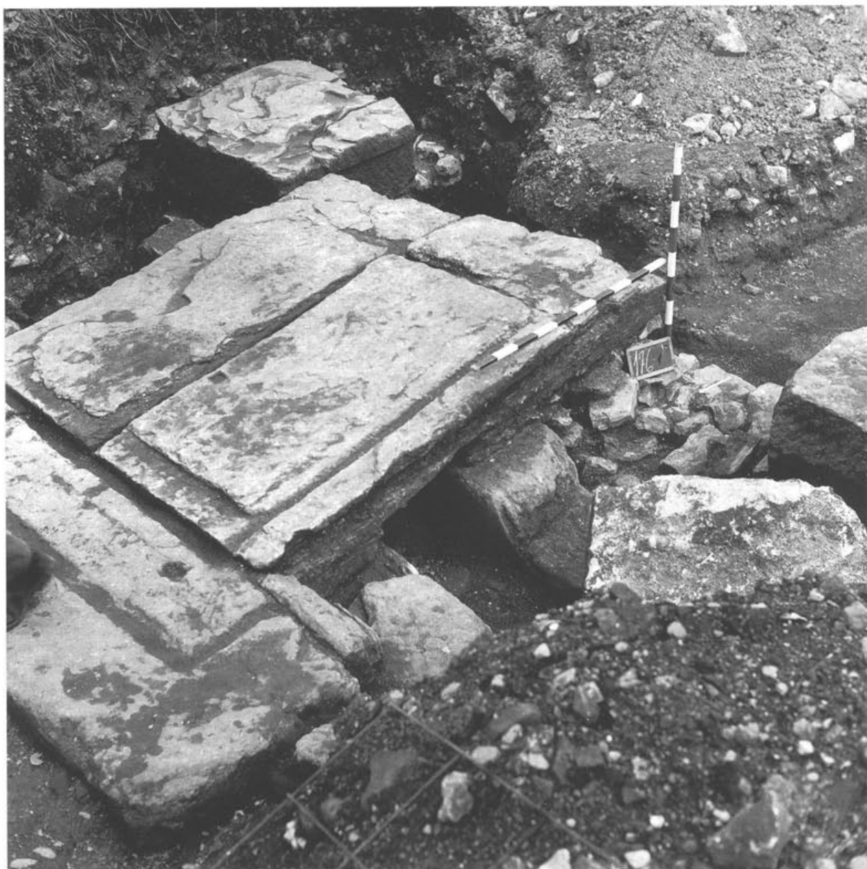
Abb. 2 ▼ Augst, Insula 19 (Grabung 1970.53). Stras- senbrunnen 2a/2b. Die beiden Quader hin- ten rechts sind die Basen von Porticussä- ulen, davor verläuft der Strassengraben, über welchem die beiden (jüngeren) Brunnen- fundamentplatten 2b verlegt sind. Davor Richtung Strassenmitte (links unten) Teile der Bodenplatten eines älteren Brunnens 2a. Blick von Nordwesten.
