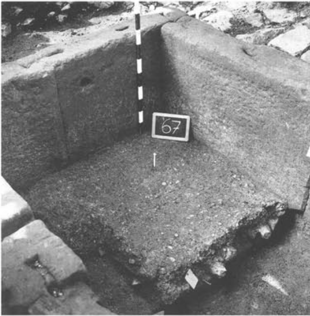
Abb. 19 Augst, Insula 44 (Grabung 1971.53). Blick in den Strassenbrunnen 7b nach vollständiger Entfernung der Füllschichten. Gut sichtbar sind links aussen die Bauklammervertiefung und die Zuflussrinne auf der Brüstung der Steinplatte 751 (Abb. 16), hinten links das Auslaufloch in Platte 753 und unten der Bodenbelag aus kompaktem Kiesmörtel auf einem Steinbett. Blick von Süden.
