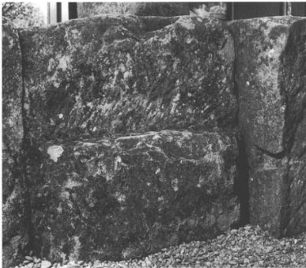
Abb. 33 Augst, Insula 44 (Grabung 1971.53). Wiederaufgebauter Strassenbrunnen 7b. Vertiefung für eine doppelschwalbenschwanzförmige Klammer in Platte 747 am rechten Bildrand. Gut zu erkennen ist auch die zurückgespitzte Aussenfläche der Platte 750 in der Bildmitte.
