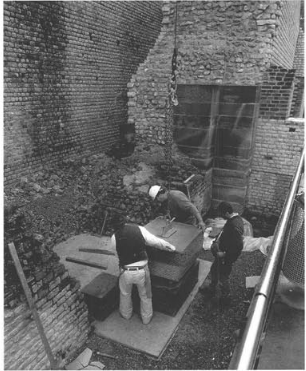
Abb. 12 Augst, Theatersanierung (Grabung 1996.55). Verstärkungen im Fundamentbereich der nördlichen Cavea-Abschlussmauer (MR 60). Mit Pneukran und einem dem antiken «Wolf» nachempfundenen Hebezeug werden die Sandsteinblöcke präzise versetzt.
