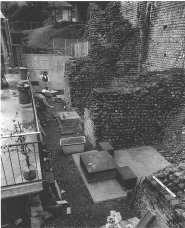
Abb. 11 Augst, Theatersanierung (Grabung 1996.55). Verstärkungen im Fundamentbereich der nördlichen Cavea-Abschlussmauer (MR 60). Versetzen der Sandsteinblöcke.
