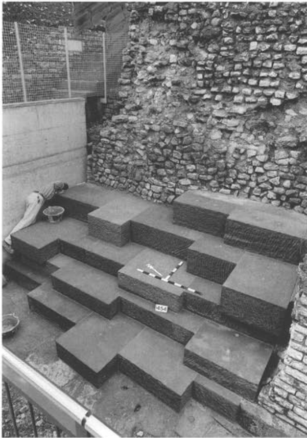
Abb. 15 Augst, Theatersanierung (Grabung 1996.55). Verstärkungen im Fundamentbereich der nördlichen Cavea-Abschlussmauer. Fertig versetzte Sandsteinquader auf dem nördlichen Pfeilerfundament. Ausdehnung und Aussehen dieses Pfeilers sind unbekannt. Deshalb wurde die aus statischen Gründen notwendige Ergänzung als unfertiges Fundament gestaltet. Die Dimension der Quader und der Fugenschnitt folgen, soweit rekonstruierbar, dem Originalbefund.
