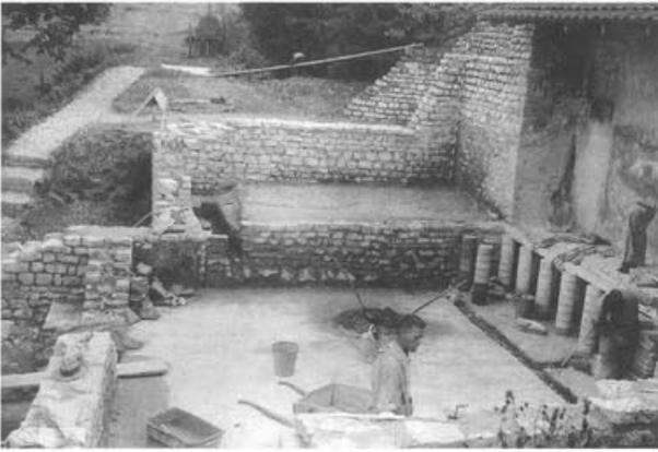
Abb. 8 Augst, Insula 10, sog. Hypokaustzimmer am «Schneckenberg» (Grabung 1945.55). Blick von Norden in das Hypokaustzimmer am «Schneckenberg» während den Restaurierungsarbeiten 1945. Auf der rechten Seite ist die rekonstruierte Hypokaustkonstruktion zu erkennen, im Hintergrund die Nische mit dem Heizkanal.
