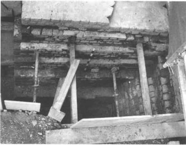
Abb. 3 Augst, Theatersanierung (Grabung 1994.55). Aufsicht auf die Grabungsfläche und den abgetrepten Stützpfiler MR 14/ MR 245/MR 250. An der Unterkante des Pfeilers ist die aus grossen Buntsandsteinquadern bestehende ältere Bauphase (MR 245) zu erkennen. Am rechten Bildrand erkennt man die schräg verlaufende Abfasung in MR 1/MR 244.
