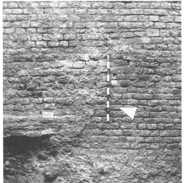
Abb. 10 Augst, Theatersanierung (Grabung 1992.55). Ansicht von Osten an MR 1 (links) und MR 8 (rechts). Ungefähr in der Bildmitte (Pfeil) ist die Baufuge zu erkennen, welche die beiden Mauern voneinander trennt.
