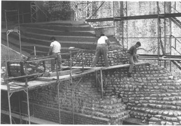
Abb. 19 Augst, Theatersanierung (1994). Nordaditus, Mauer 2. Aufmauern der Verschleisschicht aus Kalksteinen.
