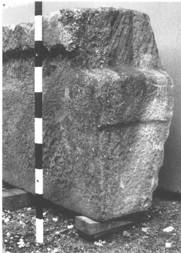
Abb. 9 Augst, Theatersanierung (Grabung 1994.55). Sondierschnitt an Stützpfiler MR 14. Aus Degerfelder Buntsandstein gearbeiteter Keilstein eines Bogendurchgangs der nördlichen Eingangshalle. Die Stirnseite des Bogens ist verhältnismässig schwach profiliert.
