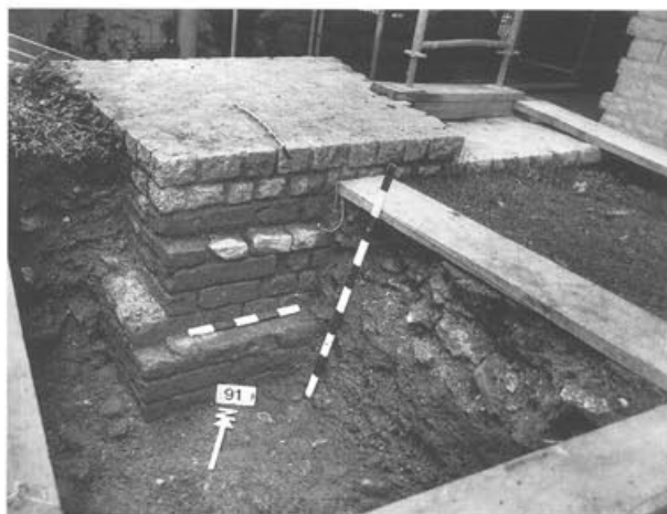
Abb. 7 Augst, Theatersanierung (Grabung 1994.55). Sondierschnitt an Stützpfeiler MR 14 bei Grabungsbeginn. Die abgetreppte Südseite und der aus Buntsandsteinen gemauerte Eckverband sind bereits deutlich erkennbar.
