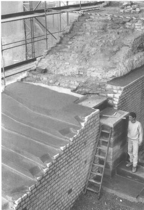
Abb. 18 Augst, Theatersanierung (1994). Nordaditus, Mauer I. Mauerkrone mit aufgebrachtter Isolationsschicht; im Hintergrund originaler Mauerkerne.
