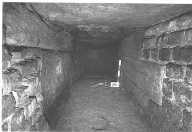
Abb. 5 Augst, Theatersanierung (Grabung 1994.55). Abwasserkanal im Südaditus. Blick von Süden in den Abwasserkanal. Links ist die Abbruchkante von Mauer 211 zu erkennen. Man beachte rechts die grossen Sandsteinquader der ursprünglichen Einfassung des Einstiegschachts; die Quader binden sauber in das Kalksteinmauerwerk ein und bilden mit dem im Norden anschliessenden «Sandsteinkanal» eine Stossfuge.
