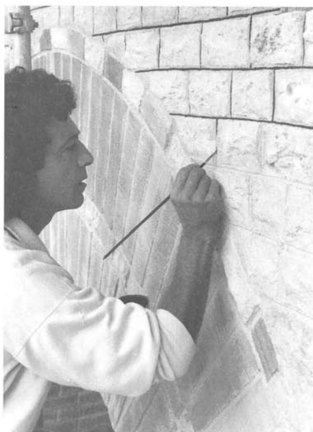
Abb. 29 Augst, Theatersanierung (1993). Retuschen am nun ausgeschalteten Fenstergewölbe.
