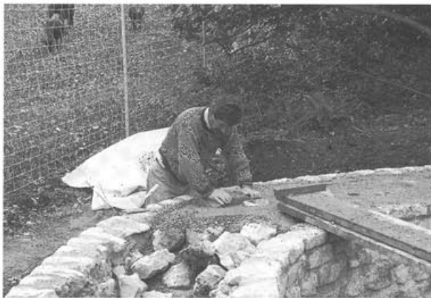
Abb. 15 Augst, Osttor (Grabung 1993.52). Aufmauern des südlichen Turmfundamentes.
