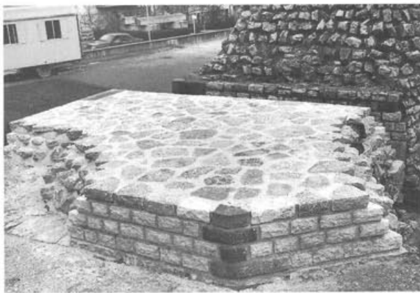
Abb. 18 Kaiseraugst, Kastellmauer Südwest-Turm. Zustand nach Restaurierung: wasserdichte Abdeckung der Mauerkrone mit Kalkstein-Abdeckplatten (sorgfältig ausgefugt, mit leichtem Gefälle).
