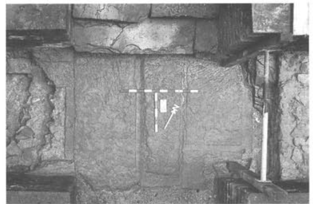
Abb. 14 Augst, Theatersanierung (Grabung 1993.55). Mitteltreppe: Sandsteinunterlage des oberen Treppenhpodestes; Oberflächenbearbeitung.
