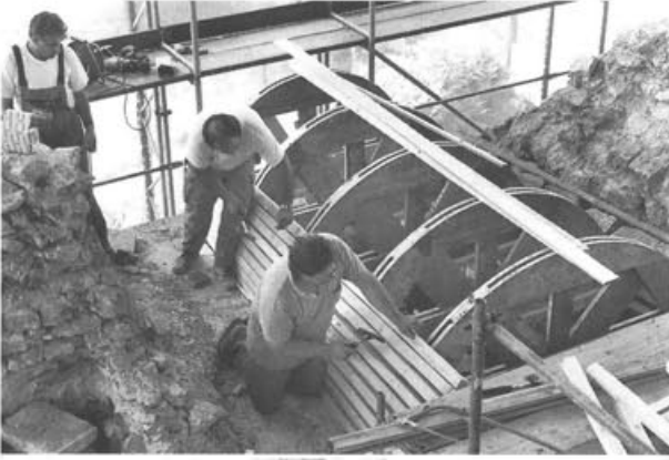
Abb. 18 Augst, Theatersanierung (1993). Die Gewölbeschalung wird eingebaut.
