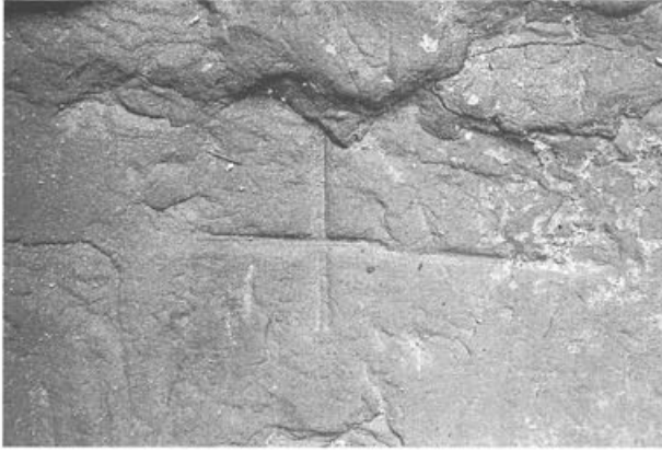
Abb. 15 Augst, Theatersanierung (Grabung 1993.55). Mitteltreppe: Sandsteinunterlage des oberen Treppenpodestes. Eingemeisselte Versetz- oder Messmarke.
