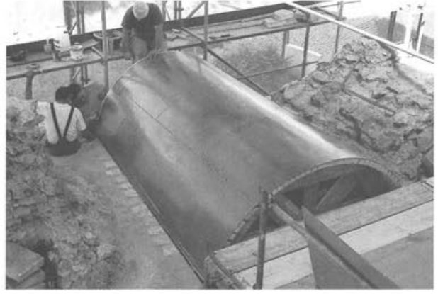
Abb. 19 Augst, Theatersanierung (1993). Fertige Gewölbeschalung.
