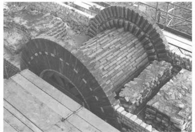
Abb. 24–26 Augst, Theatersanierung (1993). Unterer Teil der Gewölbeschale als Ver- blendung.
