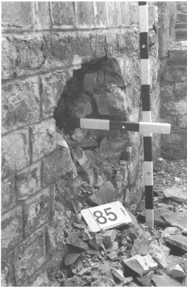
Abb. 26 Augst, Theatersanierung (Grabung 1992.55), Drittes Theater. Ausbruch als typisches Schadensbild am Augster Theater (Mauerschale der nördlichen Umfassungsmauer).
