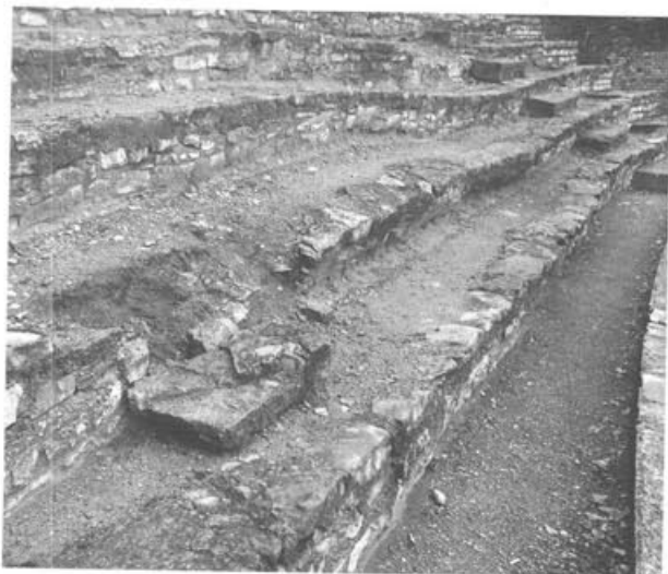
Abb. 3 Augst, Theatersanierung (Grabung 1992.55). Zerfallserscheinungen durch Auflösung des Mörtels und durch Abrutschungen (Sitzstufen-Fundamente in der mittleren Cavea des Dritten Theaters).
