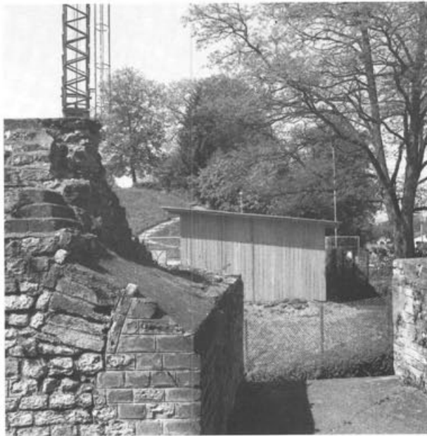
Abb. 30 Augst, Theatersanierung (Grabung 1992.55), Drittes Theater. Fenster in Mauer 1 von Osten vor den Restaurierungsarbeiten von 1992/93: Beim Gewölbeansatz links sind die fünf untersten Keilsteine des äusseren Bogens in situ erhalten (vgl. Abb. 33); der innere Bogen ist auf dem Bild noch falsch ergänzt.
