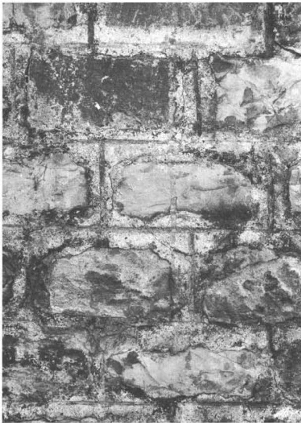
Abb. 23 Augst, Theatersanierung (Grabung 1992.55), Drittes Theater. Originaler Fugenstrich, stellenweise mit erhaltener roter Ausmalung (Mauer 44 im südlichen Aditus, von Osten). M. 1:4.
