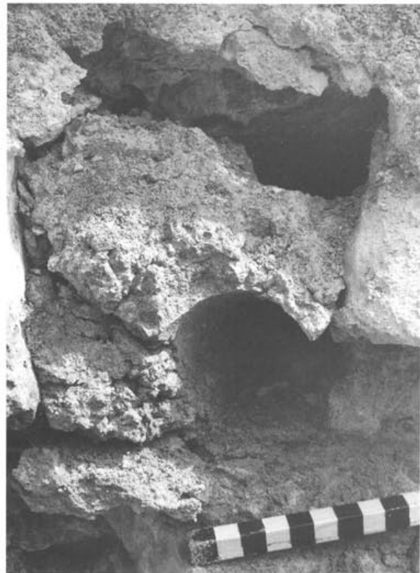
Abb. 22 Augst, Theatersanierung (Grabung 1992.55), Drittes Theater. Detail aus dem Kern von Mauer 1 (Westseite) mit «zwei-phasigem» Balkenloch: ein grosses Balkenloch von quadratischem Querschnitt (ca. 12×12 cm) wurde noch in römischer Zeit mit einem kleinen Rundholz (5 cm Durchmesser) und Mörtel gefüllt.
