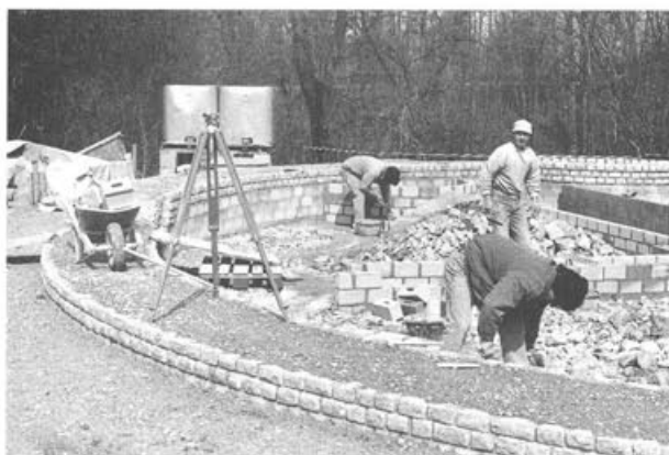
Abb. 35 Augst BL, Grabrotunde vor dem Osttor (Grabung 1991.52). Die Maurerequipe des Augster Ruinendienstes beim Restaurieren. Die zu ergänzenden, im Endeffekt nicht mehr sichtbaren Mauerpartien werden aus Kostengründen in Zementstein aufgeführt, die sichtbaren Teile aus kleinen, handgebrochenen Jurakalkquadern.
