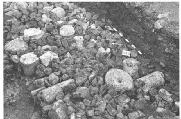
Abb. 24 Augst BL, Grabung 1991.51 (Kastelen). Detail aus dem Fundamentkoffer der spätrömischen Befestigungsmauer 18. Das Fehlen von Mörtel auf der Oberkante der Spolien zeigt, dass das aufgehende Mauerwerk auf einer (in Phase IV) geraubten Sandsteinquaderlage gelegen haben muss (vgl. auch Abb. 25).
