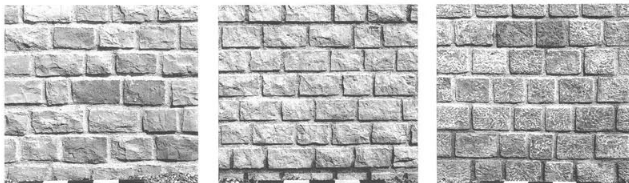
Abb. 34 Augst BL, Theater. Für die Theater-Gesamtsanierung wurden verschiedene Kalksteine, Bearbeitungstechniken, Mörtelmischungen usw. getestet. Die drei Muster dienen als Entscheidungshilfe: links grauer und beiger, maschinell gebrochener und von Hand nachgerichteter Muschelkalk von der Lägern AG; Mitte maschinell gefräste und gebrochene (an den Kanten von Hand nachgerichtete) Handquader aus Solothurner Malmkalk, rechts handgehauene Quader aus Muschelkalk von Reigoldswil BL und Wisen SO (gemischt).
