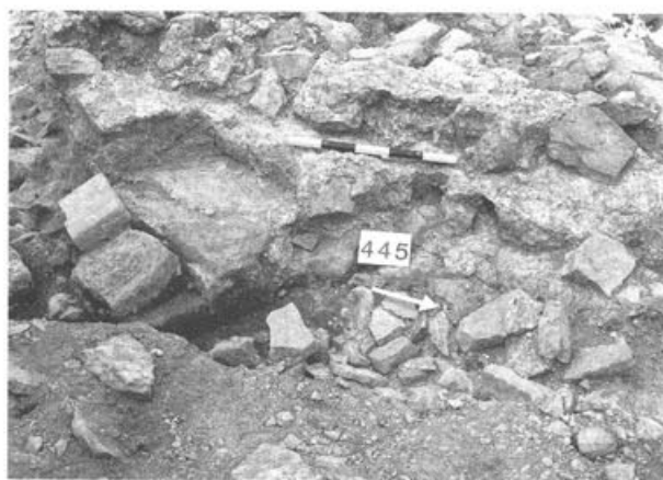
Abb. 27 Augst BL, Grabung 1991.51 (Kastelen). Detail des Gussmauerwerks der spätrömischen Befestigungsmauer 18. Gut zu erkennen ist das Negativ eines in Phase IV gebauten Steinquaders.
