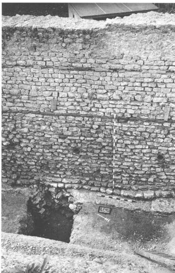
Abb. 17 Augst BL, Insula 5/9, Grabung 1965–1967.52, Taberne. Ansicht an die Mauer 1 von Osten. Im unteren Bereich der Mauer sind die aus Imbrices konstruierten Röhren zu erkennen, die als Parallelen zu denjenigen auf Abb. 18 angesprochen werden.
