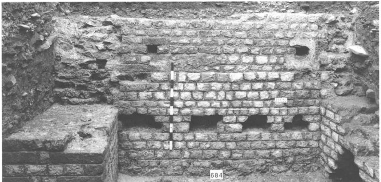
Abb. 53 Augst BL, Grabung 1990.51, Fläche 3. Ansicht der Umfassungsmauer 3 des 1. Theaters in Phase 8. Deutlich zu erkennen sind die beim Abbruch der Strebepfeiler 1 und 2 (MR 4 und 9) entstandenen Ausbrüche in der Umfassungsmauer 3, die aus der Bauzeit (Phase 4) stammenden Gerüstbalkenlöcher und die in Phase 6 ausgebrochenen Balkenlager der Kanalabdeckung.
