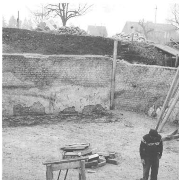
Abb. 21 Augst BL, Grabung 1961.60. Blick vom Inneren der Curia auf die Innenwand der Curiamauer (MR 1). Der massive Senkungsris ist auf das Unterhöhlen des Curiafundamentes beim Bau der jüngeren Basilika-Stützmauer zurückzuführen. Er ist heute durch moderne Restaurierungsarbeiten weitgehend beseitigt worden. Photo von den Restaurierungsarbeiten; Blick nach Norden.
