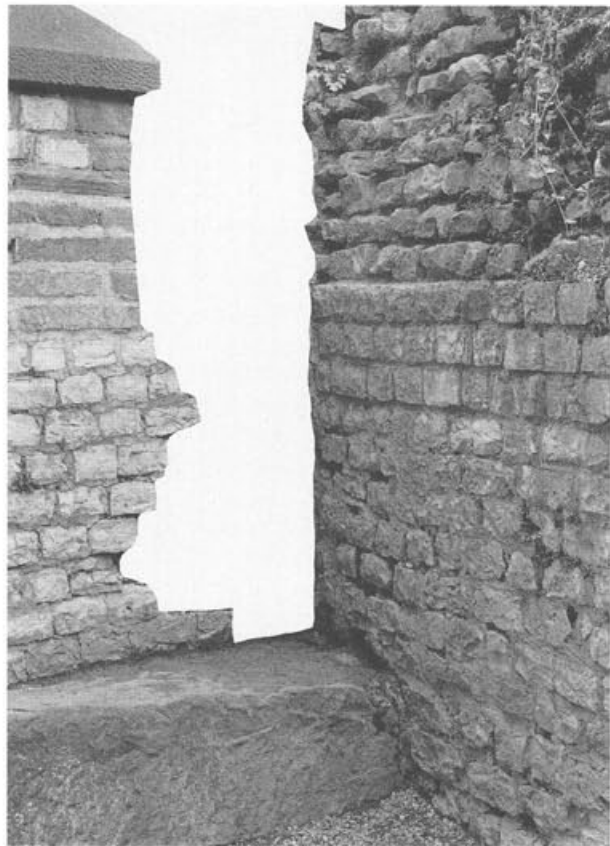
Abb. 74 Augst BL, Theater. Detail einer Baufuge zwischen einer im Fundamentbereich eines Strebepfeilers des 3. Theaters eingemauerten Sandsteinschwelle (links im Bild) und der Umfassungsmauer des 1. bzw. 2. Theaters (rechts). Die deutlich erkennbare Stossfuge zeigt, dass die Umfassungsmauer des 1. bzw. 2. Theaters beim Bau des 3. Theaters noch erhalten gewesen sein muss. Auf der Aufnahme sind neuzeitliche, den Befund verfälschende Reparaturen und Rekonstruktionen herausretuschiert worden.
