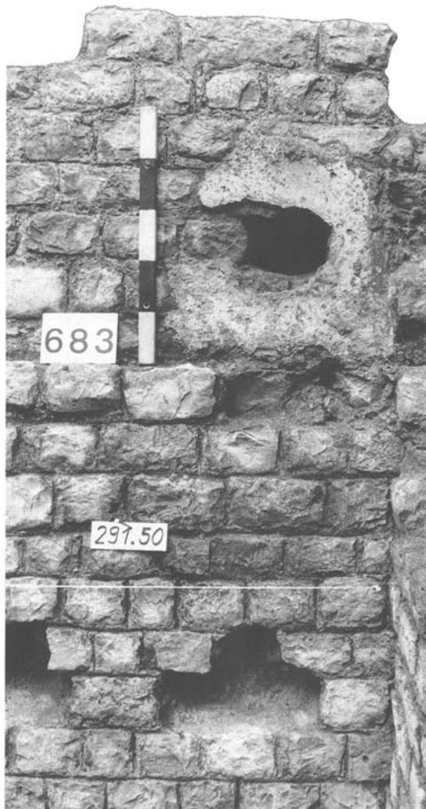
Abb. 26 Augst BL, Grabung 1990.51, Fläche 3. Ansicht des Bruchsteinmauerwerkes von Strebepfeiler 2. Zu beachten ist vor allem der sorgfältig ausgeführte Fugenstrich.
