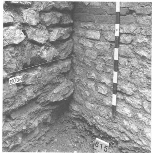
Abb. 20 Augst BL, Grabung 1990.51, Fläche 3. Stossfuge zwischen der älteren Kellermauer (MR 5) der Phasen 1 und 2 und dem jüngeren Fundament von Strebepfeiler 1 (MR 4) des 1. Theaters (Phase 4).
