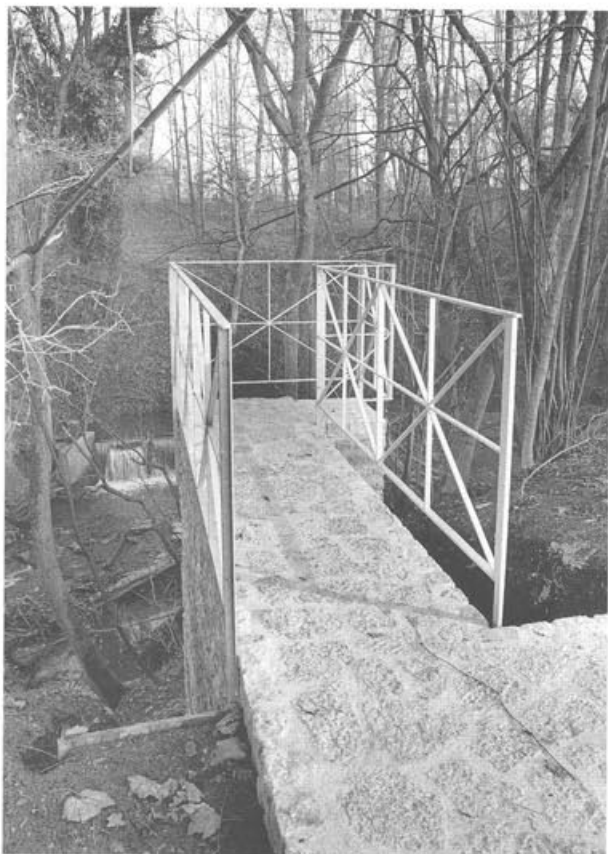
Abb. 15 Die neu restaurierte Stützmauer vor dem Osttor mündet heute in das Tobel des Violenbaches (im Hintergrund). Die heute fehlenden Mauerpartien sind in nachrömischer Zeit erodiert worden bzw. ins Bachbett abgerutscht.
