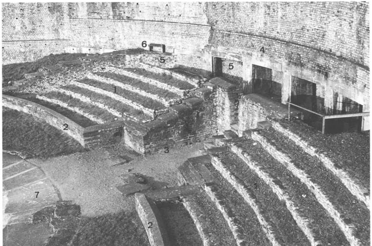
Abb. 69 Augst BL, Theater. Blick auf die Sitzstufen (1) und die Arenamauer (2) mit dem einen Carcer (3) des Arenatheaters (2. Theater). Im Hintergrund ist die (mit modernen Betonstützen unterfangene) Cavea-Stützmauer des 3. Theaters (4) zu erkennen, die z.T. auf der Umgangsmauer der Orchestra des 1. Theaters (5) aufbaut. 6 bezeichnet den Standort der eingemauerten Bauinschrift des 1. Theaters (Abb. 73). Im Vordergrund sind bei 7 die Reste der Orchestra-Mauer des 3. Theaters zu erkennen.
