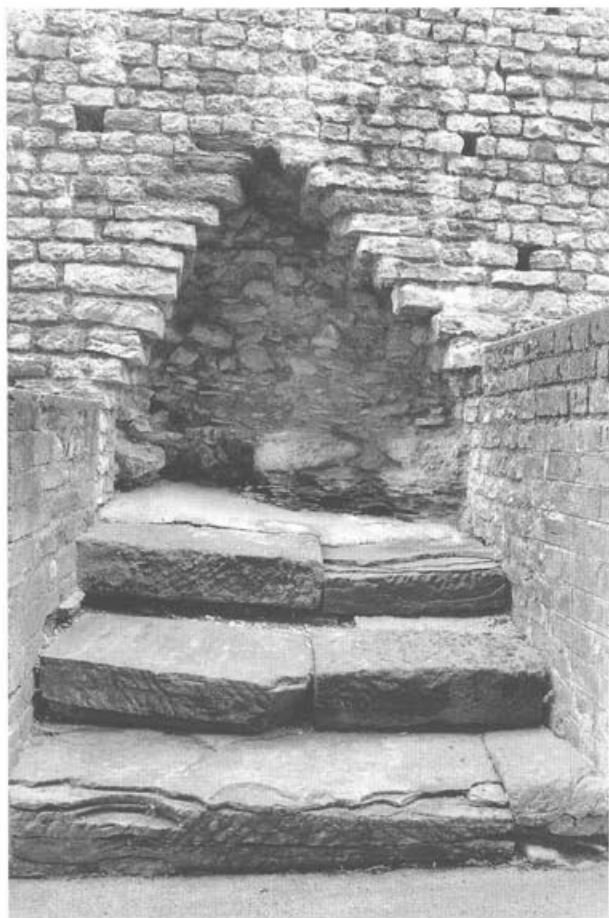
Abb. 72 Augst BL, Theater. Blick auf die beim Bau der Wangenmauern des Mittelvomitoriums des 3. Theaters zugemauerten, rund 1,7 m breiten oberen Seitentrepfen des 1. bzw. 2. Theaters. Links im Bild sind die Stufen der einen Seitentreppe noch erhalten, rechts sind sie bei neuzeitlichen Untersuchungen entfernt worden.
