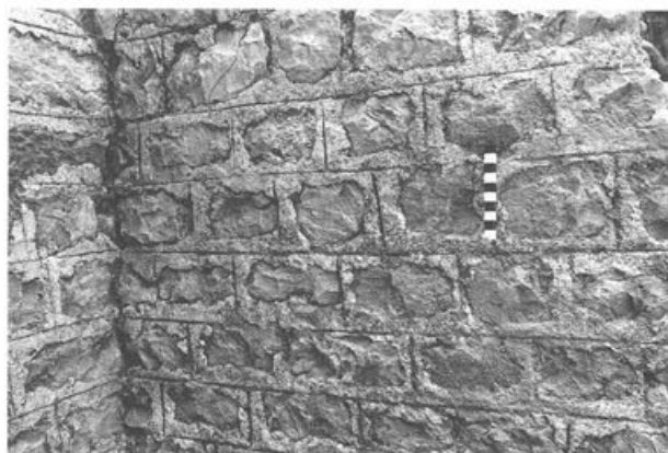
Abb. 12 Augst BL, Grabung 1990.52 (Osttor). Ostseite der Stützmauer mit steinsichtigem Verputz und sorgfältig gezogenem Fugenstrich, beim Anschluss des Pfeilers (links) an die Mauer 8. Blick nach Südwesten.
