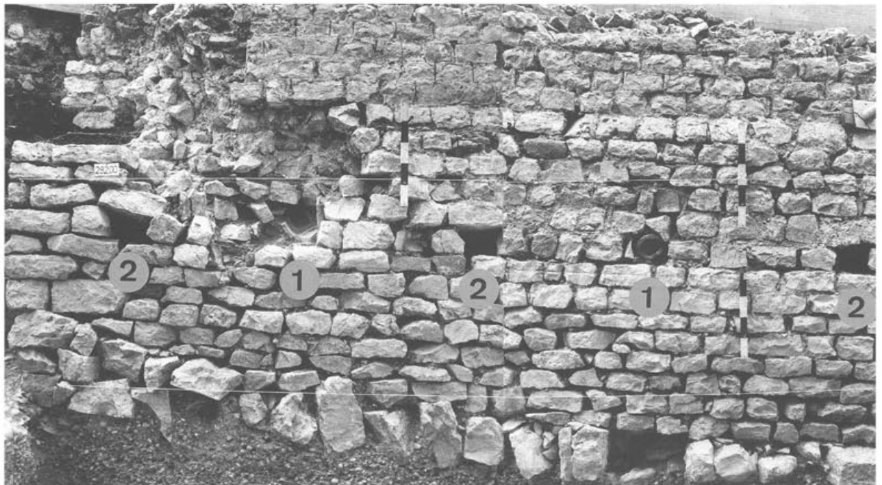
Abb. 19 Augst BL, Nordwestfront Frauenthermen, Grabung 1990.51. Ansicht an die Mauer 1 von Norden (Aussenseite). Unterhalb der Höhenlinie 292,00 m ü. M. (obere Schnur) sind die Röhren aus Imbrices (1) und die Gerüstbalkenlöcher (2) zu erkennen. Drei Lagen oberhalb der Höhenlinie 292,00 m ü. M. ist die Fase des 1. Bauzustandes zu erkennen. M. 1:25.
