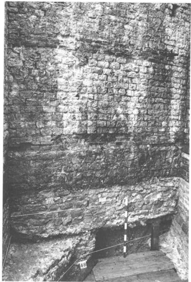
Abb. 19 Augst BL, Grabung 1990.53. Ansicht der Curiamauer (MR 1). Der unter dem ersten Ziegeldurchschuss liegende, grob strukturierte Mauerteil war in der Antike in eine heute verschwundene Böschung eingetieft. Sie besitzt deshalb im unteren Mauerteil noch keine Gerüstbalkenlöcher (vgl. auch Abb. 28, Profile 6 und 7). Blick nach Osten.
