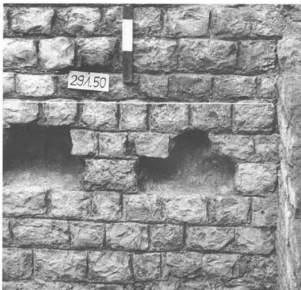
Abb. 25 Augst BL, Grabung 1990.51, Fläche 3. Ausschnitt aus dem aufgehenden Bruchsteinmauerwerk der Umfassungsmauer 3 des 1. Theaters (Phase 4) mit den in Phase 6 ausgebrochenen Balkenlagern (vgl. Abb. 42 und 47).
