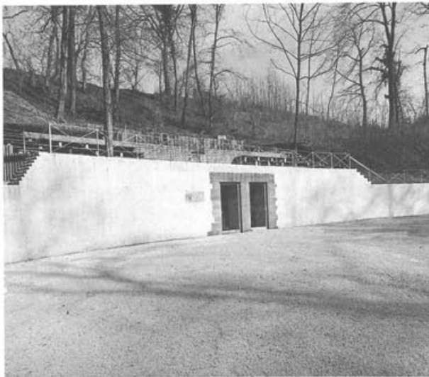
Abb. 22 Restaurierungsarbeiten im Amphitheater: Der nördliche Zwinger ( carcer ) ist heute mit einer Betondecke geschlossen (die später mit einer Kaschierung in Buntsandstein versehen werden soll). Die archäologischen Befunde erlaubten es, hier die Arenamauer auf ihre ursprünglich Höhe von 3,1 m aufzuführen und den Zwingereingang mit zwei Sandsteingewänden zu rekonstruieren, von denen einige Fundamentreste erhalten geblieben waren. Beidseits der Zwingerdecke, die einst als Ehrentribüne ( pulvinar ) diente, sind einige wenige Sitzstufen in Holz rekonstruiert, die über einen neuen Zugang betreten werden können. Die Arenamauer selbst ist, basierend auf den Grabungsbefunden, mit einem feinen Kalkabrieb verputzt.
