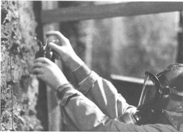
Abb. 3 Lackprofil-Abnahme beim Augster Theater 1988: Beim Sprühen wird darauf geachtet, dass ein möglichst gutes Eindringen der Mowilith-Lösung rund um die einzeln hervorstehenden Steine erfolgt.
