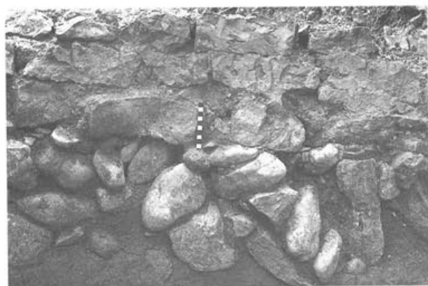
Abb. 28 Augst-Amphitheater 1988. Detail von MR20 mit Kiesel- und Bruchsteinfundament sowie Quadern in petra rasa -Technik. Blick von Süden.
