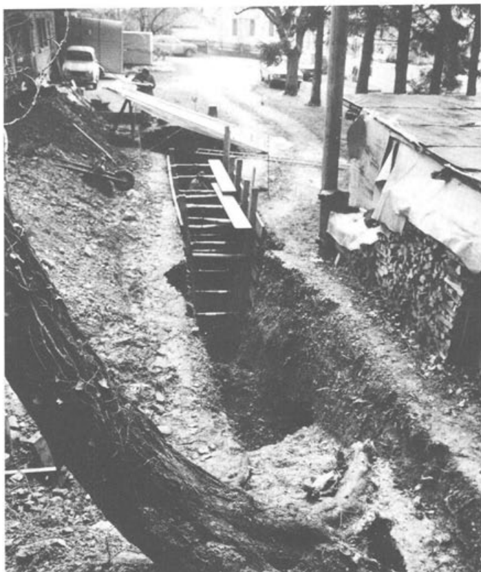
Abb. 37 Augst, FTS-Projekt, Parz. 435/654, Insula 9. Der Suchschnitt, wegen Einsturzgefahr mit Spriessung, im Bereich des ersten Spitzgrabens und im Vordergrund die Halsgrabenstrasse. Ansicht von Nordwesten.
