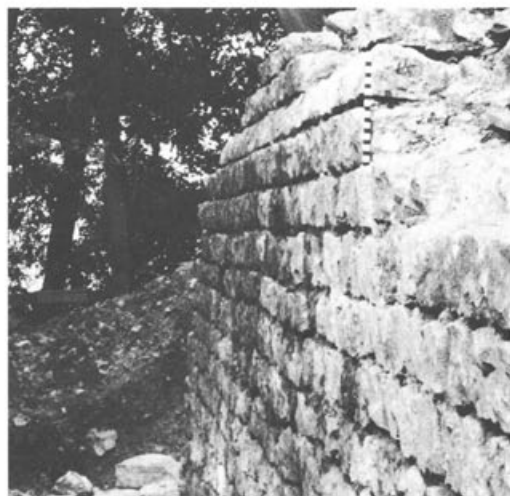
Abb. 71 (links) Augst-Amphitheater 1986. Hangstützmauer 5 im Westeingang: Detail der südlichen Mauerfront (gegen Rampe und Mittelkorridor links) mit einlagiger Mauerfase (schräge Zurückversetzung der Mauerfront) beim kleinen Massstab (= 0,2 m).
