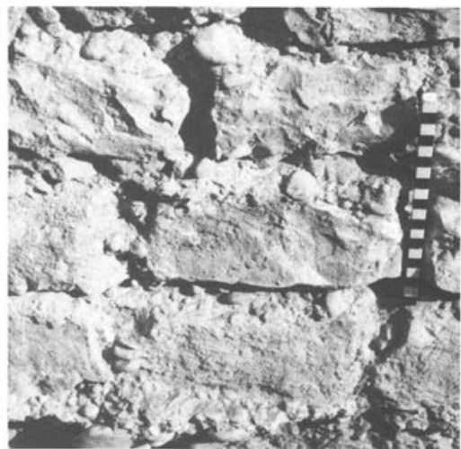
Abb. 73 (links) Augst-Amphitheater 1986. Hangstützmauer 5 im Westeingang: Detail der nördlichen Mauerfront (gegen cavea ) mit dreilagiger Mauerfase (= Abb. 61, Nr. 9; vgl. davorliegender, später Gehhorizont Abb. 78). Massstab balken: 0,5 m.
