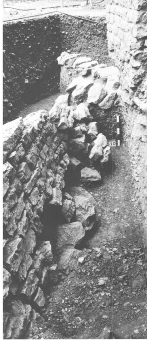
Abb. 32 (links) Augst-Amphitheater 1986. Arenamauer 2 (Nordostquadrant) vom Pneukran aus fotografiert: unten das restaurierte und ergänzte nördliche Torgewände des Osteinganges (vgl. Abb. 57), oben die durch Hangdruck arenawärts verrutschte Arenamauer.
