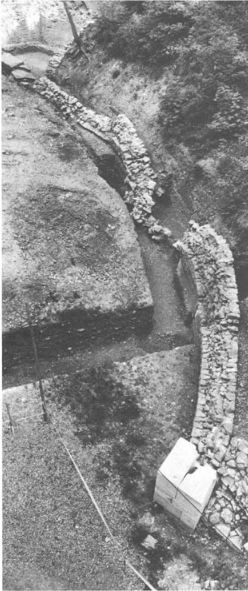
Abb. 32 (links) Augst-Amphitheater 1986. Arenamauer 2 (Nordostquadrant) vom Pneukran aus fotografiert: unten das restaurierte und ergänzte nördliche Torgewände des Osteinganges (vgl. Abb. 57), oben die durch Hangdruck arenawärts verrutschte Arenamauer.
