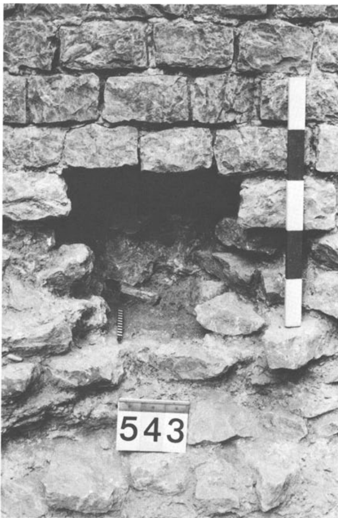
Abb. 47 Augst-Amphitheater 1986. Balteus -Mauer 13 im carcer , unmittelbar über der Apsis: Blick von Süden an die Mauerfront, mit ausgespartem Balkenlager (?) von 0,16 m Weite (vgl. Abb. 38 und 42). Die Quaderverblendung darüber ist stellenweise ausgebrochen.
