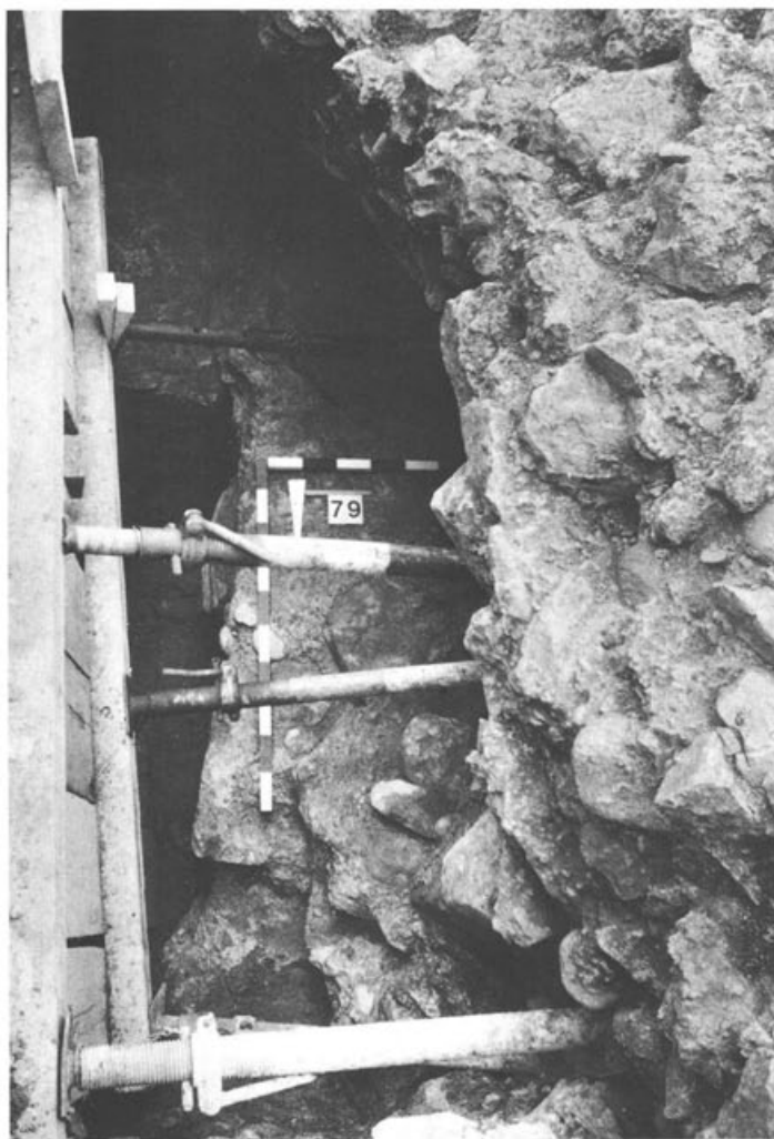
Abb. 17 Kaiseraugst, Parz. 89, Oechslin, Kastell-SO-Ecke, Turm 8. Blick von N in die Sondierung O; Kalkstein-Mörtelguss des Fundamentkerns und OK Sandsteinquader (vgl. Profil Abb. 16,3).
