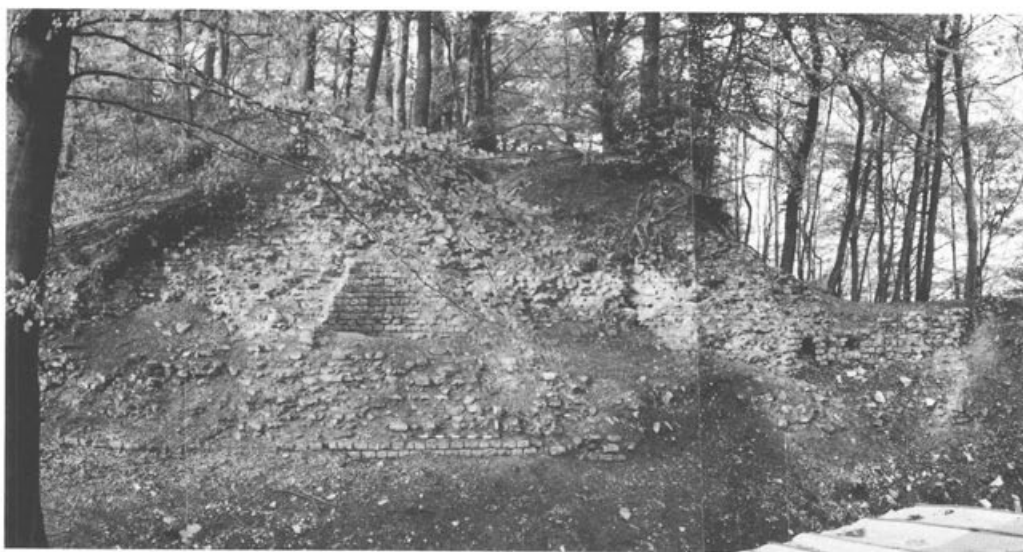
Abb. 59 Augst-Amphitheater 1982. Westeingang: Hangstützmauer 6 nach der oberflächlichen Freilegung. Erkennbar sind die Entlastungsbögen und die obersten Reihen des erhaltenen Mauerhauptes gegen den Mittelkorridor. Die untersten 2 m des aufgehenden Mauerwerks sind nicht freigelegt (vgl. Abb. 69).
