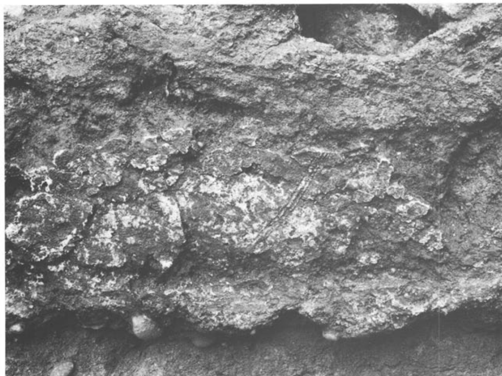
Abb. 27 Augst-Amphitheater 1986. Detail der Arenamauer 2 in Schnitt 1 (Ausschnitt aus Abb. 28, Nr. 7/8): dünner, weisser Kalkputz (mit drei parallelen Rillen) auf einer Ziegelschrotmörtel-Unterlage. Bildausschnitt etwa 0,3 m.
