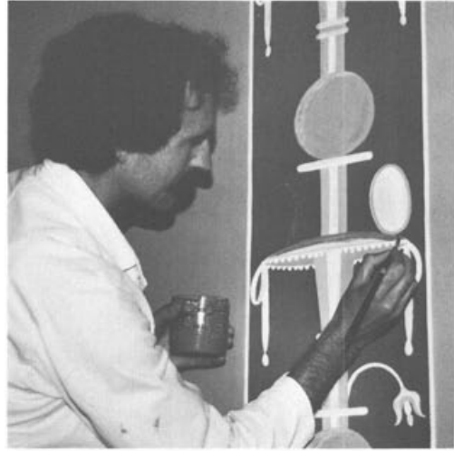
Abb. 3 Unter der Obhut des Malermeisterverbandes Basel-Stadt wird der Speisesaal im Römerhaus nach einem Neufund aus Augst neu ausgemalt: links paust ein Lehrling das Kandelabermotiv auf den grundierten Kalkverputz, und rechts malt der Vorarbeiter den Schirm eines Kandelabers mit Mineralfarbe aus.
