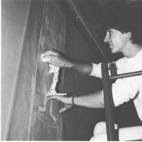
Abb. 3 Unter der Obhut des Malermeisterverbandes Basel-Stadt wird der Speisesaal im Römerhaus nach einem Neufund aus Augst neu ausgemalt: links paust ein Lehrling das Kandelabermotiv auf den grundierten Kalkverputz, und rechts malt der Vorarbeiter den Schirm eines Kandelabers mit Mineralfarbe aus.
