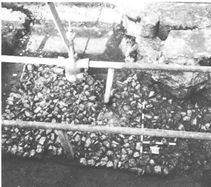
Abb. 50 Kaiseraugst, Parz. 67, Turm 6, Heidemurweg. Fundamentsüdrand des Turmes 6. Nur die erste Kalkbruchsteinlage ist erhalten, die darüber fehlenden Spolien, die in das Fundament eingemauert waren, wurden vermutlich während einer Steinausbeutung im 11. Jahrhundert 4 entfernt. Aufsicht von Süden.
