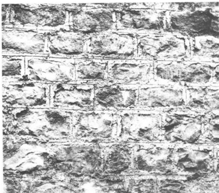
Abb. 6 Augst, Parz. 106.1, Giebenacherstrasse/Forum, Ins. XI. Detail der Westfrontmauer des Hauptforums mit sorgfältig ausgeführtem Fugenstrich um die einzelnen Handquader der Mauerverblendung. Ansicht von Südwesten.
