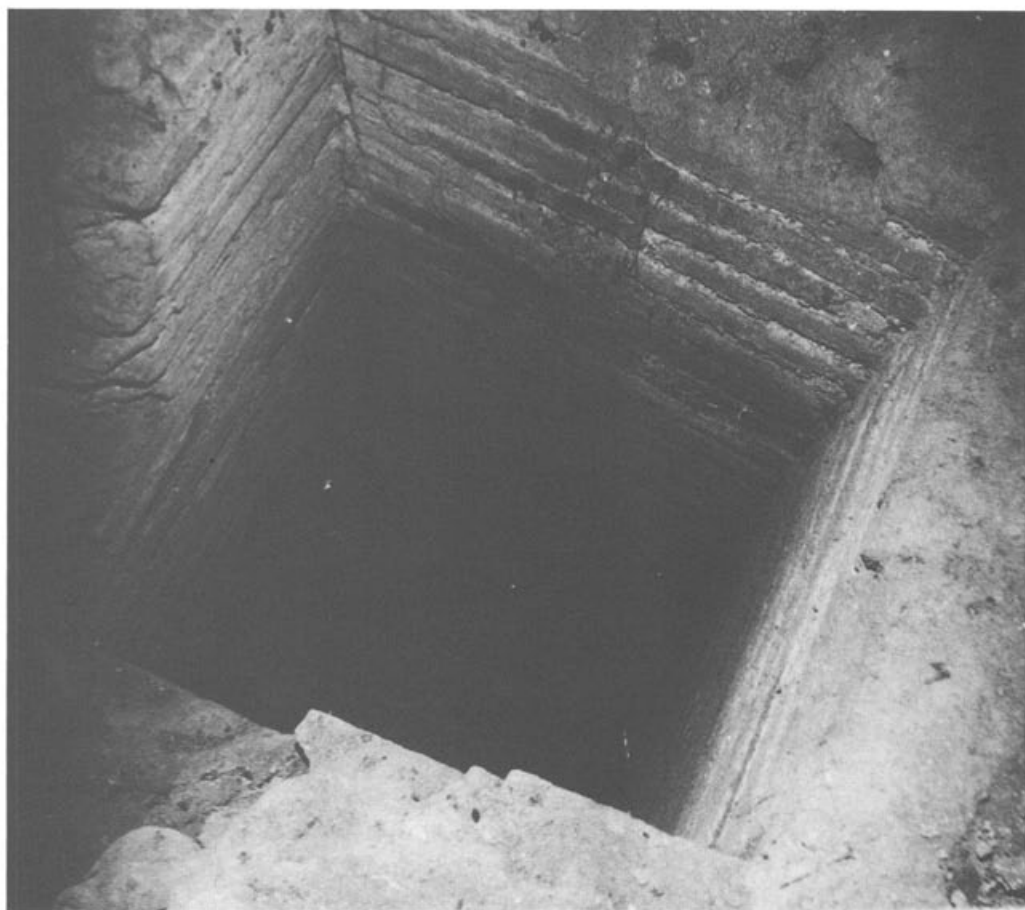
Abb. 9 Pompeji. Forumsthermen, Frauencaldarium, Heizschacht im Labrumssockel.
