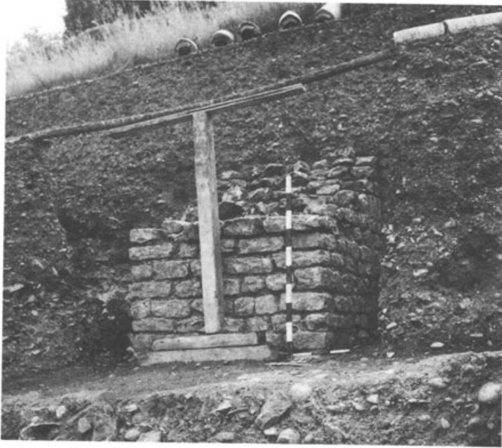
Abb. 2. Augst, Parz. 443/435, Giebenacherstrasse. Pfeilerartige Stütze am Hang des Kastelenhügels, die den Druck des steilen Hanges auffangen sollte.
