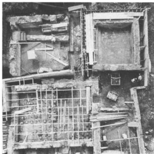
Abb. 31 Kaiseraugst, Parz. 8 + 12. Kindergarten (Thermen). Ausschnitt des westlichen Thermenkomplexes während der Konservierung. Teile der Betonummantelung sind bereits erstellt, und die Deckenschalung ist im Bau.
