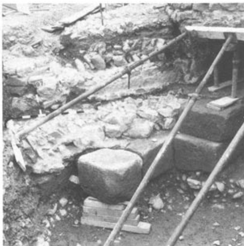
Abb.37 Kaiseraugst, Parz. 1 + 3. Westtor. Detailaufnahme des Südturmfundaments von Südwesten. Das Fundament bilden abwechselnd Sandstein- und Handquader, z.T. mit wasserdichtem Mörtel gebunden.
