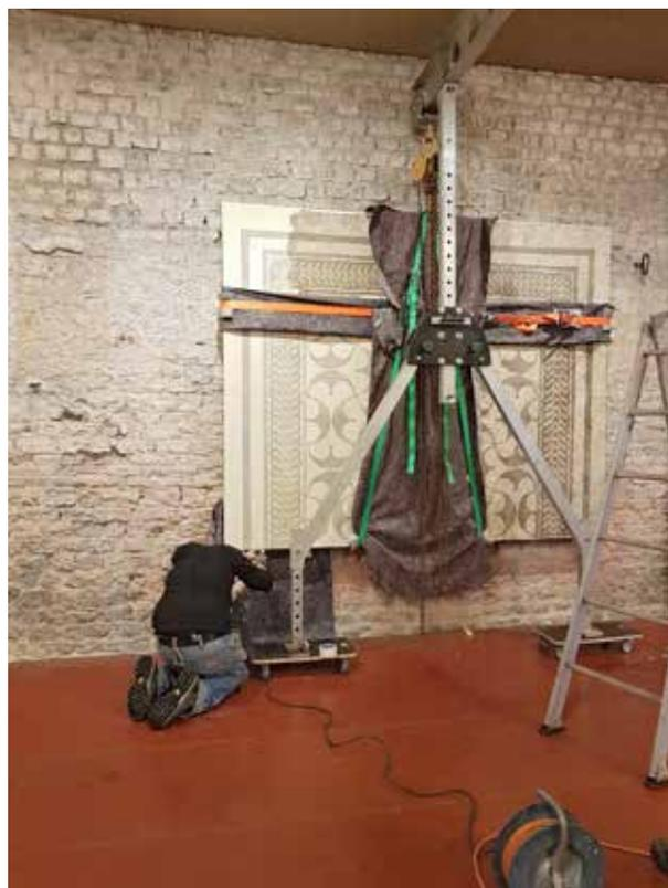
*Abb. 11: Augst BL, Curia (Monumentenrestaurierung 906.2021.01). Das Entfernen der direkt an den originalen Wänden befestigten, mehrere Hundert Kilogramm schweren Mosaikplatten ist ein heikles Unterfangen und verlangt viel Fingerspitzengefühl. Damit keine Schäden an den fragilen Mosaiken entstehen, ist bereits beim Anbringen der Tragegurten Sachkompetenz gefragt und grösste Vorsicht geboten.*
