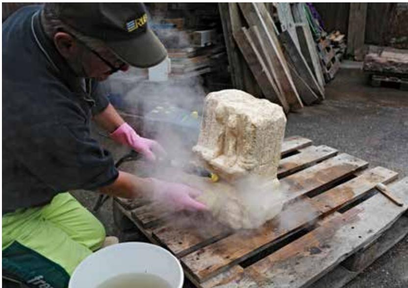
*Abb. 38: Augst BL, Grossteinlager Schwarzacker (Monumentenrestaurierung ohne Nr.). Reinigung und Neupalettierung der Werksteinstücke als Vorbereitung für den Umzug ins neue Depot im Sammlungszentrum 2023. Dank des Einsatzes eines mobilen Heissdampfgeräts lassen sich die mehrere Hundert Werksteine aus dem Depot zügig, aber dennoch schonend reinigen (Inv. 1975.11450).*
