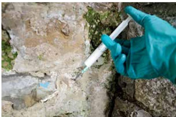
Abb. 26: Augst BL, Taberna (Monumentenrestaurierung 907.2021.01). Als unverzügliche Massnahme wurden zur Stabilisierung des Mörtels Injektionen mit Nanokalk vorgenommen.
