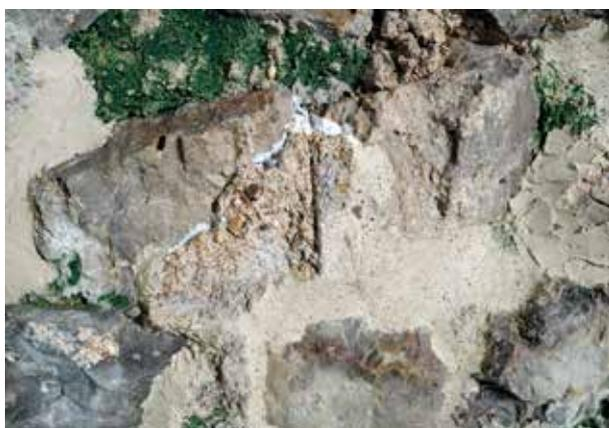
Abb. 27: Augst BL, Taberna (Monumentenrestaurierung 907.2021.01). Sämtliche Fehlstellen wurden mit Kalkmörtel geschlossen. Zum Zurückkleben der abgelösten Fugmörtel fand ebenfalls Nanokalk Verwendung, zusätzlich wurden die fragilen originalen Kanten mit Mörtelanböschungen gesichert.
