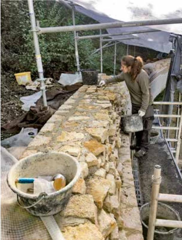
*Abb. 9: Augst BL, Amphitheater (Monumentenrestaurierung 905.2021.01). Chiara Marcon beim Fertigstellen der obersten Steinlage der neuen, als Kernabbruch gestalteten Überkronung.*
