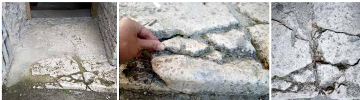
*Abb. 16:* Augst BL, Curia (Monumentenrestaurierung 906.2021.02). Neukonservierung der Kalksteinschwelle am Eingang zum Curiakeller. Als Folge von Wasser, Frost und intensiver Begehung war die originale Schwelle der ins Untergeschoss der Curia führenden Türe in sehr schlechtem Zustand. Im Stein haben sich viele Risse gebildet und etliche Teile des Steinblocks sind abgeplatzt.
