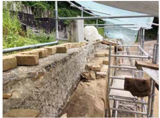
Abb. 7: Augst BL, Amphitheater (Monumentenrestaurierung 905.2021.01). Links im Bild die vorbereiteten Abdecksteine der neuen Überkronung, auf der rechten Seite der Übergang vom neu errichteten Schalenmauerwerk zum Kernmauerwerk.
