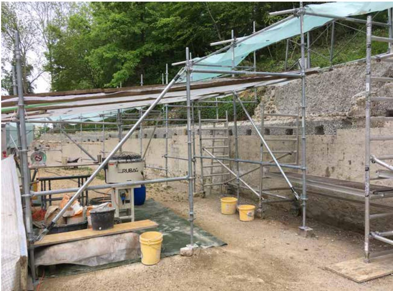
Abb. 5: Augst BL, Amphitheater (Monumentenrestaurierung 905.2021.01). Zum Aufmauern der zu erneuernden Mauerzonen vorbereiteter Mauerzug. Die Löcher im Betonkern dienen zum Einsetzen von einbindenden Handquadern, um eine bessere Verankerung des neuen Schalenmauerwerks zu erlangen.
