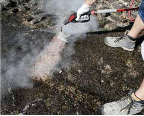
Abb. 32: Kaiseragust AG, Castrum Rauracense (Monumentenrestaurierung 915.2021.01). Auch bei den noch originalen Terrazzoböden im Inneren der Türme erfolgten Reinigungstests mit Heissdampf.
