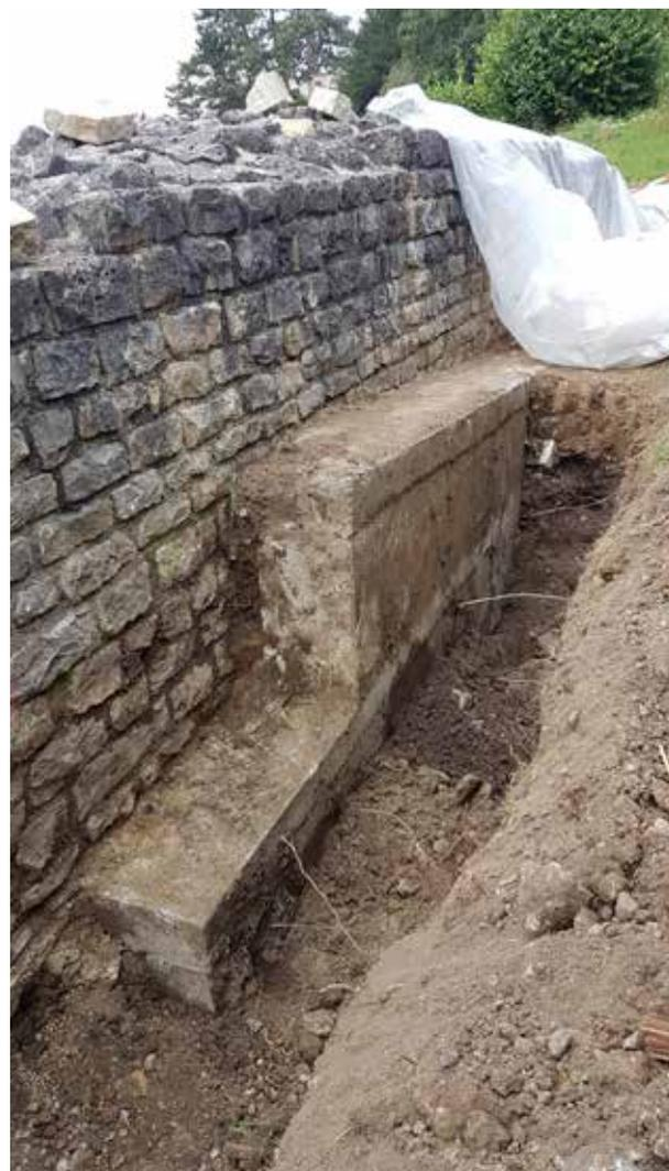
Abb. 28: Augst BL, Taberna (Monumentenrestaurierung 907.2021.01). Eine hangseitige Sondage an der Aussenseite der rückwärtigen Tabernenmauer legte die in den 1960er-Jahren geschaffene Konservierungssituation offen, bei der eine Stahlbetonmauer zur Entlastung vorgeblendet worden war.
