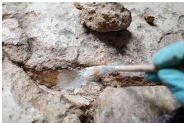
*Abb. 18:* Augst BL, Curia (Monumentenrestaurierung 906.2021.02). Nach sorgfältigem Entfernen der alten Zementrestaurierungen konnten die losen Teile der originalen Schwelle mit Nanokalk wieder angeklebt und die Risse geschlossen werden.
