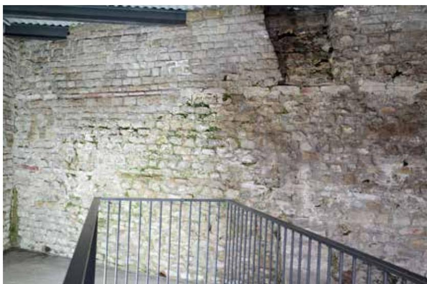
*Abb. 23: Augst BL, Taberna (Monumentenrestaurierung 907.2021.01). Taberna an der Giebenacherstrasse. Notfallmässige Konservierungs- und Konsolidierungsarbeiten an der rückwärtigen Tabernenwand. Die hangseitige Tabernenrückwand zeigte nach schweren Regenfällen im August 2021 eine extrem starke Durchfeuchtung.*
