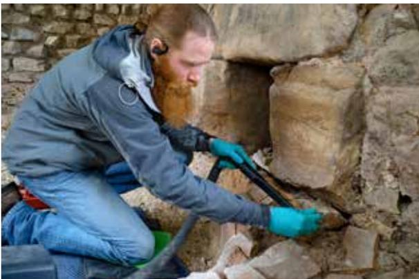
*Abb. 37: Kaiseragust AG, Gewerbehaus Schmidmatt (Monumentenrestaurierung 917.2021.01). Anjo Weichbrodt beim Reinigen der Einfeuerungsöffnung des Hypokausts als Vorbereitung für die nachfolgende Konsolidierung und Klebung der in der Konstruktion verbauten Ziegel.*
