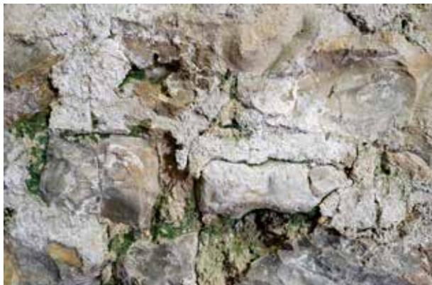
Abb. 25: Augst BL, Taberna (Monumentenrestaurierung 907.2021.01). In der nachfolgenden Abtrocknungsphase kam es zu massiven Salzausblühungen an der Maueroberfläche, sodass eine grossflächige Zerstörung der antiken Originalmörtel zu befürchten war.
