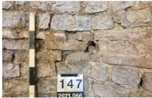
Abb. 19: Augst BL, Curia (Intervention 2021.066). Innenraum, Detailaufnahme des Eckverhältnisses der Ziegelbänder von MR 1m und MR 9. Der Ziegel der mittleren Ziegellage von MR 1m (links) wurde partiell ausgebrochen, um an dieser Stelle das Ziegelband von MR 9 (rechts) einzuzahnen zu können. Wie der Mörtelstopfen an der Ausbruchstelle zeigt, kam es, zumindest auf Ebene der Mauerchalen, aber trotzdem nicht zu einem richtigen Verband, sodass MR 9 hier an MR 1m anstösst.
