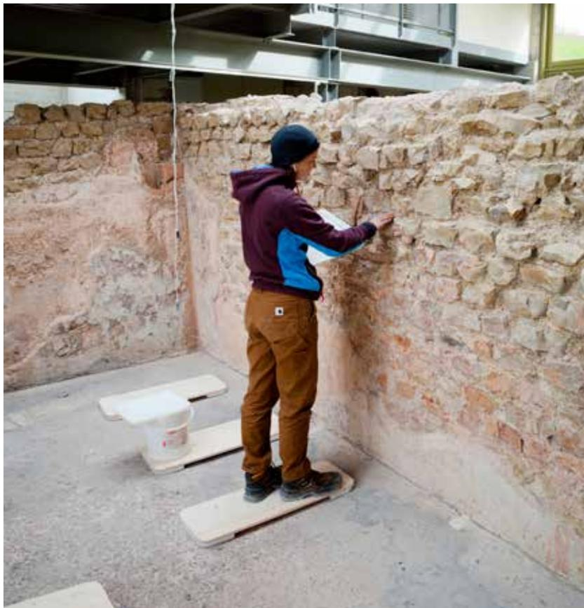
Abb. 35: Kaiseraugst AG, Gewerbehause Schmidmatt (Monumentenrestaurierung 917.2021.01). Konservierung von Wandmalerei und Putzen in den Räumen 2 und 6 (MR 7 und MR 11). Daria Jermann bei der Schadensaufnahme im hypokaustierten Raum 6.
