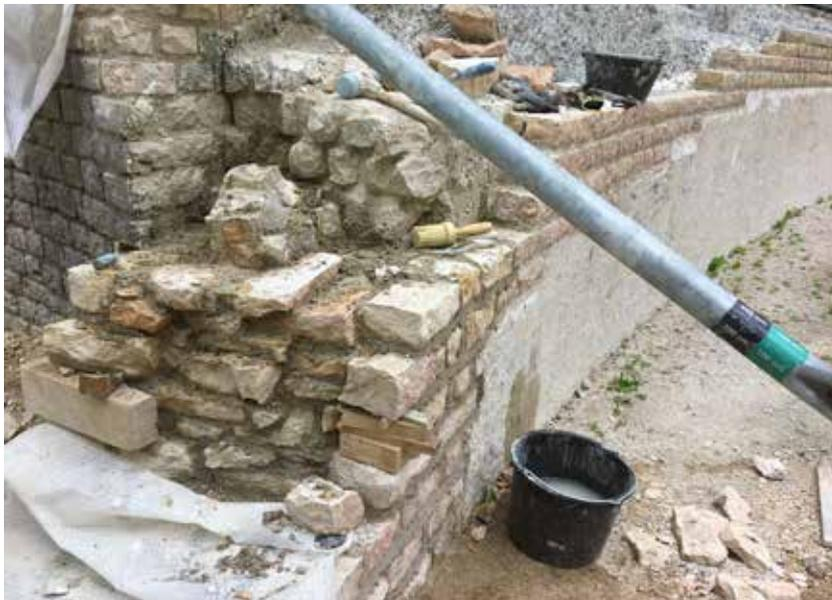
Abb. 8: Augst BL, Amphitheater (Monumentenrestaurierung 905.2021.01). Neu aufgemauert Kernabschluss am Westende. Der Charakter des originalen antiken Mauerkerns soll so gut wie möglich nachempfunden werden.
