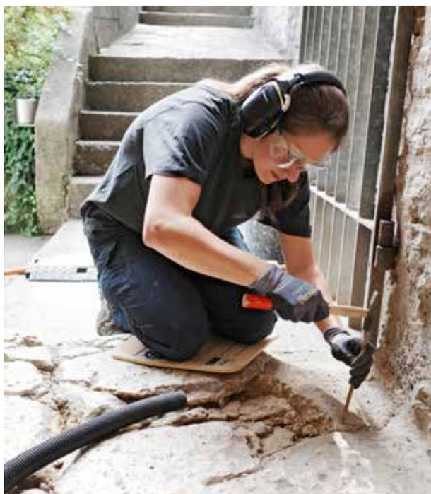
*Abb. 17:* Augst BL, Curia (Monumentenrestaurierung 906.2021.02). Chiara Marcon beim Konservieren der fragilen Kalksteinschwelle. Der alte, zum Teil noch Zement enthaltende Restauriermörtel muss sorgfältig von Hand mit Hammer und Meissel entfernt werden. Darunter kommen die abgelösten und von Rissen durchzogenen Überreste der antiken Originalschwelle zum Vorschein.
