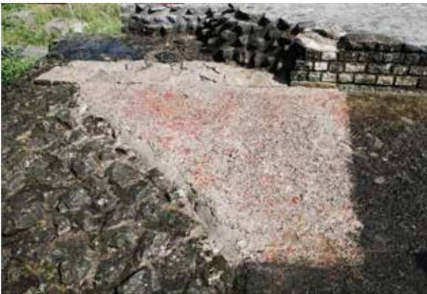
Abb. 33: Kaiseragust AG, Castrum Rauracense (Monumentenrestaurierung 915.2021.01). Im Rahmen der Reinigungstests hat sich gezeigt, dass die originalen Turmböden aus ziegelschrothaltigem Terrazzomörtel noch in erstaunlich gutem Erhaltungszustand sind.
