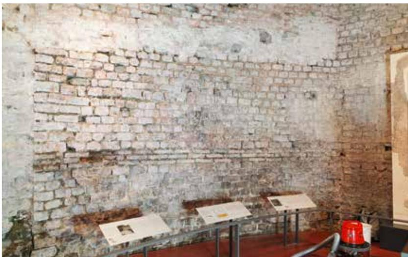
Abb. 20: Augst BL, Curia (Monumentenrestaurierung 906.2021.03). Curia, Reinigung des Innenraums und Entfernen von Actinobakterien (*Rubrobacter*). Die Maueroberflächen der Curia-Innenwände waren grossflächig von einem rötlichen Belag überzogen, der durch den stein-schädigende *Rubrobacter*-Bakterien entstanden ist. Durch Reinigung mit Heissdampf konnte die Bakterien-schicht schonend entfernt werden. Zustand vor der Reinigung.
