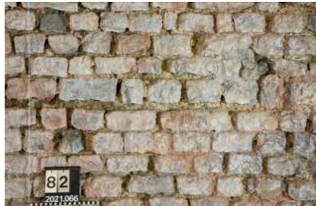
Abb. 16: Augst BL, Curia (Intervention 2021.066). Innenraum, Detailaufnahme der breiten Mörtelfuge (Beilage 1,21) im ursprünglichen Mauerwerk des Tambours MR 1 (hier der Bereich in Abschnitt MR 1m). Die vertikal gespannte Schnur entspricht der Mittelachse HP 17 (Beilage 1) von Stützpfiler MR 10.
