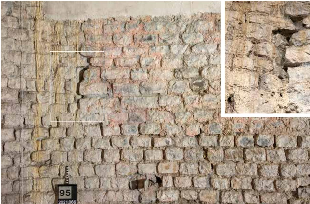
Abb. 28: Augst BL, Curia (Intervention 2021.066). Innenraum, Blick von Osten an die vertikale fünfflagige Baufuge mit der abgeknickten, schräg hinter die Tambourmauer MR 1 ziehenden jüngeren Basilicastützmauer im Abschnitt MR 1a (Beilage 1,41). Baubefund im Mauerkontext und Detailauszug (Bildausschnitt rechts) mit der umgebenden Basilicastützmauer und dem nachträglich daran angefügten oberen Bereich der Tambourmauer MR 1.
