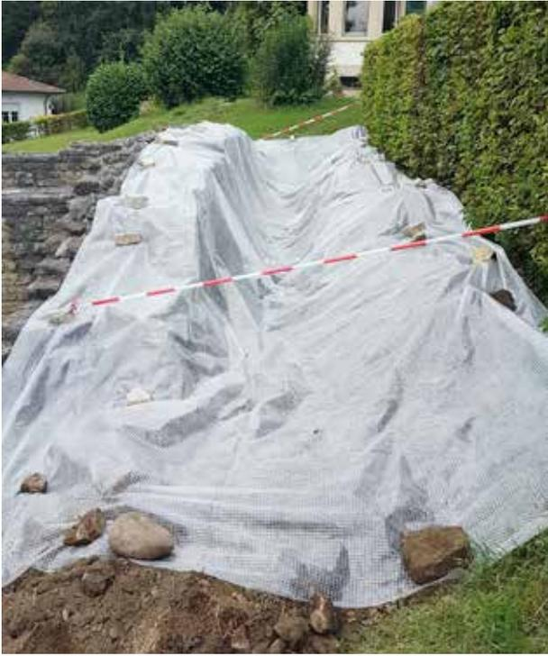
Abb. 29: Augst BL, Taberna (Monumentenrestaurierung 907.2021.01). Der Wasserfluss direkt hinter der Mauer muss zukünftig minimiert werden. Erste Tests haben gezeigt, dass eine grossflächige Abdichtung rund um den Baubefund herum die nötige Effizienz bringt, sodass massiv weniger Wasser in die antike Mauer einsickert. Die Arbeiten werden 2022 fortgesetzt; in dem Zusammenhang ist das Einlegen einer Dichtungsfolie hinter der Mauer vorgesehen.
