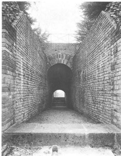
Fig. 54. Troisième théâtre, vomitorium 3, avec couverture complétée. Vue du sud-est.
