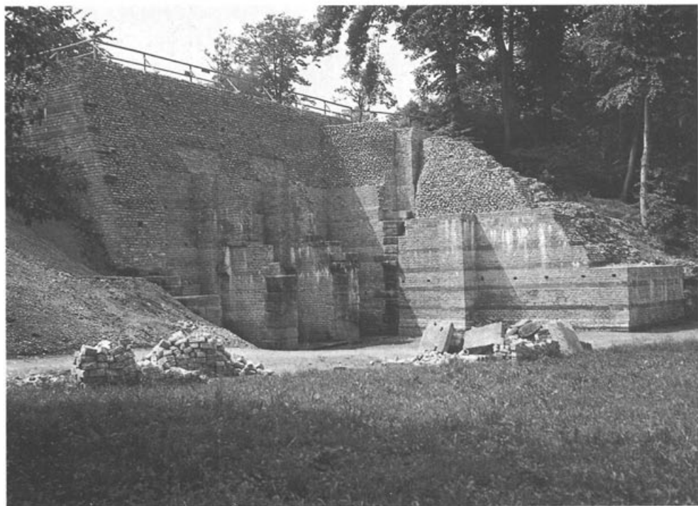
Fig. 74. Schönbühl, piliers du mur de soutènement avec leurs bossages.
