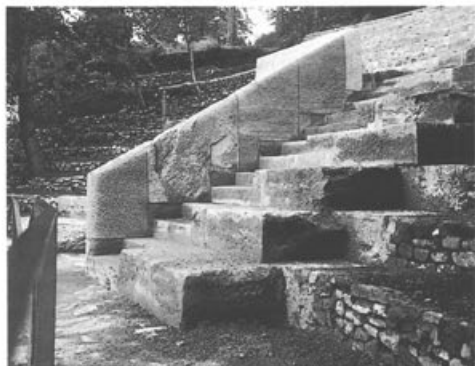
Fig. 52. Troisième théâtre, 2e rangée. Parapet près du vomitorium 3. Vue du sud-ouest.
