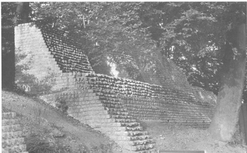
Fig. 65. Amphithéâtre, entrée ouest. Mur de soutènement sud avec arcs de décharge. Vue du nord-est.
