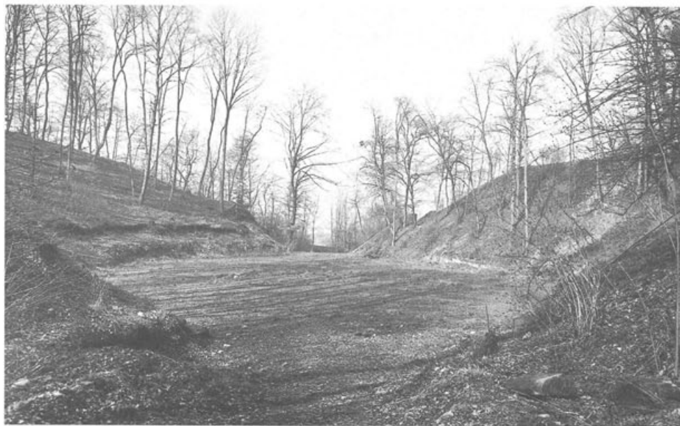
Fig. 66. Amphithéâtre, état de l'arène vers 1960. Vue du sud-est.
