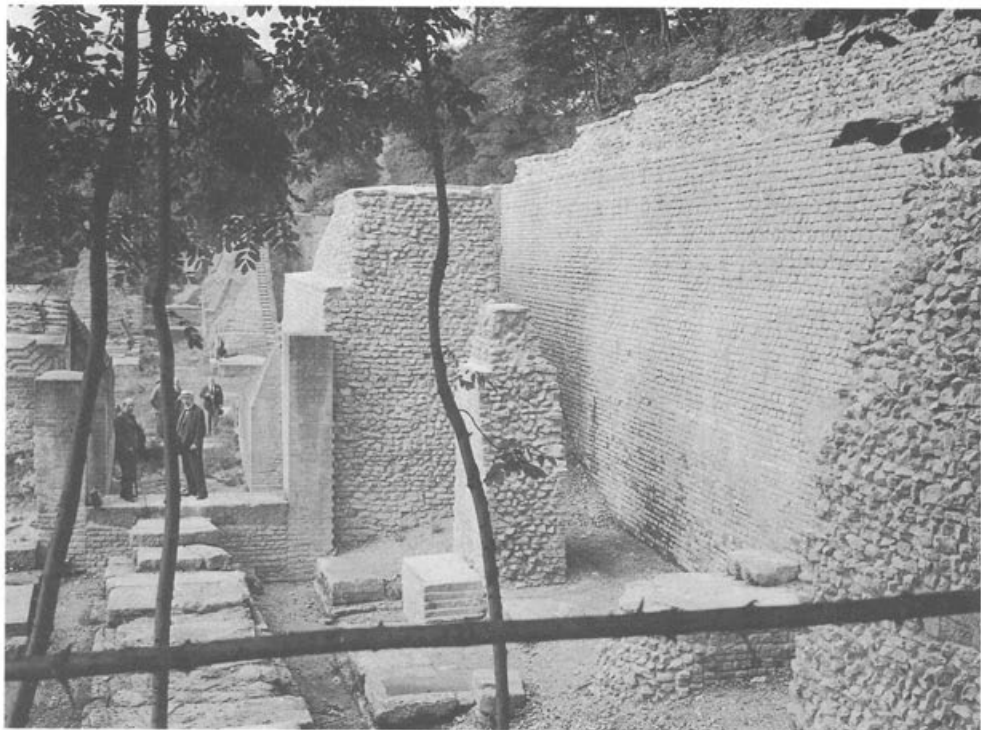
Fig. 56. Troisième théâtre, aile sud avec cage d'escalier, restaurée en 1936. Vue du sud.
