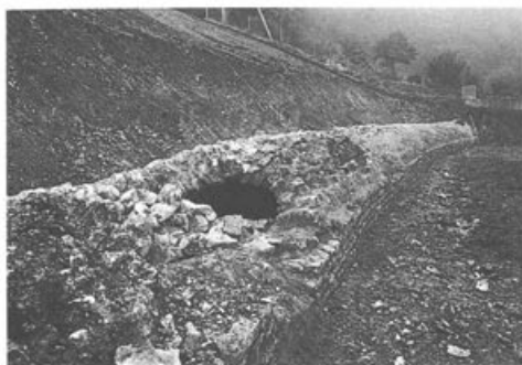
Fig. 164. Liestal, Sonnhalde: aqueduc menant à Augst. Fouille 1971. Aujourd'hui détruit.
