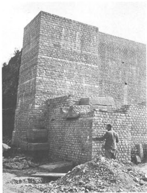
Fig. 44. Basilique. Angle nord du mur de soutènement, reconstruit. Vue du nord.
