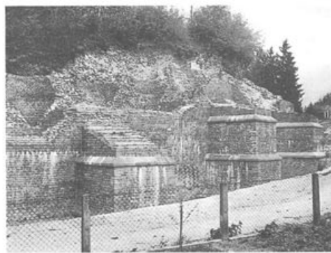
Fig. 55. Troisième théâtre, mur périphérique sud, avec piliers de soutènement. Vue du sud.
